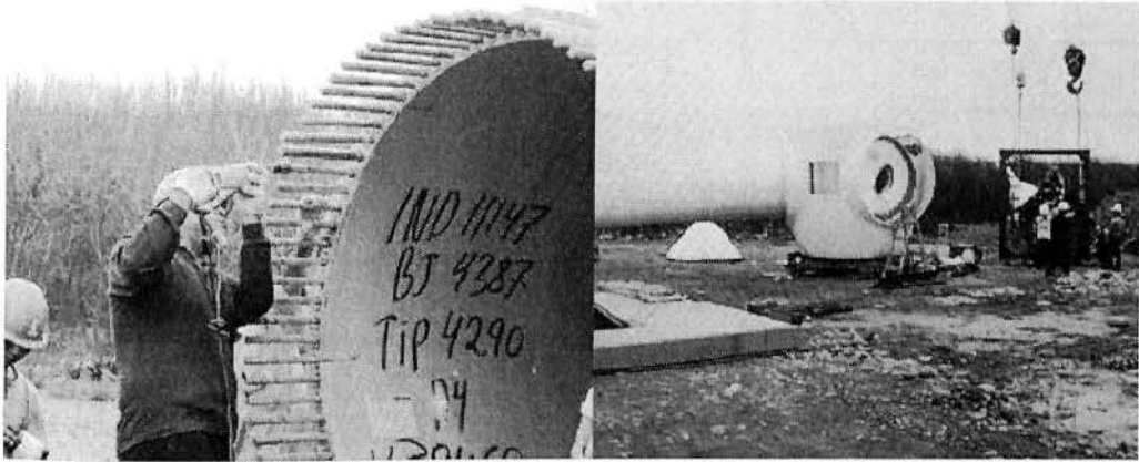
Εικόνα 24 Εργασίες εγκατάστασης ρότορα ανεμογεννήτριας Vestas V80 (2MW)
