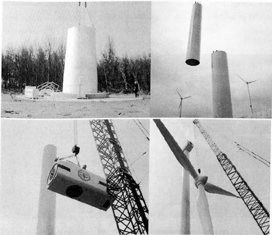
Εικόνα 15 Vestas V80 σύνδεση τμημάτων ανεμογεννήτριας
