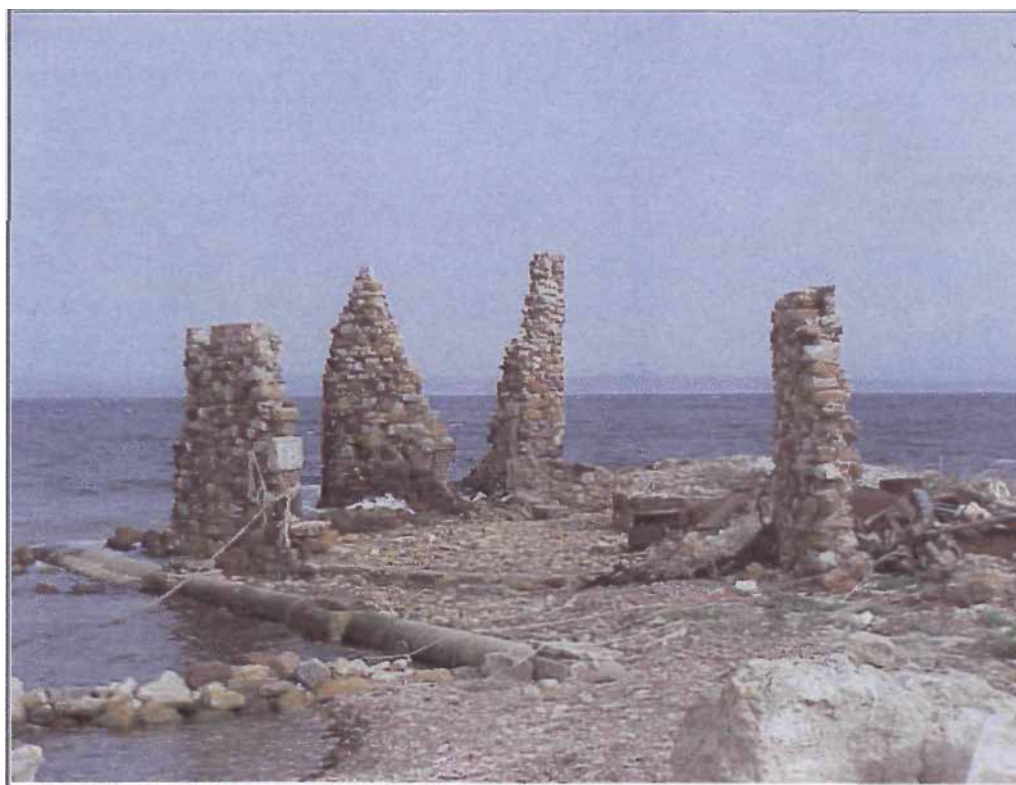
Ερείπια μύλου (5). Πλήρης η κατάληψη από τη θάλασσα. Είναι σχεδόν αδύνατη η επισκευή του.
