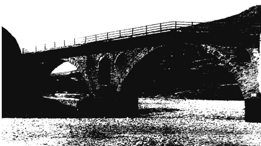
Το γεφύρι της Σαρακήνας Καλαμπάκας. Τμήμα των δύο πρώτων ανοιγμάτων. Συνδυασμός ημικυκλικών τόξων με ψαλιδωτές κύριες παραθυρίδες και τεταρτοκυκλικές δευτερεύουσες.
