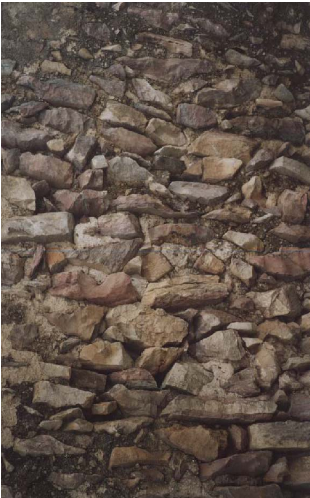
Εσωτερική φωτογραφία καμάρας. Κατασκευή από «ρετάλια».
