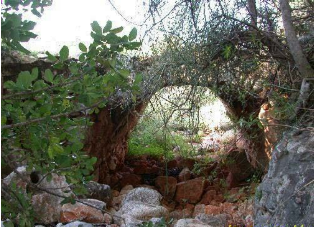
Πίσω πλευρά γεφυριού.
