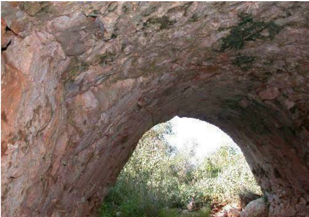
Εσωτερική εικόνα γεφυριού – καμάρα.
