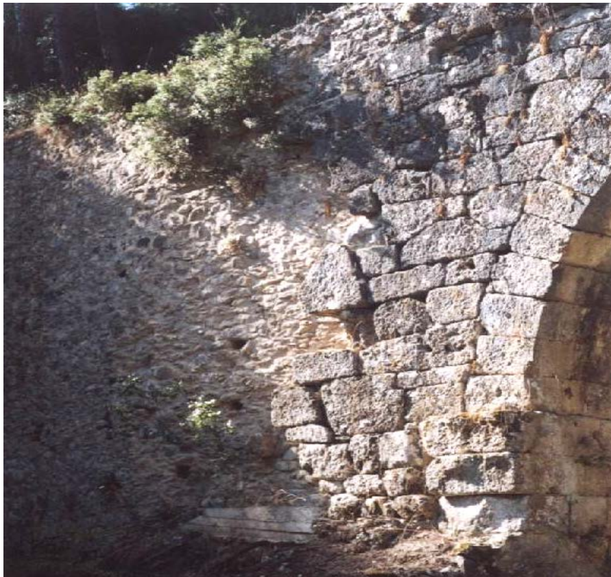
Λεπτομέρεια καμάρας γεφυριού.
