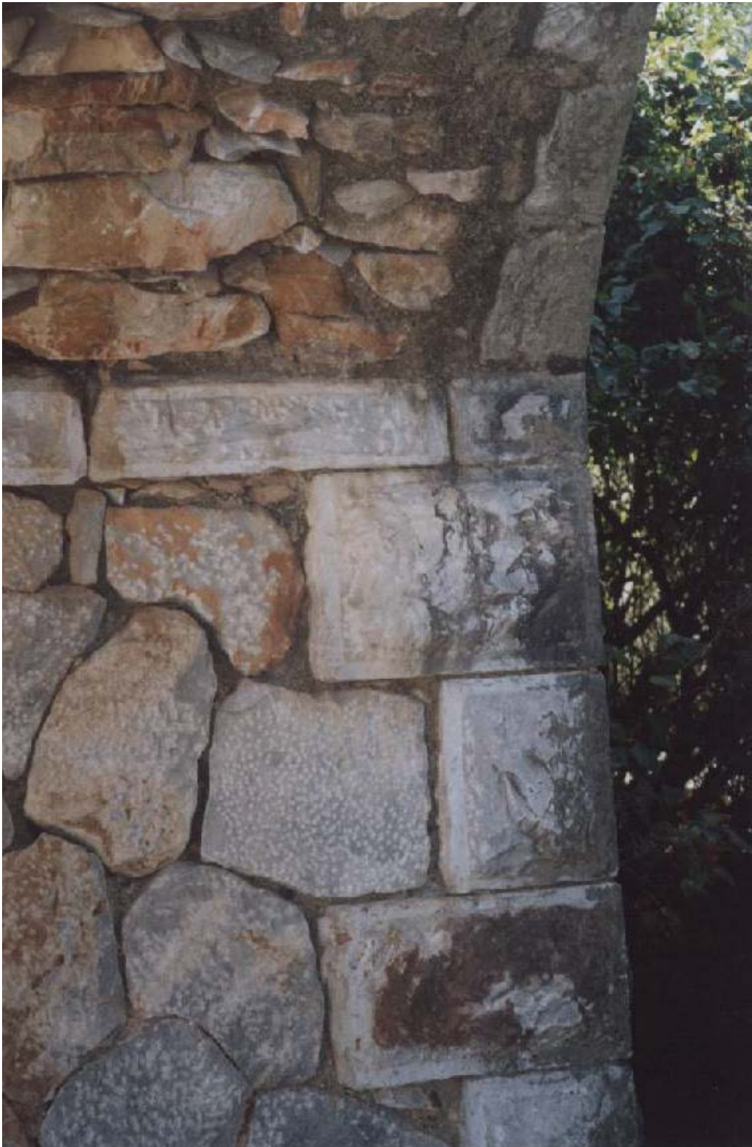
Λεπτομαΐρια κατασκευής εσωτερικά της καμάρας.
