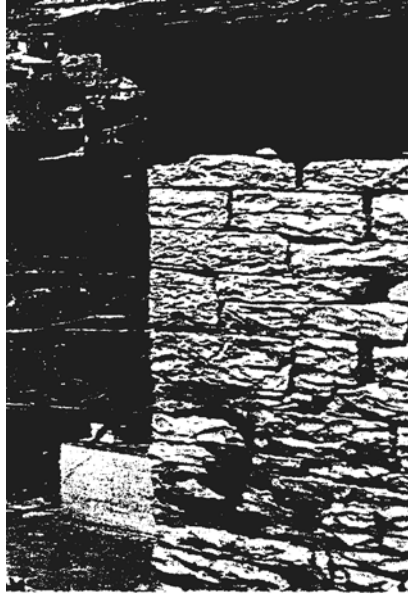
Τοίχοι από ημιλάξευτους λίθους. Η γωνία είναι διαφοροποιημένη με αγκωνάρια
