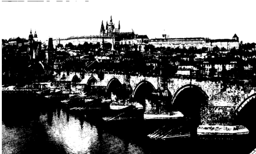
Πράγα, το γεφύρι του Καρόλου με τα ισχυρότατα βάθρα – προβόλους και πρόσθετες ξυλοκατασκευές πριν απ' αυτά, ίσως για προστασία τους από τους πάγους.
