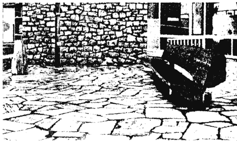
Πλακόστρωση αυλής με σχιστολιθικές πλάκες
