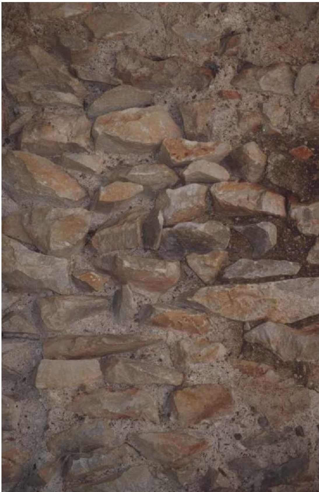
Εσωτερικά η καμάρα του γεφυριού κατασκευασμένη από ρετάλια.
