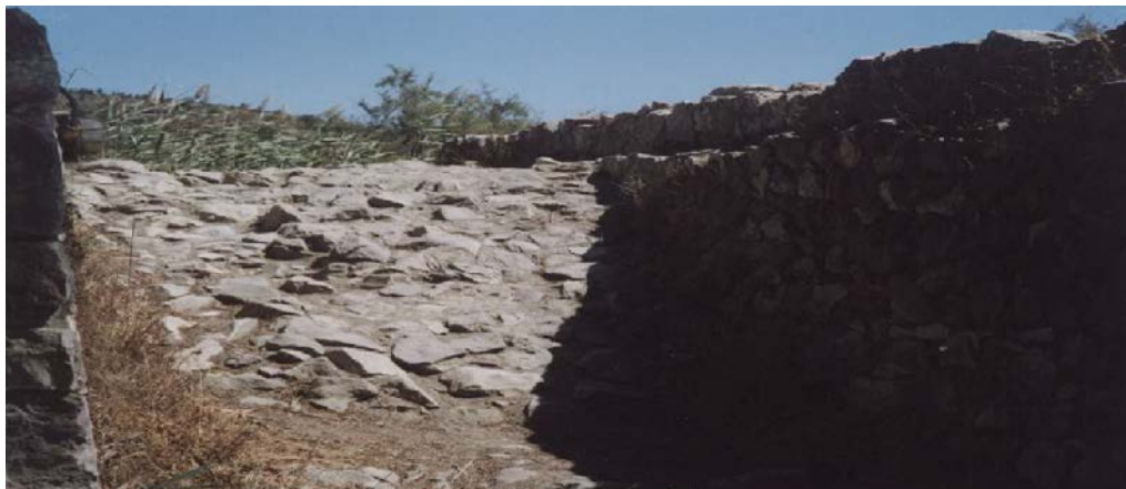
Πέτρινο μονοπάτι γεφυριού
