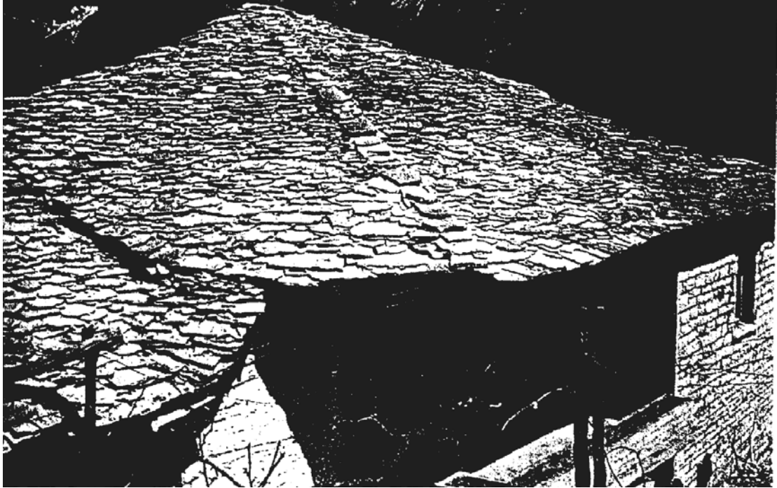
Στέγαση σπιτιών στο Πήλιο με πλάκες από μαρμαρυγιακό σχιστόλιθο
