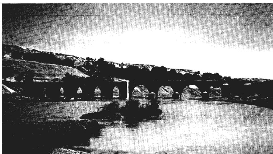
Το βυζαντινό γεφύρι της Αμίδης χτισμένο από μαύροβασάλτη. Η έλλειψη ανακουφιστικών ανοιγμάτων το καθιστά βαρύ, παρά τα ψαλιδωτά του τόξα.
