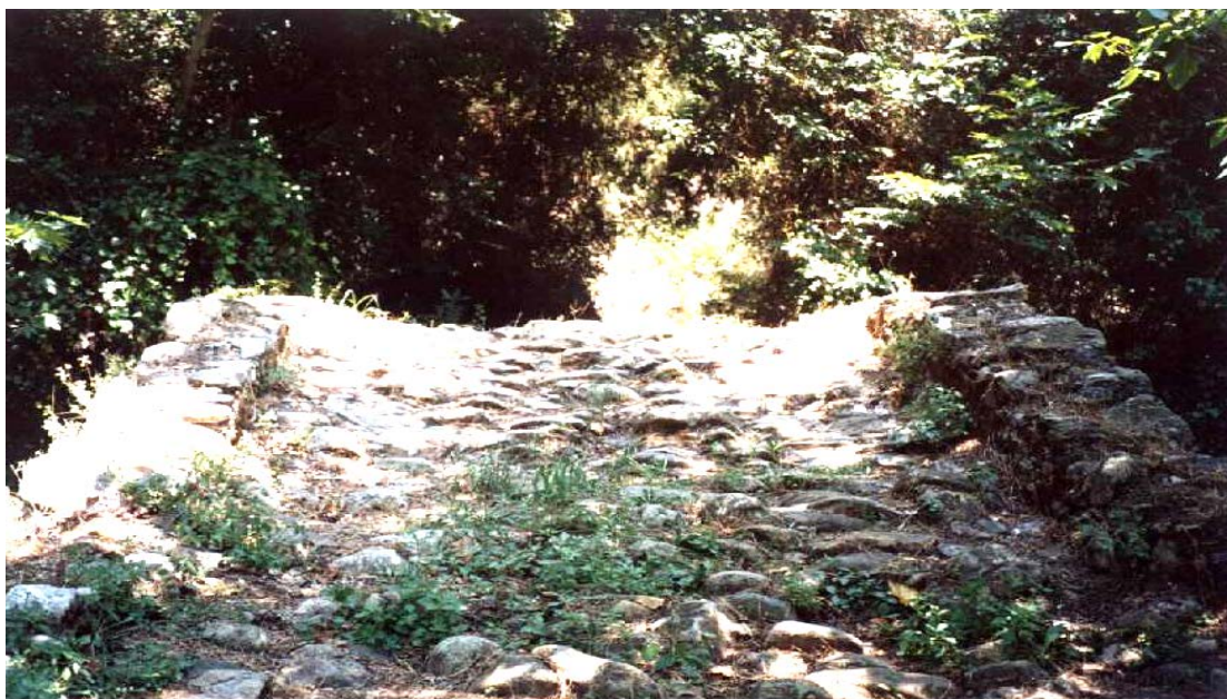
Πέτρινο μονοπάτι γεφυριού
