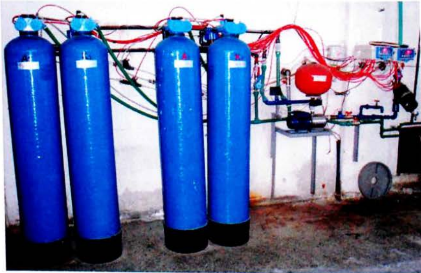
ΕΙΚΟΝΑ 5.12: Αυτόματοι απιονιστές της Ελληνικής εταιρείας hydortech με δυνατότητα παραγωγής 600 \text{ m}^3 ανά ώρα.
