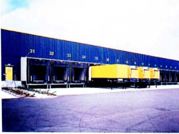
ΕΙΚΟΝΑ 5.4: Εξωτερικοί σταθμοί φόρτωσης.
