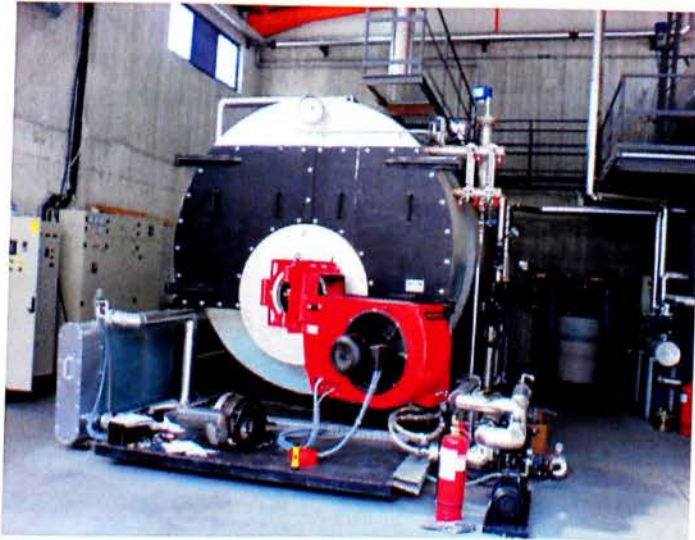
ΕΙΚΟΝΑ 5.16: Ατμολέβητας αεριαυλωτός, τριπλής διαδρομής καυσαερίων της εταιρείας thermosol.
