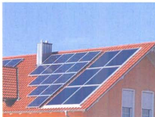
Ενσωμάτωση φωτοβολταϊκού σε στέγη απόδοσης μέχρι 10 kW
