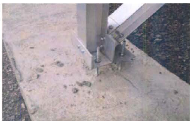
Πέδιλο από σκυρόδεμα και τοποθέτηση βάσεων
