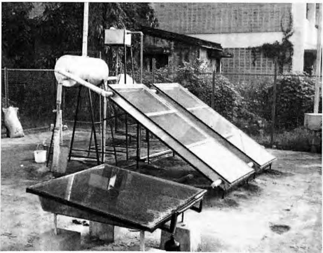
ΤΟΠΟΘΕΤΗΣΗ ΗΛΙΑΚΟΥ ΑΠΟΣΤΑΚΤΗΡΑ ΣΕ ΣΠΙΤΙ ΔΙΠΛΑ ΑΠΟ ΤΗΝ ΕΓΚΑΤΑΣΤΑΣΗ ΤΟΥ ΗΛΙΑΚΟΥ ΘΕΜΟΣΙΦΩΝΑ
