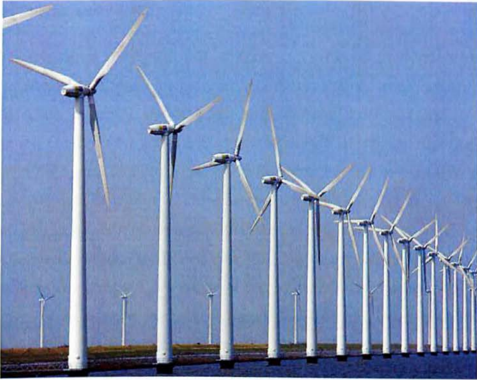
Σχήμα 1.5.4 Ανεμογεννήτριες με χαλύβδινους σωληνοειδείς πύργους
