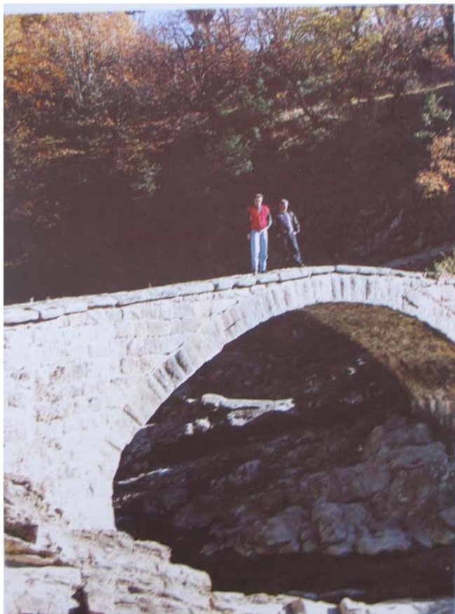
34. Στο Νιδρούζι με εμφανή τη σύγκριση των διαστάσεων των λίθων σε σχέση με το ανθρώπινο ύψος.
