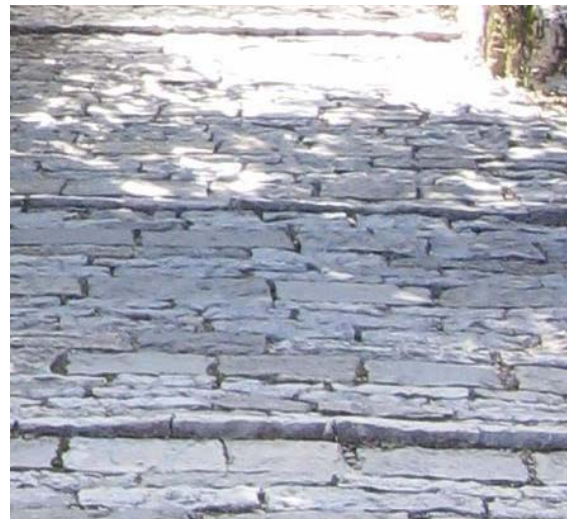
83. Επιθυμητό αποτέλεσμα μετά την αποκατάσταση.
