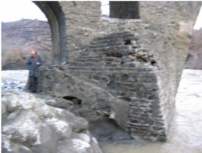
71. Σηγήθεις ζημιές των βάθρων που προκαλούνται από τις χειμερινές πλημμυρίδες
