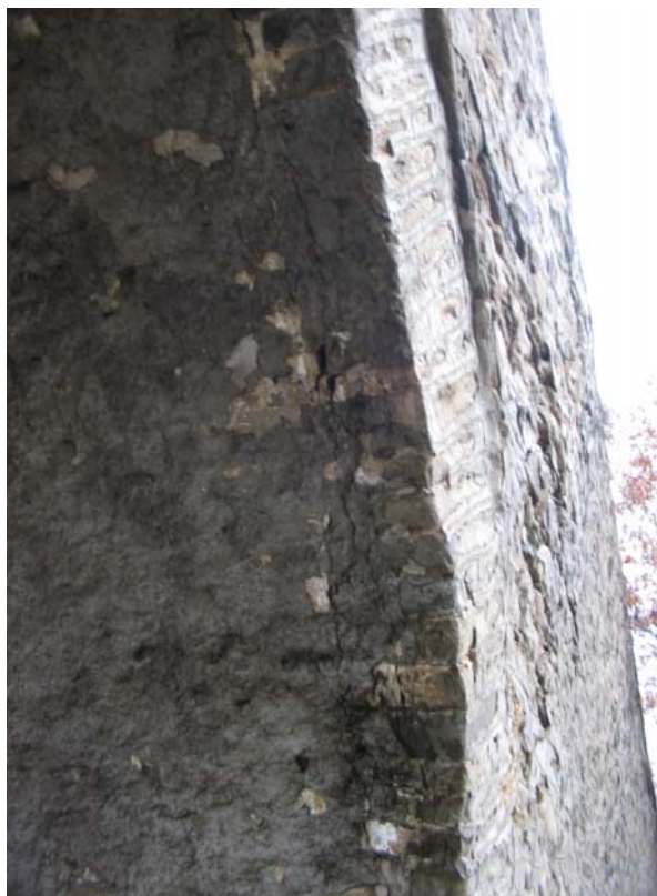
75. Διαμήκη ρηγμάτωση στην παρειά του τόξου
