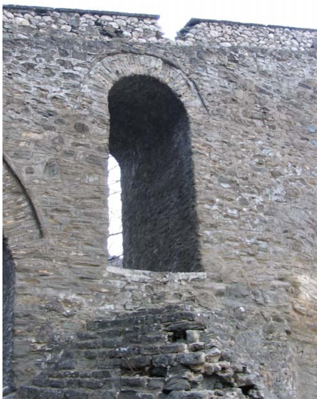
74. Ελλειπείς και αποδιοργανωμένοι λίθοι στην κορυφή των αν. τριγώνων.
