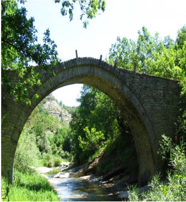
5. Ακτινωτό στηθαίο στη γέφυρα του Κάστρου
