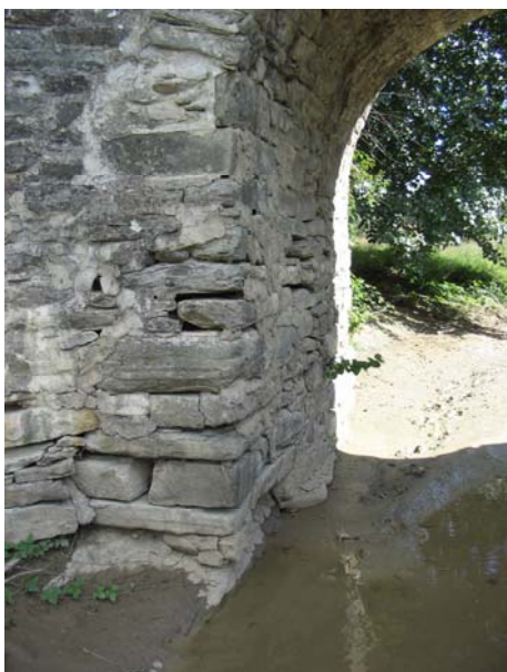
77-78 Πλήρης αποσάθρωση κονιάματος στη βάση και την κορυφή στην κορυφή του τόξου
