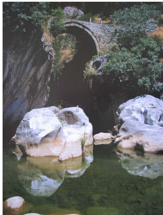
29. Η νότια όψη του γεφυριού της Λιάτιστας, ένα από τα σπάνιας ομορφιάς τοπία της περιοχής.
