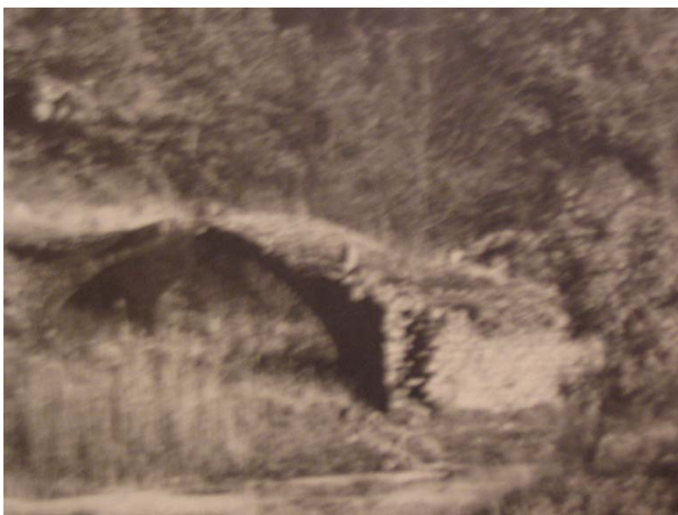
43. Το γεφύρι του Αγίου Κοσμά, πνιγόμενο και σε κακή κατάσταση.
