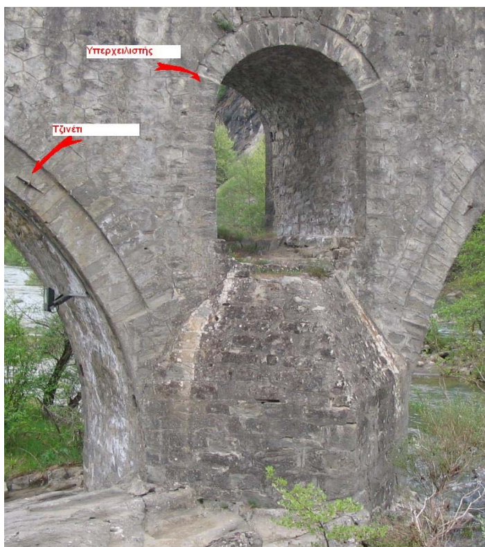
4. Μορφή υπερχειλιστή και χρήση τζινετιού.
