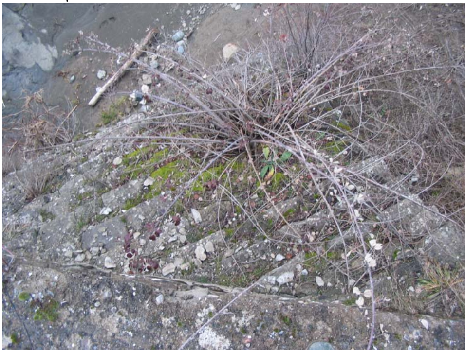
84. Θάμνοι και που έχουν ενσωματώσει το ριζικό τους σύστημα στο λιθόσωμα της γεφύρας.
