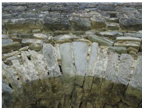
77-78 Πλήρης αποσάθρωση κονιάματος στη βάση και την κορυφή στην κορυφή του τόξου
