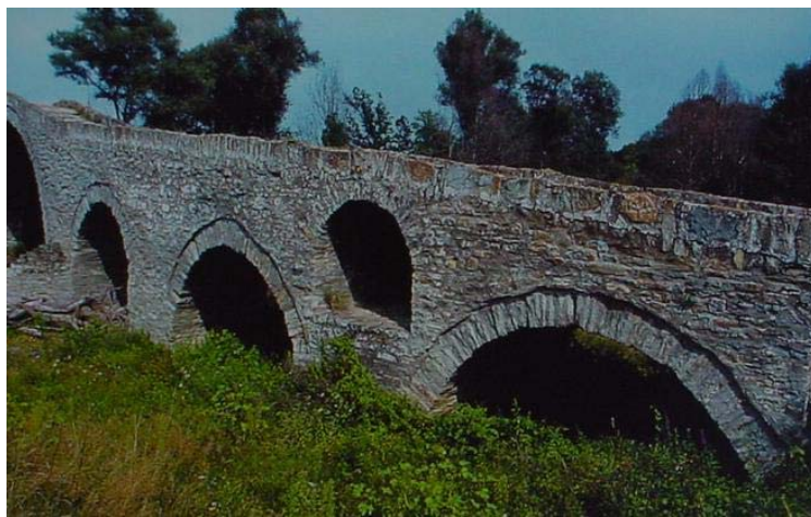
44. Η νοτιοδυτική άποψη του γεφυριού. Φαίνονται τα πέτρινα στηθαία και η επισκευασμένες λιθοδομές που έγιναν σύμφωνα με την παραδοσιακή αρχιτεκτονική του γεφυριού.
