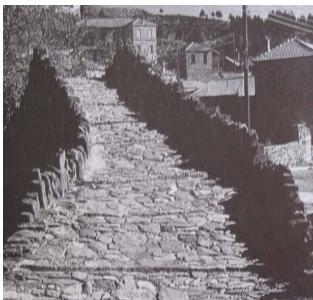
35. Η νέα λιθόστρωση του οδοστρώματος και το παλαιό στηθαίο από σχιστόλιθους.
