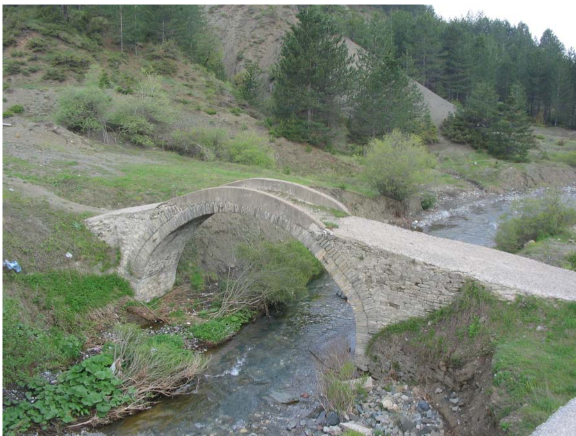
39. Το μικρό μονότοξο γεφύρι του Ματσαγκάνη στο χιονισμένο τοπίο (υψόμετρο 900μ.) της Πίνδου.
