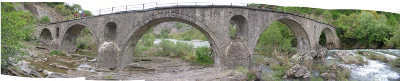
16. Πλήρη η δυτική όψη του γεφυριού
