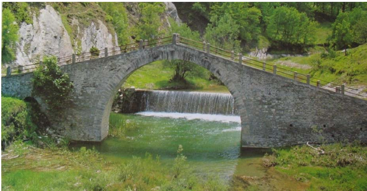
42. Ανατολική άποψη του γεφυριού, με φόντο το μικρό καταρράκτη που φτιάχτηκε λίγα χρόνια αργότερα για να περιορίζει τη ροή του νερού και να διακόπτει τους στροβιλισμούς κοντά στα βάθρα.
