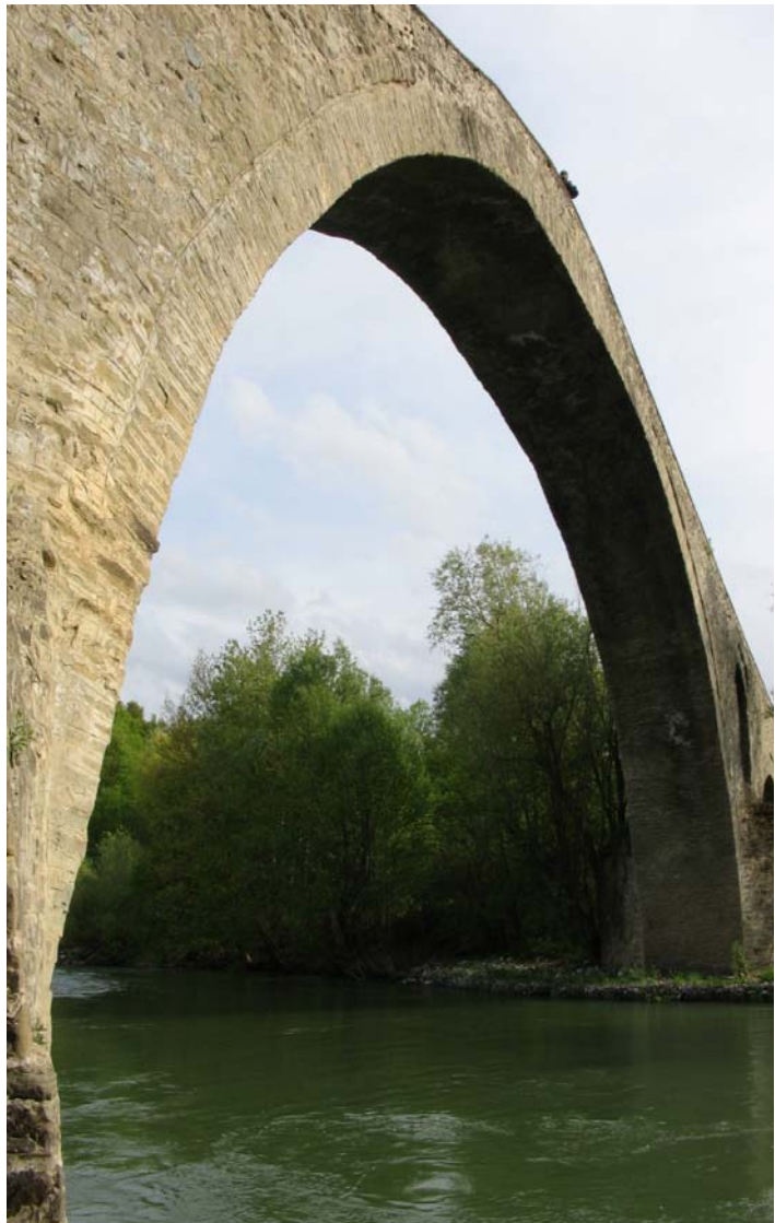
2. Τόξο. Το βασικό κατασκευαστικό χαρακτηριστικό των γεφυριών της εποχής
