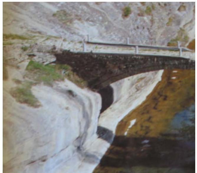
7. Χαρακτηριστικό δείγμα τέτοιας ικανότητας και ευρηματικότητας είναι το γεφύρι της Σβόλιανης, όπου ακουμπά τη μια του άκρη στη βραχώδη πλαγιά.
