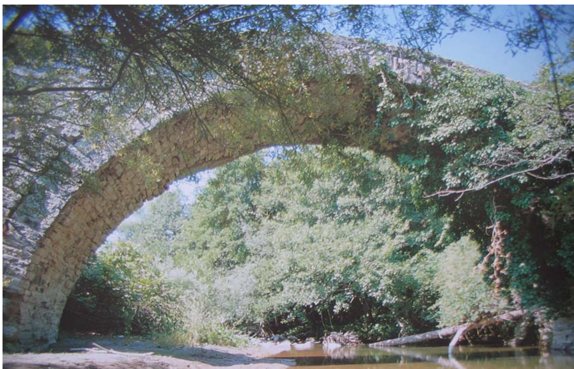
40. Το γεφύρι δίπλα στον νερόμυλο του Σταμπέκη, από τον οποίο πήρε και το όνομά του.
