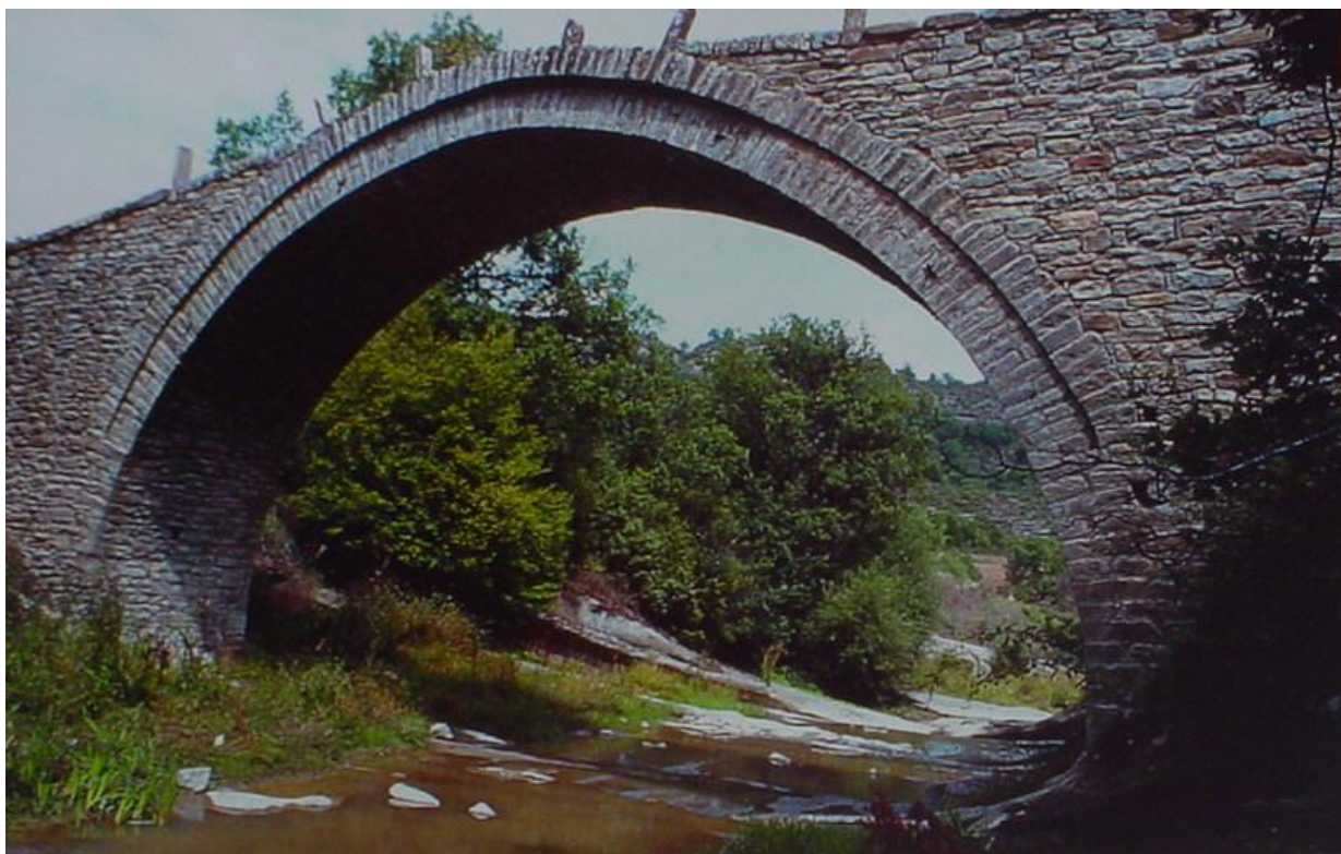
38. Το τέλειο ημικυκλικό σχήμα του μονότοξου γεφυριού Καστρού –Μεγάρου μετά τις σωστικές εργασίες (όπως φαίνεται από βορά).
