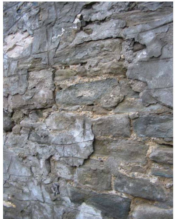
72-73. Υποβάθμιση των λίθων και των αρμολογημάτων από τον παγετό.
