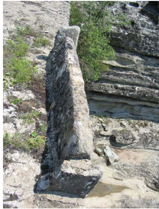
6. Συνθέτη κατασκευή στηθαίου στη γέφυρα της Χρυσανγής, αποτελούμενο από σφηνωμένους ορθοστάτες και ανάμεσά τους τραβέρσες.
