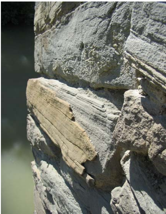
72-73. Υποβάθμιση των λίθων και των αρμολογημάτων από τον παγετό.
