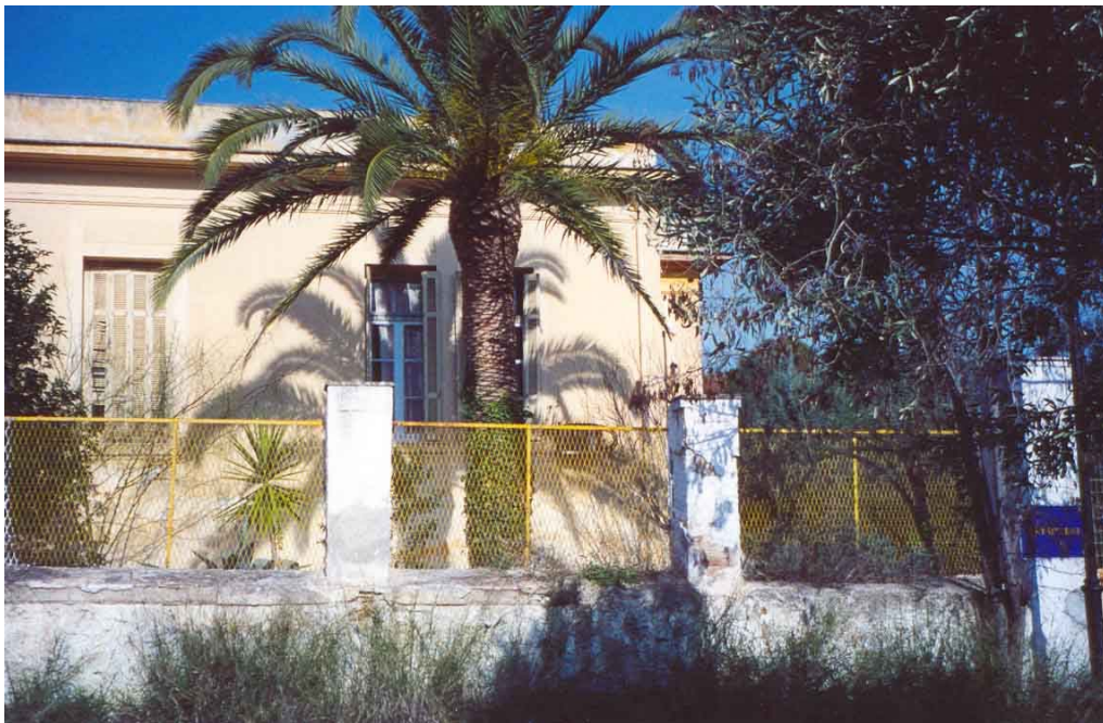
Εικ. 4: Σκυλίτσειο. Κτίριο του 1928, δεν χρησιμοποιείται πια.
