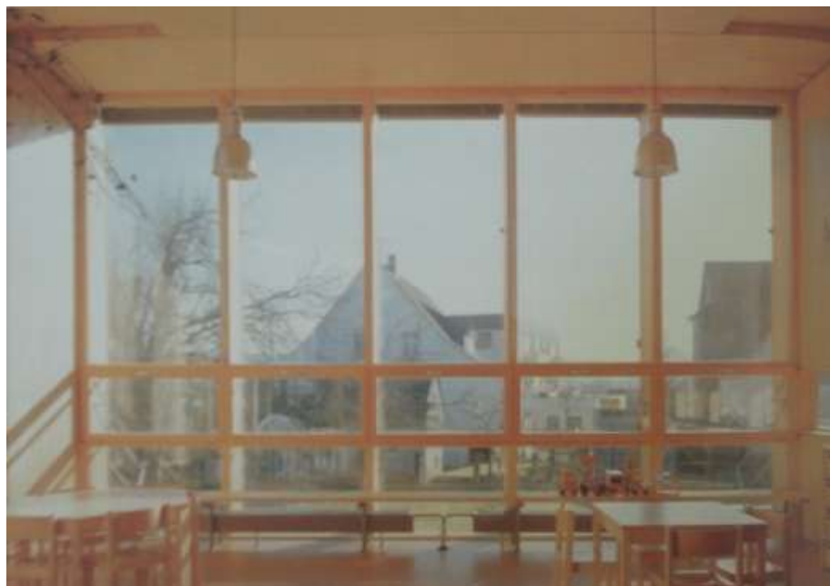
Εικόνα 31. Το νηπιαγωγείο του Pliezhause. Η νότια πρόσοψη των τάξεων αποτελείται από διπλοκέλυφο υαλοστάσιο.
