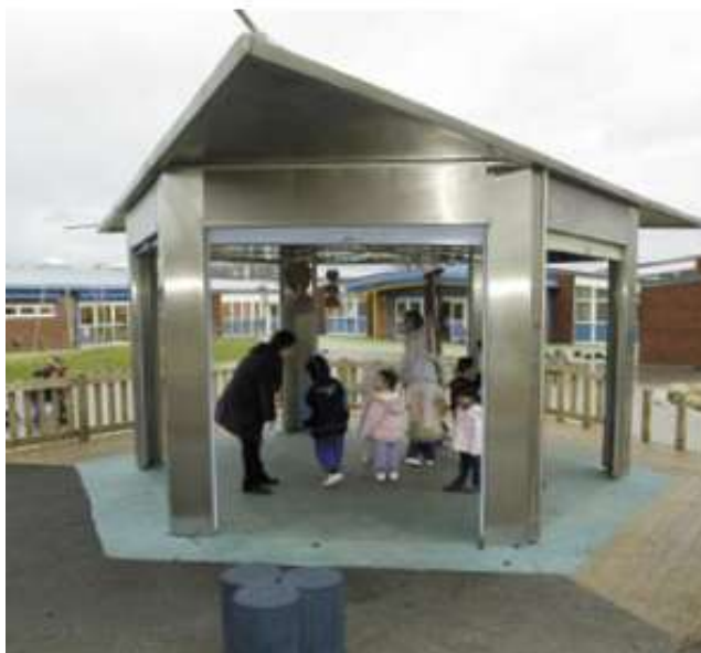
Εικόνα 32. Μοντέρνο σκέπαστρο στον υπαίθριο χώρο του νηπιαγωγείου του Hampshire.
