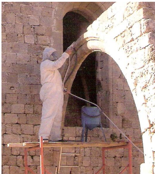
Εικόνα 6.40 Καθαρισμός των λιθοδομών με ψηγματοβολή
