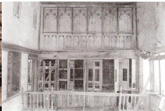
Εικόνα 4.19 Μουσάντρα – Είδος Οθωμανικού Διαχωριστικού τοίχου
