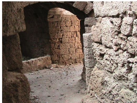
Εικόνα 4.2 Κατασκευή από ασβεστόλιθο
