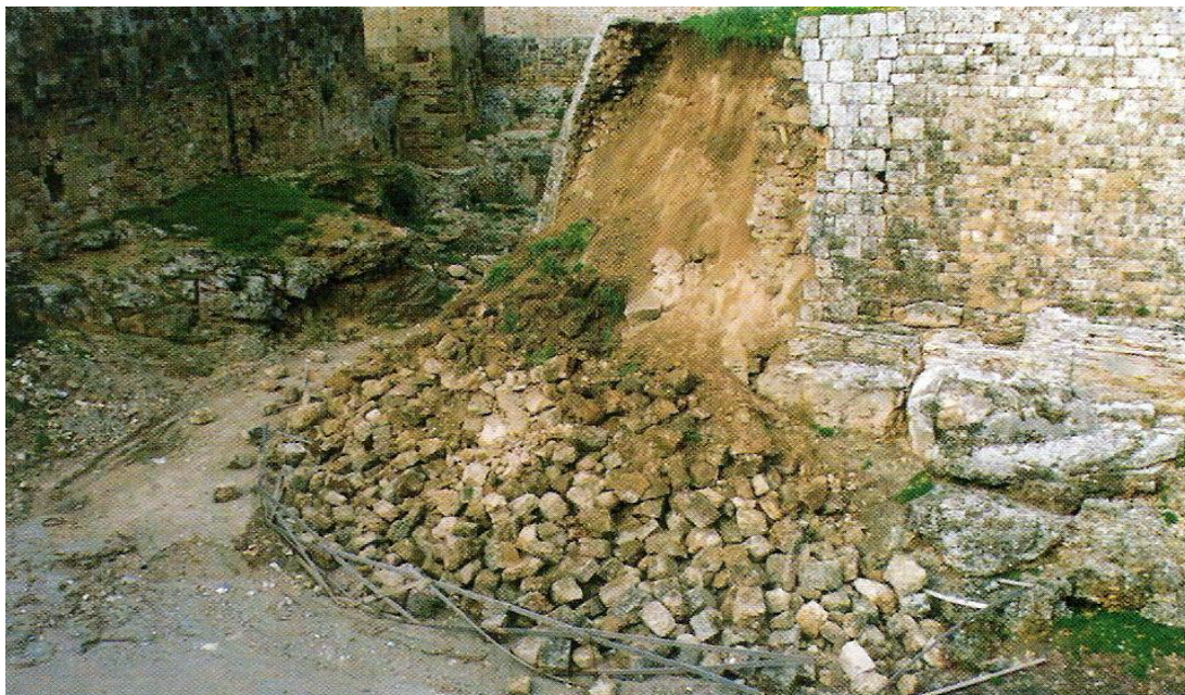
Εικόνα 6.2 Η κατάρρευση του δυτικού άκρου του προχώματος της Αγγλίας τον Φεβρουάριο του 1998
