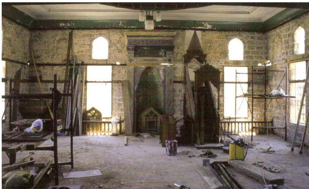
6.24 Εσωτερική άποψη κατά τη διάρκεια των εργασιών
