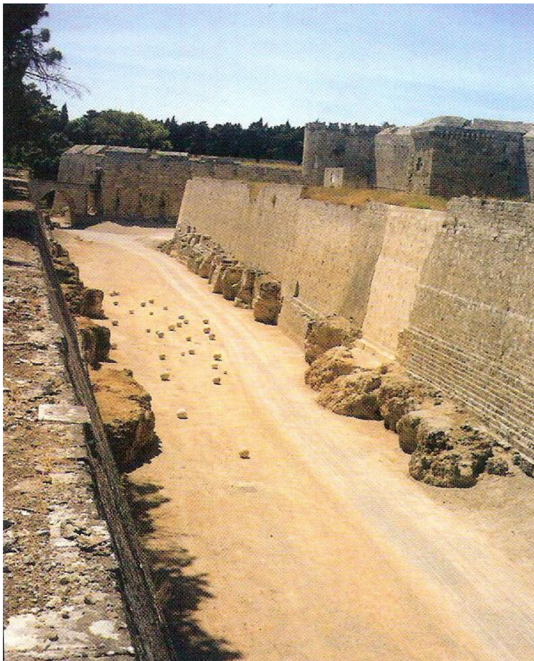
Εικόνα 6.13 Γενική άποψη των σημερινών συνθηκών θεμελίωσης του προχώματος της Αγγλίας
