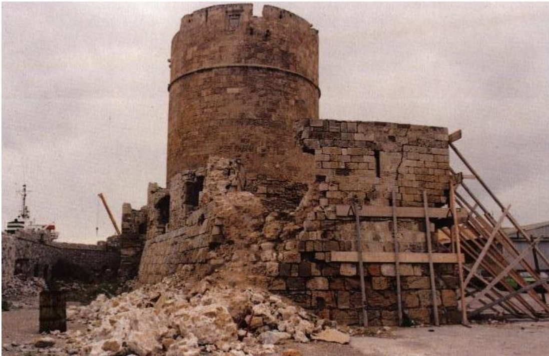
Εικόνα 3.26 Ο Μόλος των Μύλων κατά την διάρκεια των επισκευών
