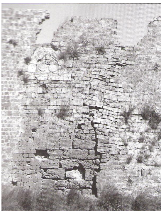
Εικόνα 6.11 Προβληματικό τμήμα ανατολικά του προχώματος της Αγγλίας
