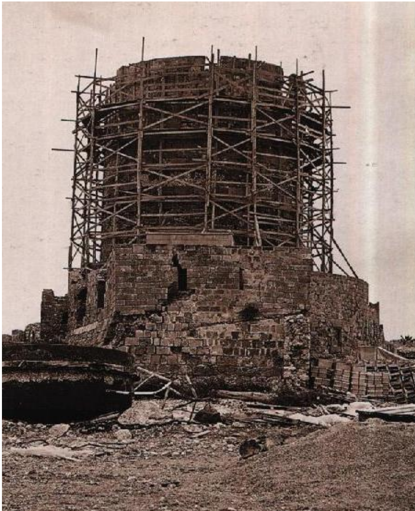
Εικόνα 3.12 Ο πύργος των Μύλων κατά την διάρκεια των εργασιών αποκατάστασης τη δεκαετία του 1970
