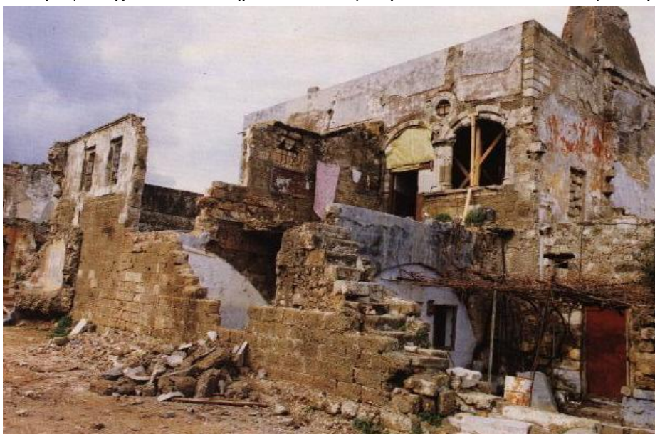
Εικόνα 6.51 Όψη του Ξενώνα πριν τις εργασίες αναστήλωσης
