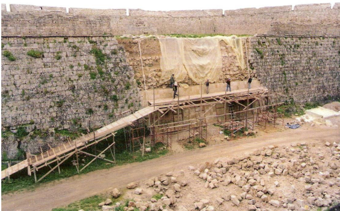
Εικόνα 6.5 Το Πρόχωμα της Ισπανίας κατά τη διάρκεια της ανακατασκευής του καταρρεύσαντος τμήματος
