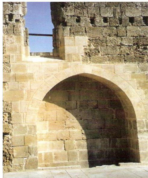
Εικόνα 6.41 Η κόγχη του δυτικού αρκοσολίου της βόρειας πλευράς μετά τις εργασίες
