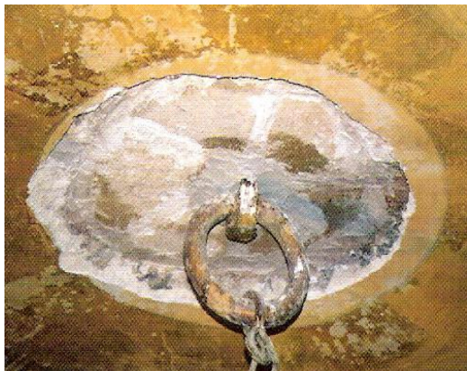
Εικόνα 6.31 Αποκατάσταση κλειδιού του κεντρικού τρούλου
