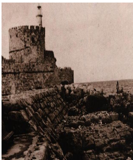
Εικόνα 3.10 Η ανατολική πλευρά του φρουρίου του Αγ. Νικολάου πριν τα σωστικά μέτρα
