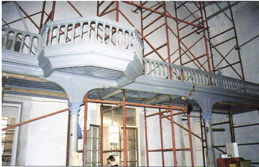
Εικόνα 6.33 Το ξύλινο πατάρι πριν τις εργασίες
