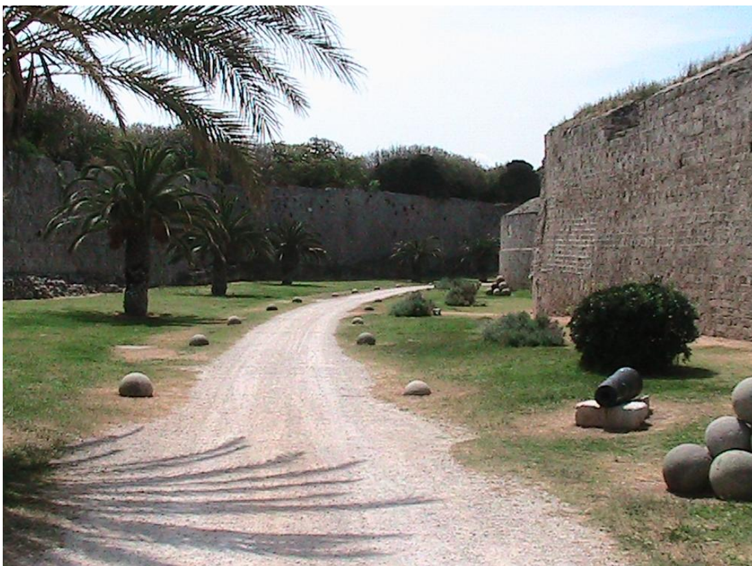
Εικόνα 3.20 Γενική άποψη του χώρου της μεσαιωνικής τάφρου μετά την ολοκλήρωση των εργασιών διαμόρφωσης
