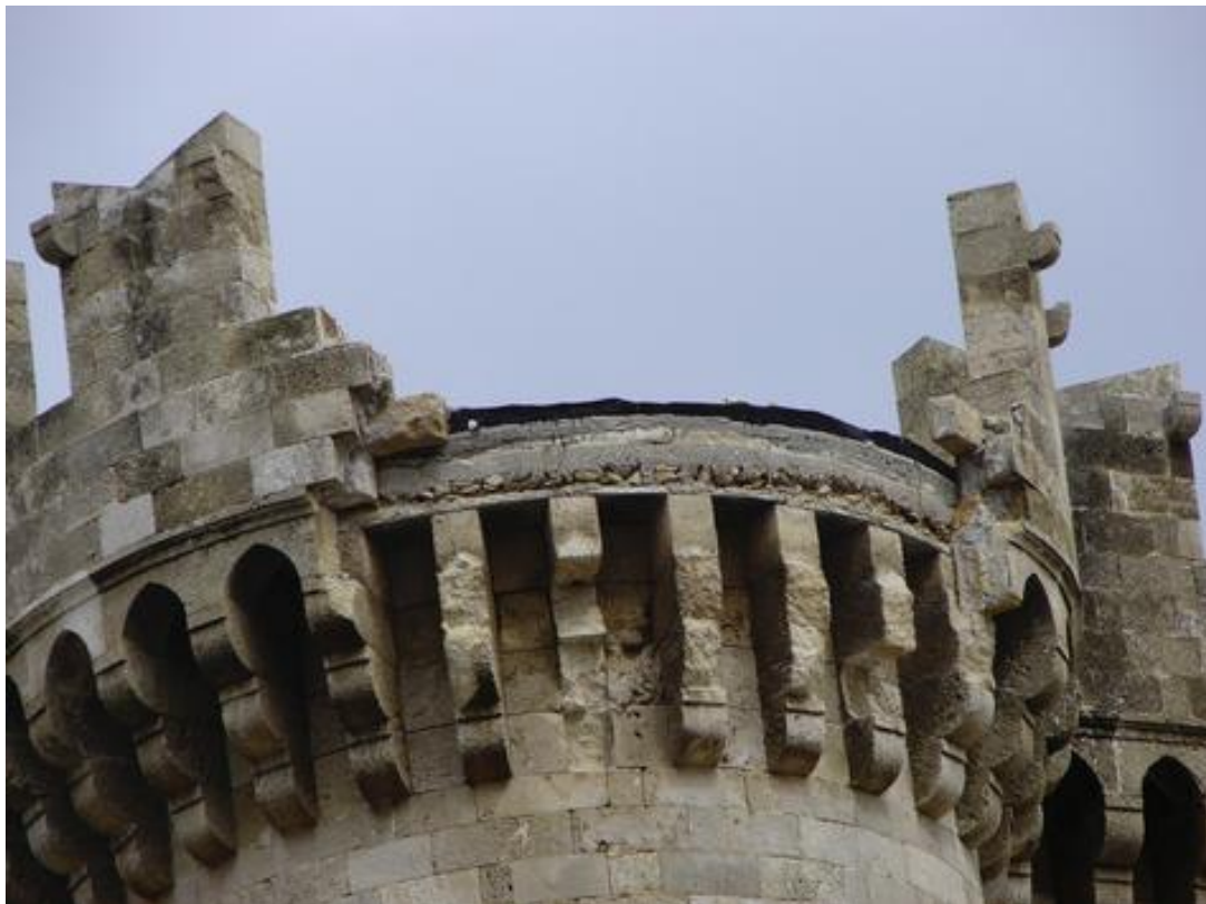
Εικόνα 7.8 Το μέρος του κάστρου που κατέρρευσε
