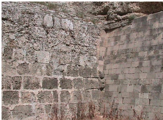
Εικόνα 4.1 Κατασκευή και ανακατασκευή από πορόλιθο
