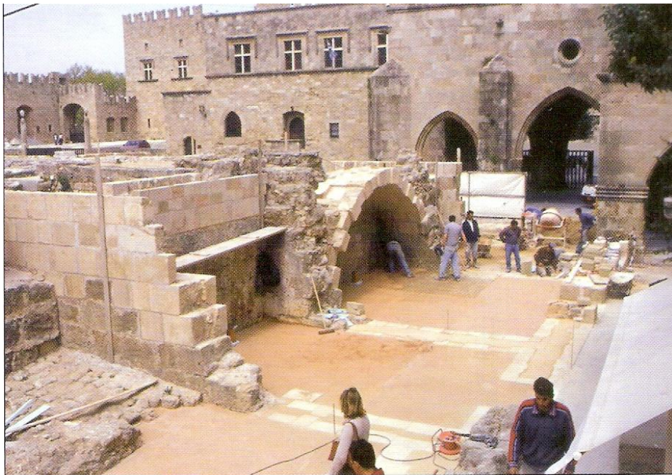
Εικόνα 6.45 Εργασίες διαμόρφωσης της οδού Παναϊτίου
