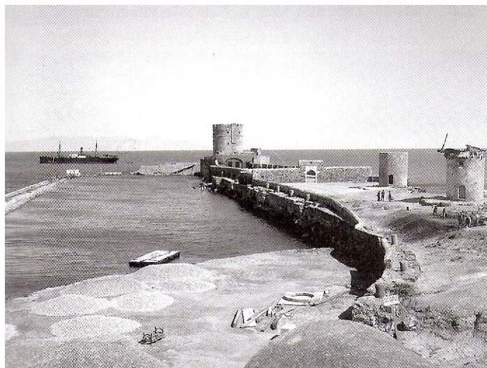
Εικόνα 6.16 Γενική άποψη του μεσαιωνικού μόλου των Μύλων κατά τη διάρκεια κατασκευής του νέου λιμανιού της Ρόδου
