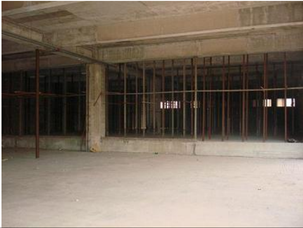
Ισόγειος χώρος κτηρίου
