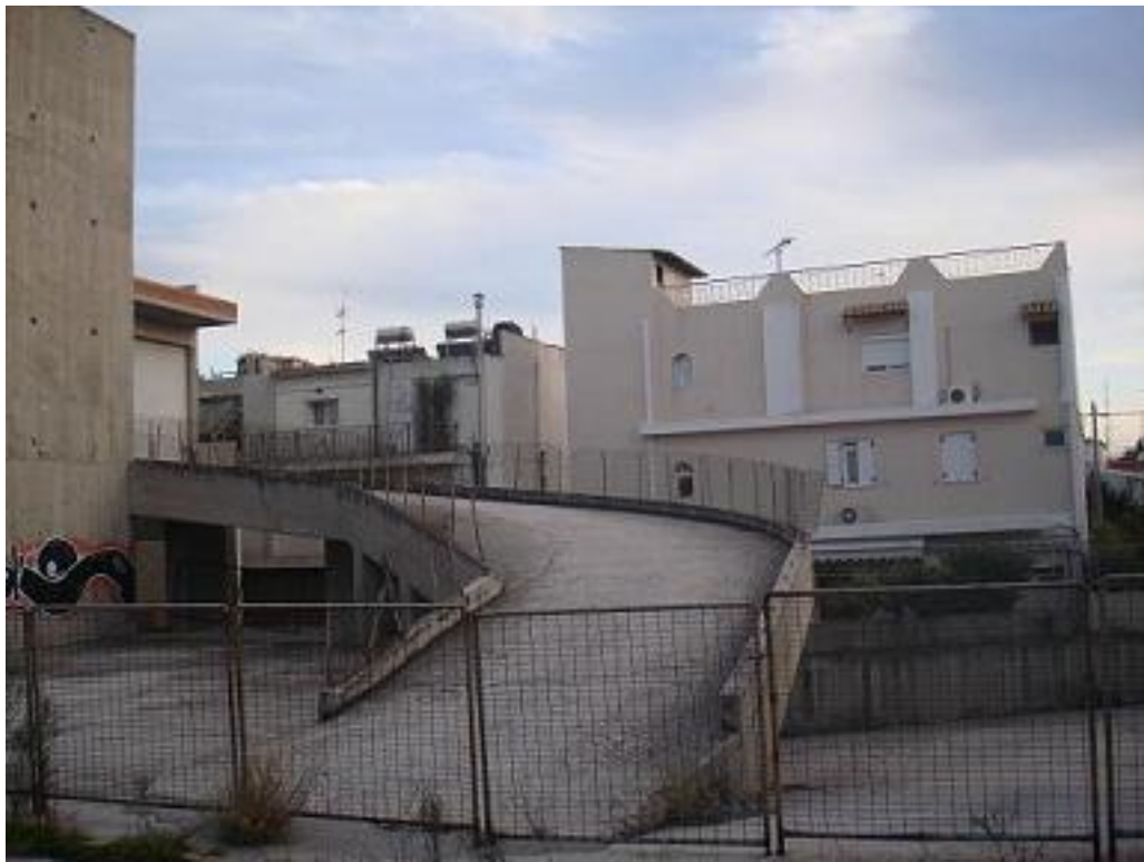
Ράμπα ανόδου στο πίσω τμήμα του κτηρίου
