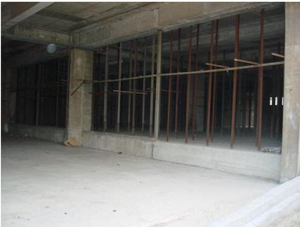
Εσωτερική άποψη του ισογείου όπου διακρίνεται και η υψομετρική διαφορά του δαπέδου
