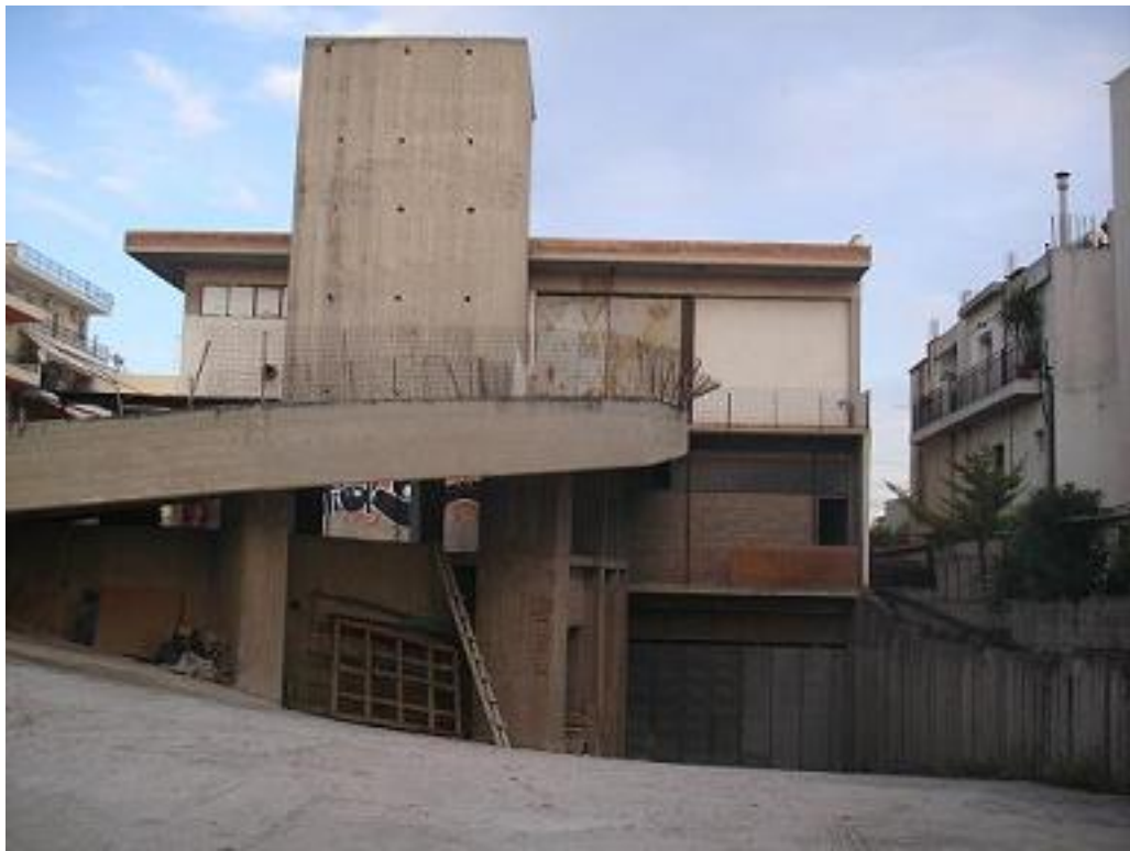
Πίσω όψη κτηρίου
