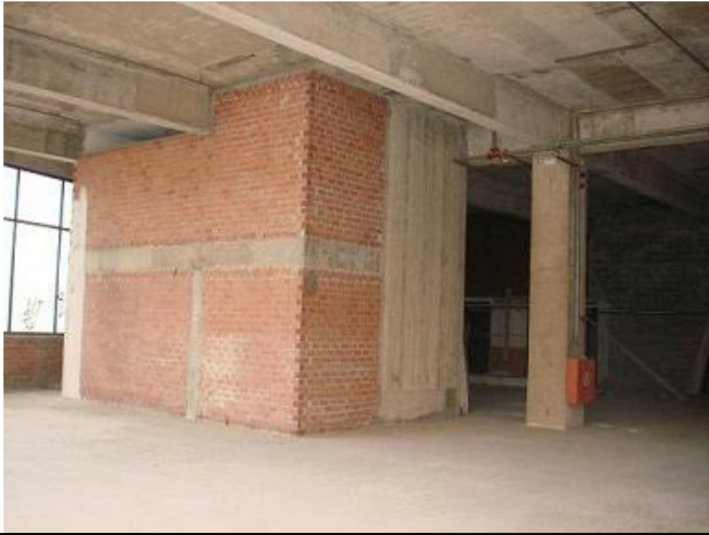
Υφιστάμενος χώρος κλιμακοστασίου και ανελκυστήρα
