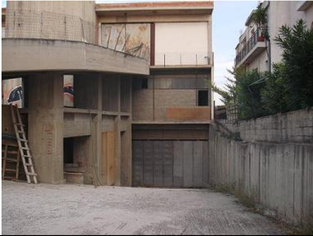
Ράμπα καθόδου στο πίσω τμήμα του κτηρίου
