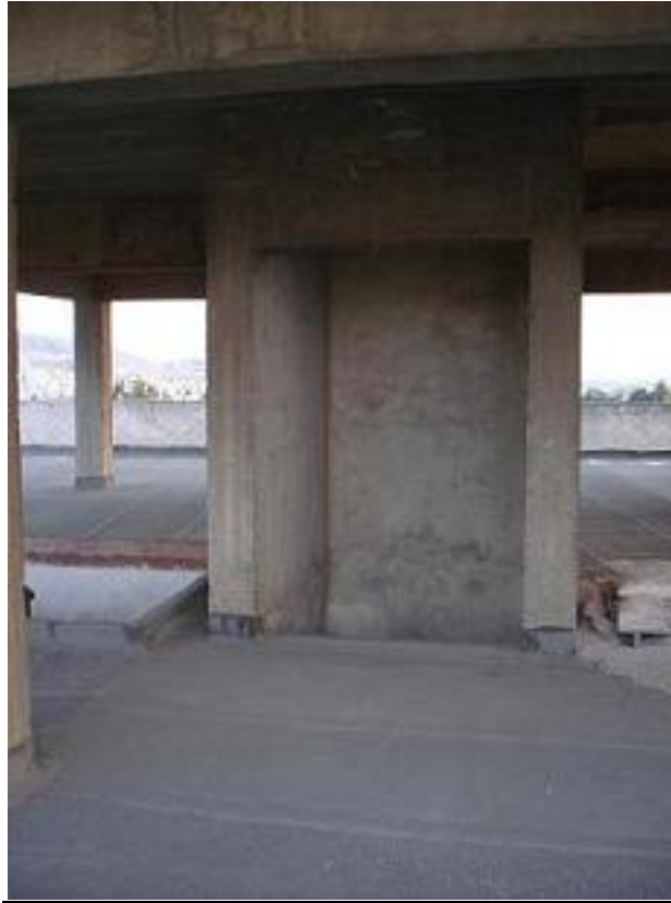
Απόληξη υφιστάμενου ανελκυστήρα
