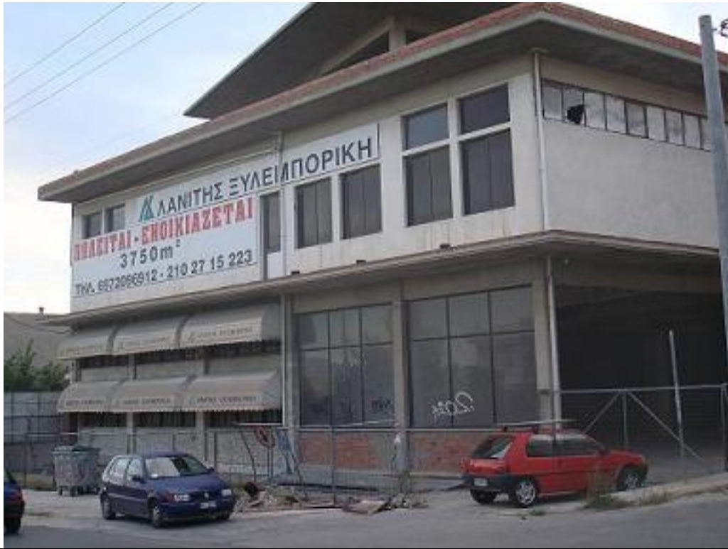
Όψη κτηρίου επί της οδού Φιλαδελφείας
