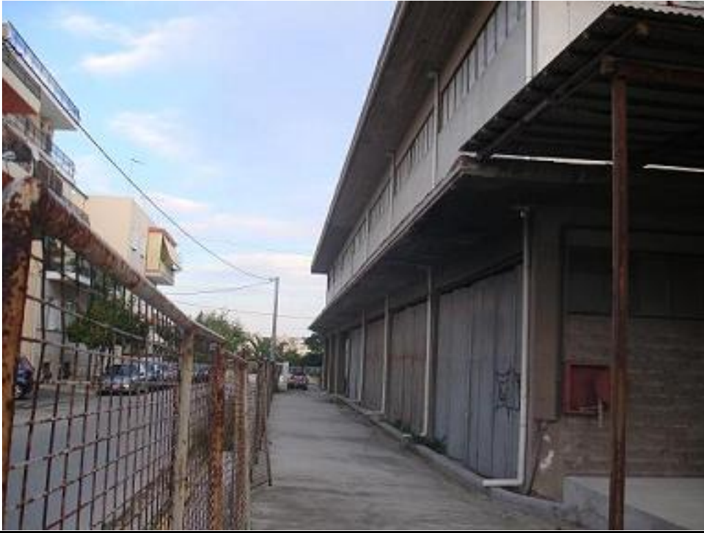
Διάδρομος περιβάλλοντα χώρο κτηρίου επί της οδού Παπαναστασίου
