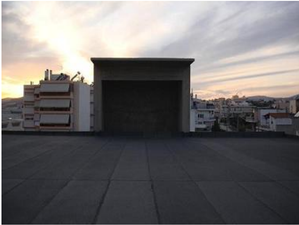
Απόληξη υφιστάμενου ανελκυστήρα στο πίσω τμήμα του κτηρίου
