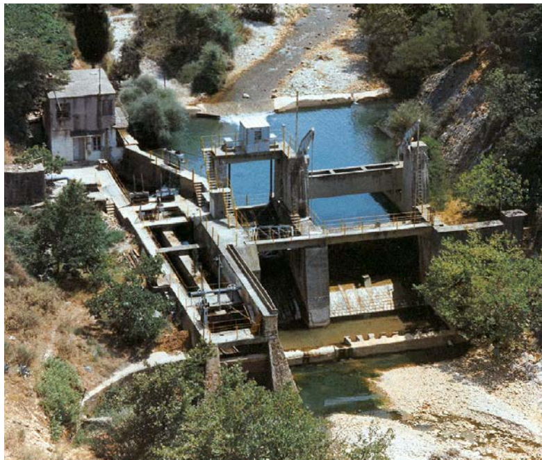
Εικόνα 11 – Φράγμα (πηγή: ΔΕΗ Ανανεώσιμες Α.Ε.)
