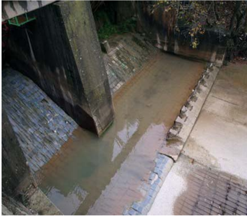
Εικόνα 13 - Μικρή διώρυγα επενδυμένη με γρανίτη (πηγή: ΔΕΗ Ανανεώσιμες Α.Ε.)
