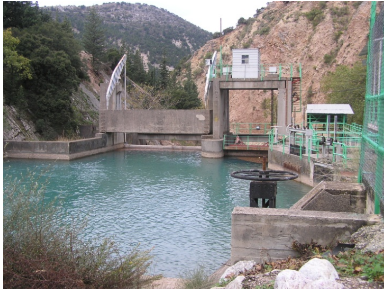
Εικόνα 10 - ΝΑ άποψη φράγματος
