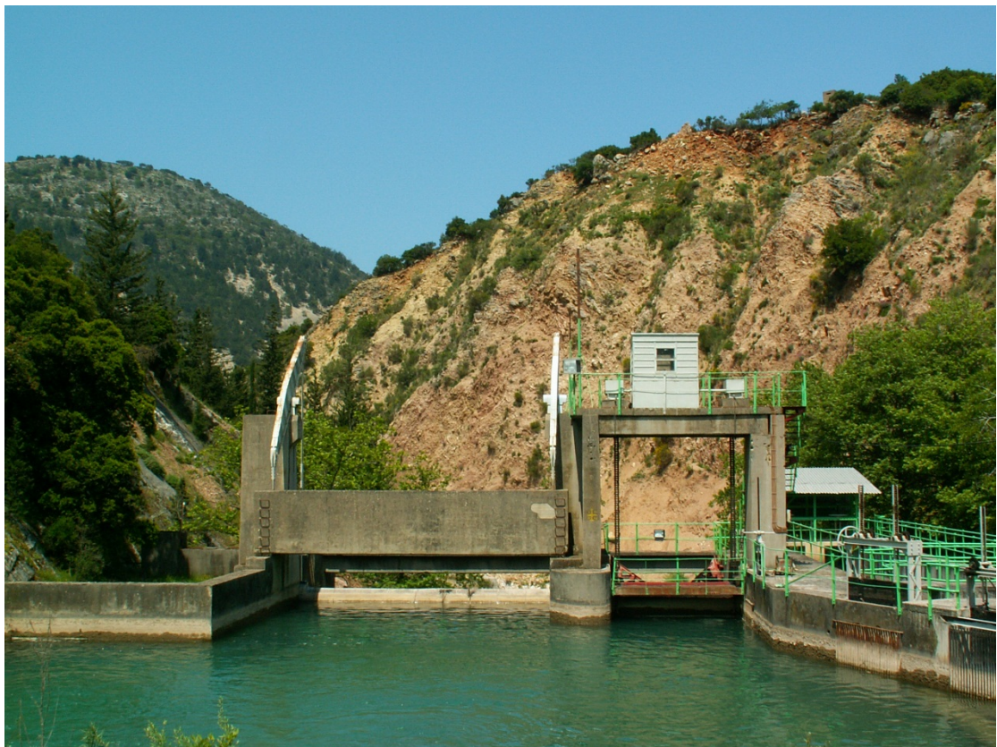
Εικόνα 31: Άποψη φράγματος Γλαύκου
