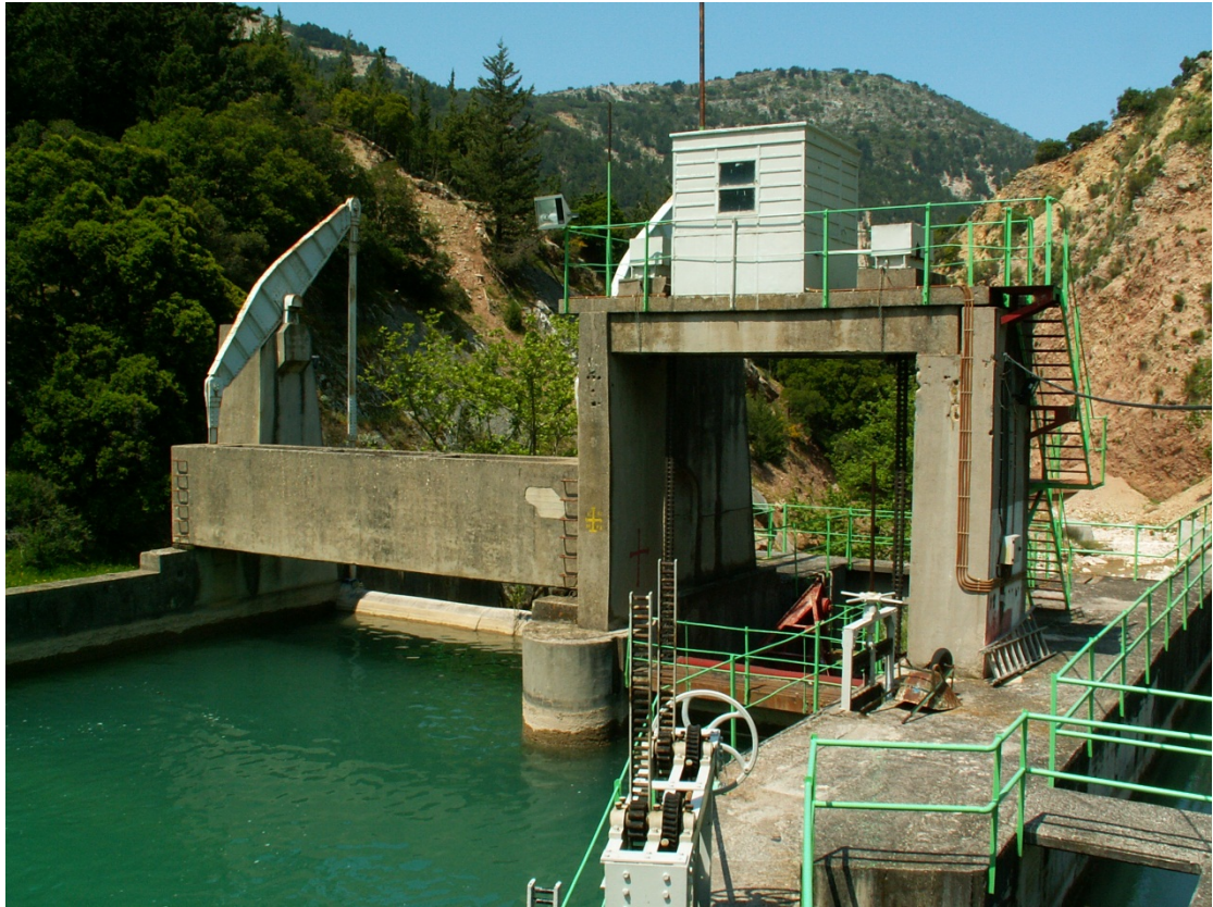
Εικόνα 30: Άποψη φράγματος Γλαύκου
