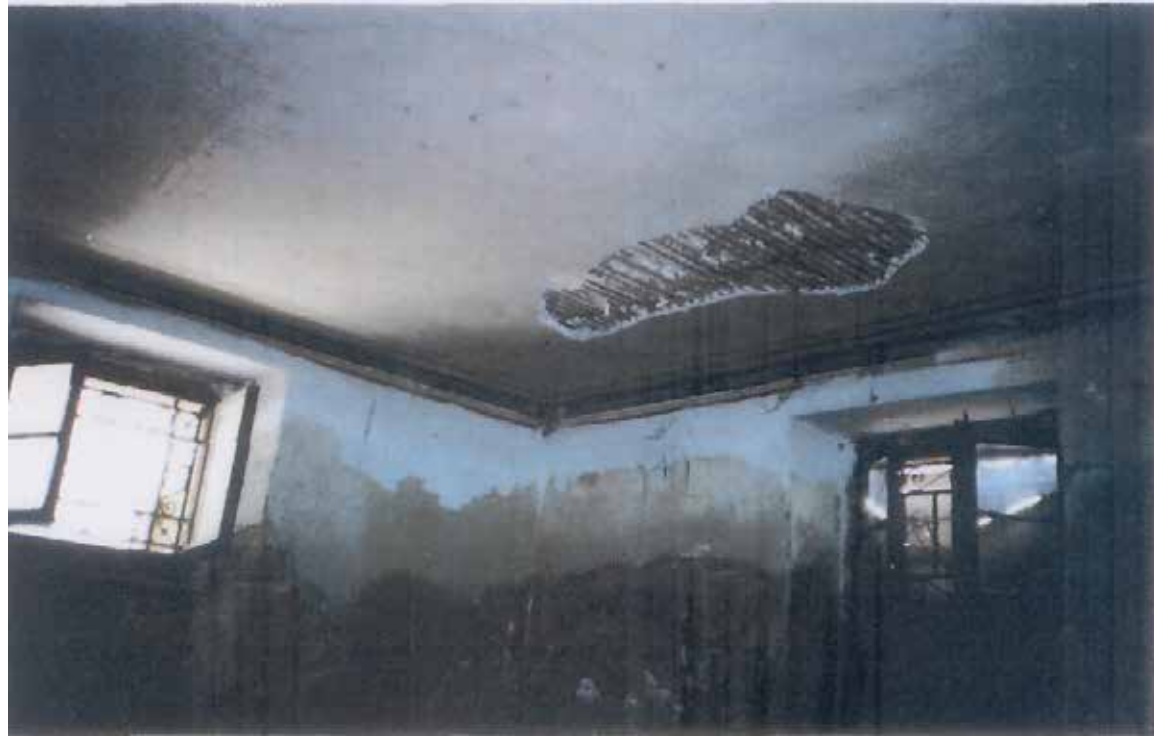
50. ΥΠΟΓΕΙΟ. ΧΩΡΟΣ Ε0 – ΔΙΑΚΡΙΝΟΝΤΑΙ ΡΗΓΜΑΤΩΣΕΙΣ ΚΑΙ ΦΘΟΡΕΣ ΣΤΗΝ ΟΡΟΦΗ ΚΑΙ ΣΤΟΥΣ ΕΞΩΤΕΡΙΚΟΥΣ ΤΟΙΧΟΥΣ ΕΝΤΟΝΗ ΥΓΡΑΣΙΑ
