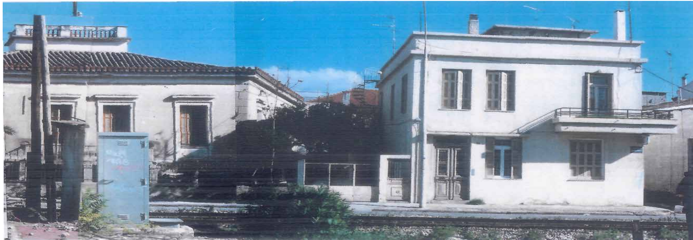
1. ΤΟ ΚΤΙΡΙΟ ΤΣΙΛΛΕΡ ΣΤΟ ΑΜΕΣΟ ΔΟΜΗΜΕΝΟ ΠΕΡΙΒΑΛΛΟΝ ΤΟΥ.
