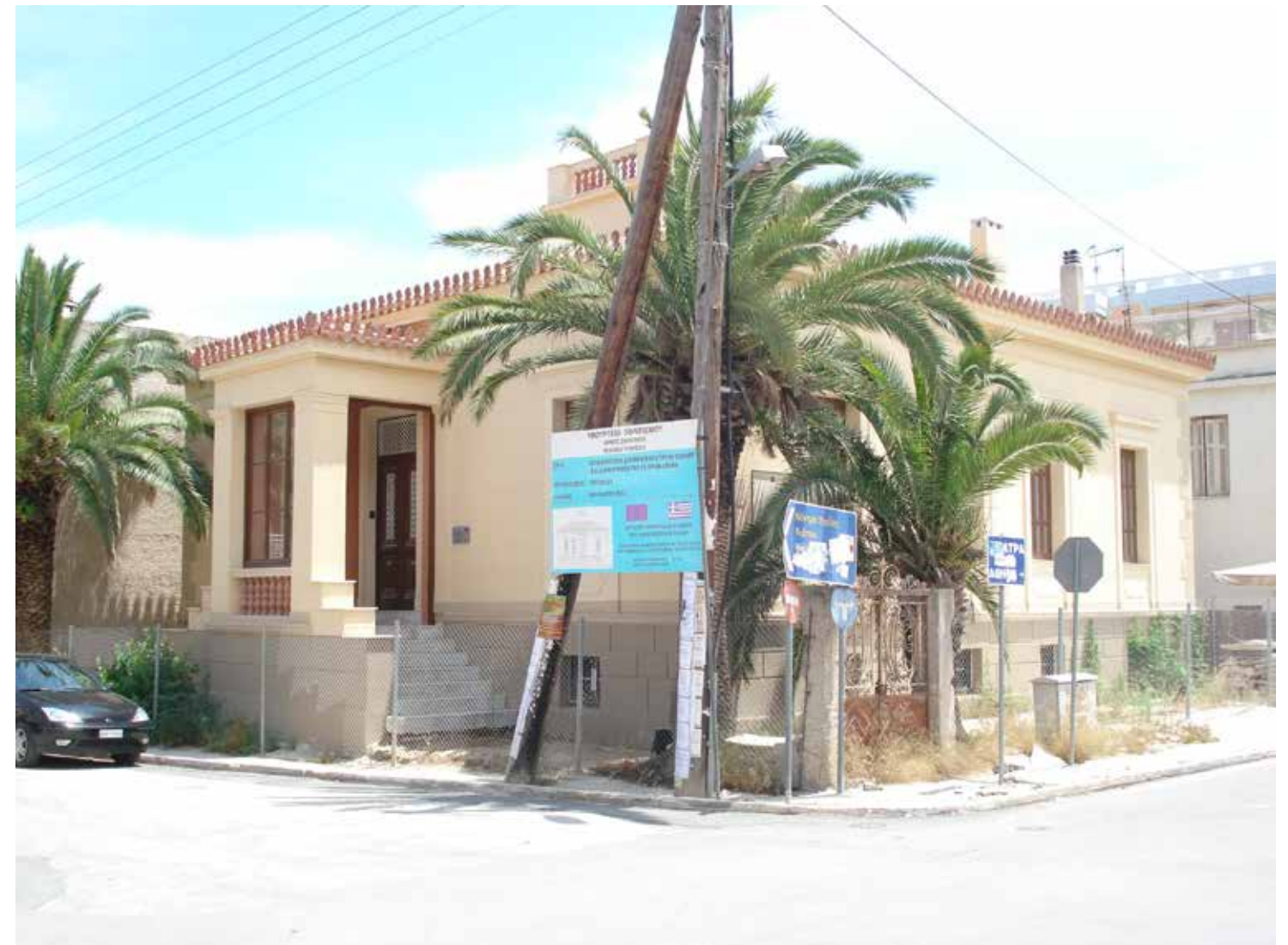
2. ΑΠΟΨΗ ΚΤΙΡΙΟΥ ΑΠΟ ΝΟΤΙΟΔΥΤΙΚΗ ΠΛΕΥΡΑ.
