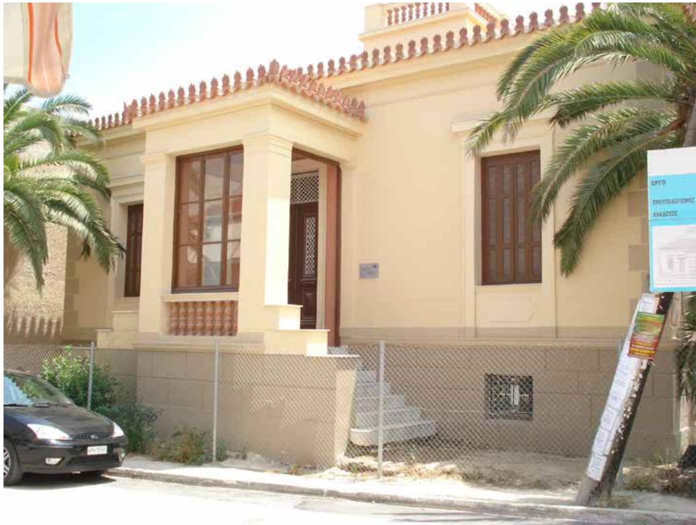
3. ΑΠΟΨΗ ΚΤΙΡΙΟΥ ΑΠΟ ΔΥΤΙΚΗ ΠΛΕΥΡΑ, ΟΠΟΥ ΦΑΙΝΕΤΑΙ ΚΑΙ Η ΚΕΝΤΡΙΚΗ ΕΙΣΟΔΟΣ.
