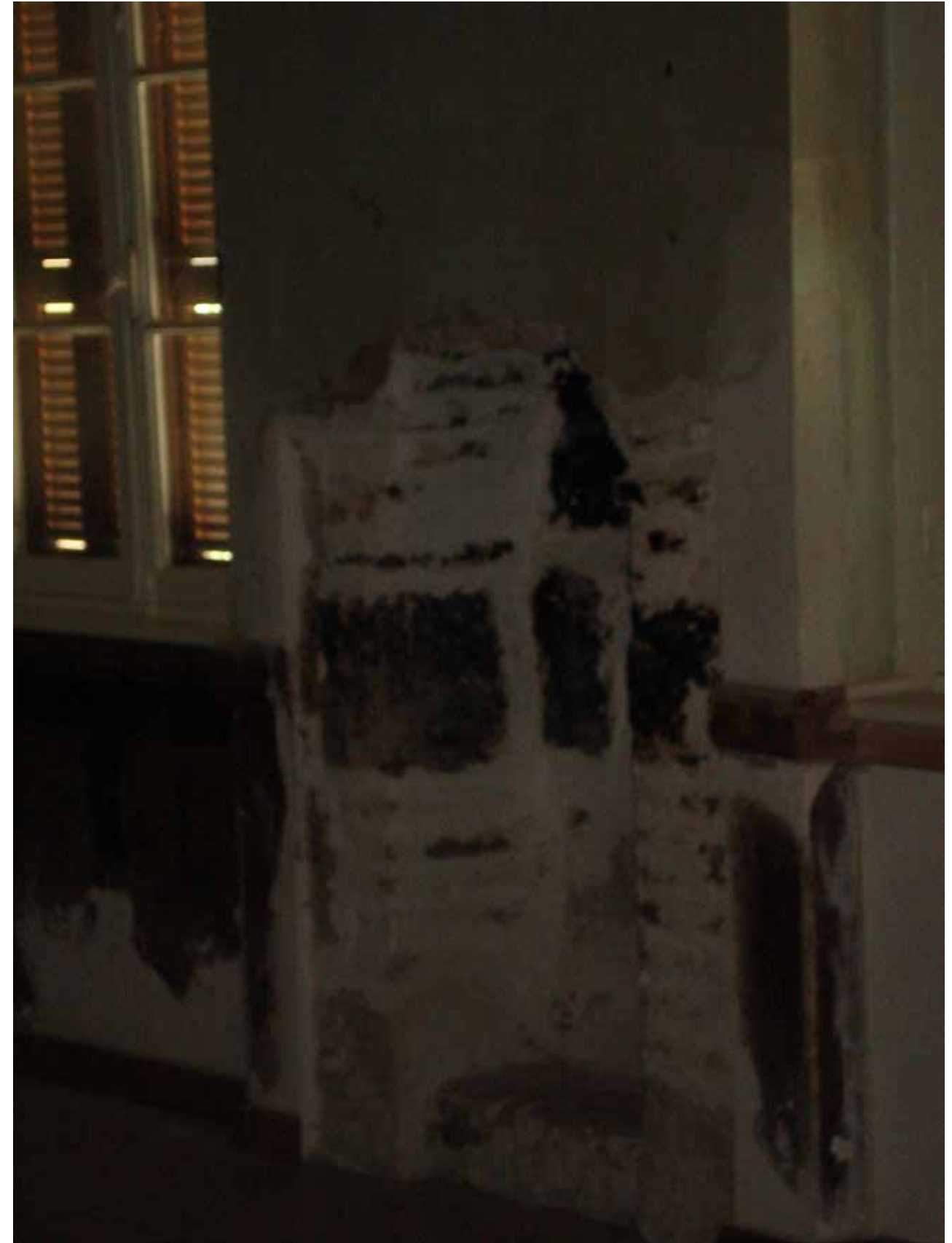
14.ΙΣΟΓΕΙΟ.ΧΩΡΟΣ Ι4 – ΤΖΑΚΙ ΣΤΟ ΝΟΤΙΟ ΤΟΙΧΟ.
