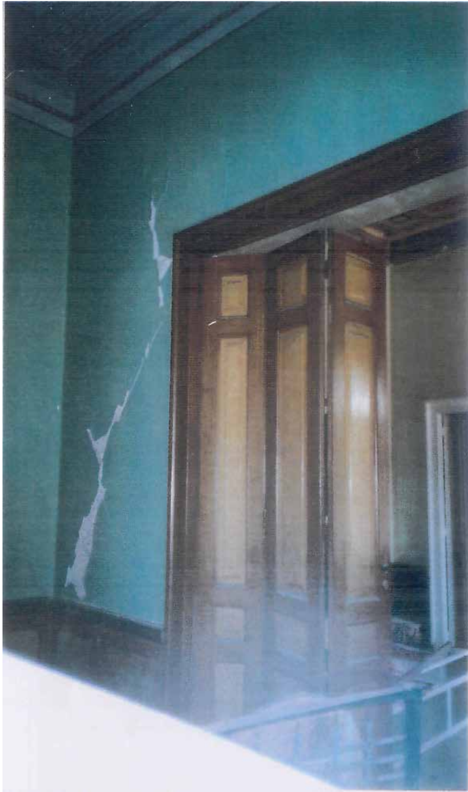
25. ΙΣΟΓΕΙΟ. ΧΩΡΟΣ Β1 – ΑΝΑΤΟΛΙΚΟΣ ΤΟΙΧΟΣ, ΑΡΙΣΤΕΡΟ ΤΜΗΜΑ – ΔΙΑΜΠΕΡΗΣ ΡΗΓΜΑΤΩΣΗ
