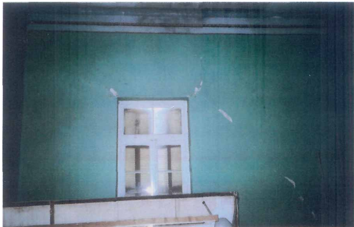
27. ΙΣΟΓΕΙΟ. ΧΩΡΟΣ Γ1 – ΔΥΤΙΚΟΣ ΤΟΙΧΟΣ, ΡΩΓΜΕΣ ΓΥΡΩ ΑΠΟ ΤΟ ΑΝΟΙΓΜΑ ΠΤΥΣΣΟΜΕΝΗΣ ΠΟΡΤΑΣ
