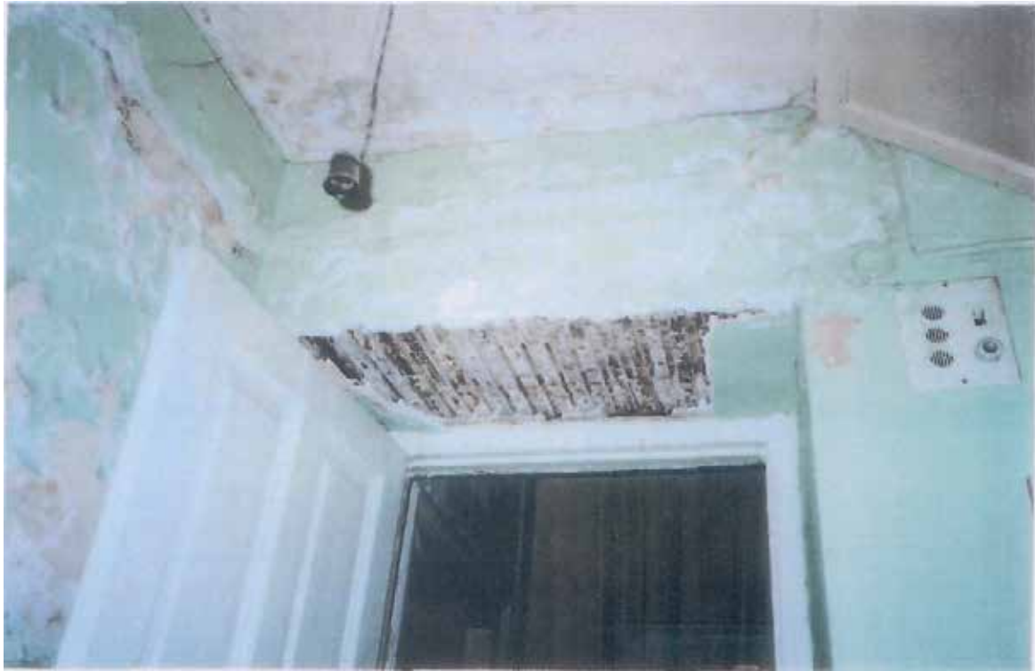
38.ΙΣΟΓΕΙΟ.ΧΩΡΟΣ Θ1 – ΝΟΤΙΟΣ ΤΟΙΧΟΣ – ΑΠΟΛΕΠΙΣΗ ΕΠΙΧΡΙΣΜΑΤΟΣ ΑΠΟ ΥΓΡΑΣΙΑ ΚΑΙ ΡΩΓΜΕΣ
