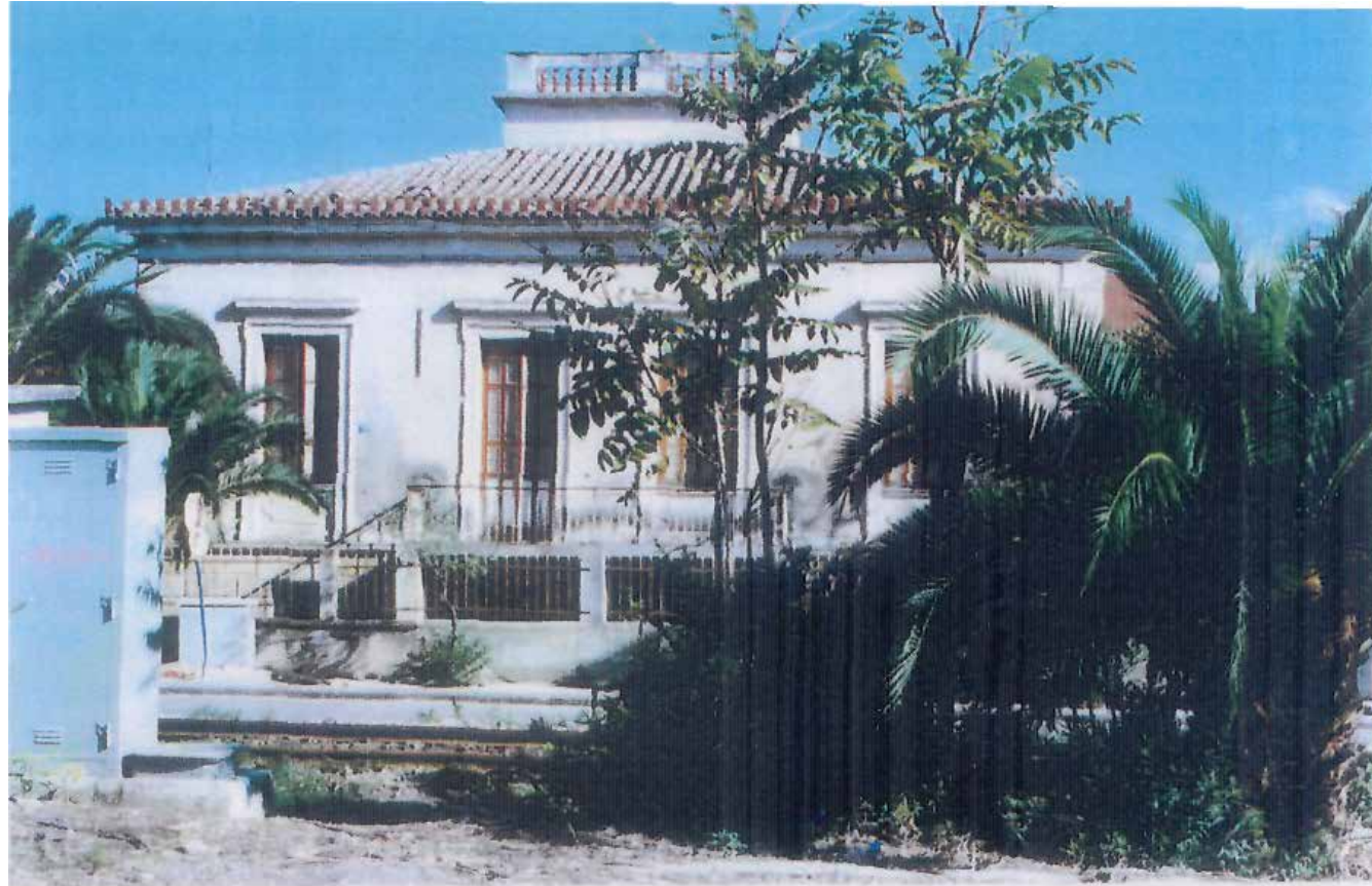
4. ΑΠΟΨΗ ΤΟΥ ΚΤΙΡΙΟΥ ΑΠΟ ΝΟΤΙΑ.
