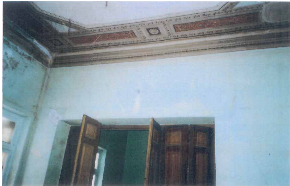
27. ΙΣΟΓΕΙΟ. ΧΩΡΟΣ Γ1 – ΔΥΤΙΚΟΣ ΤΟΙΧΟΣ, ΡΩΓΜΕΣ ΓΥΡΩ ΑΠΟ ΤΟ ΑΝΟΙΓΜΑ ΠΤΥΣΣΟΜΕΝΗΣ ΠΟΡΤΑΣ
