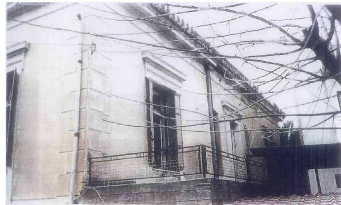
3. ΠΙΣΩ ΟΨΗ ΤΟΥ ΚΤΙΡΙΟΥ.
