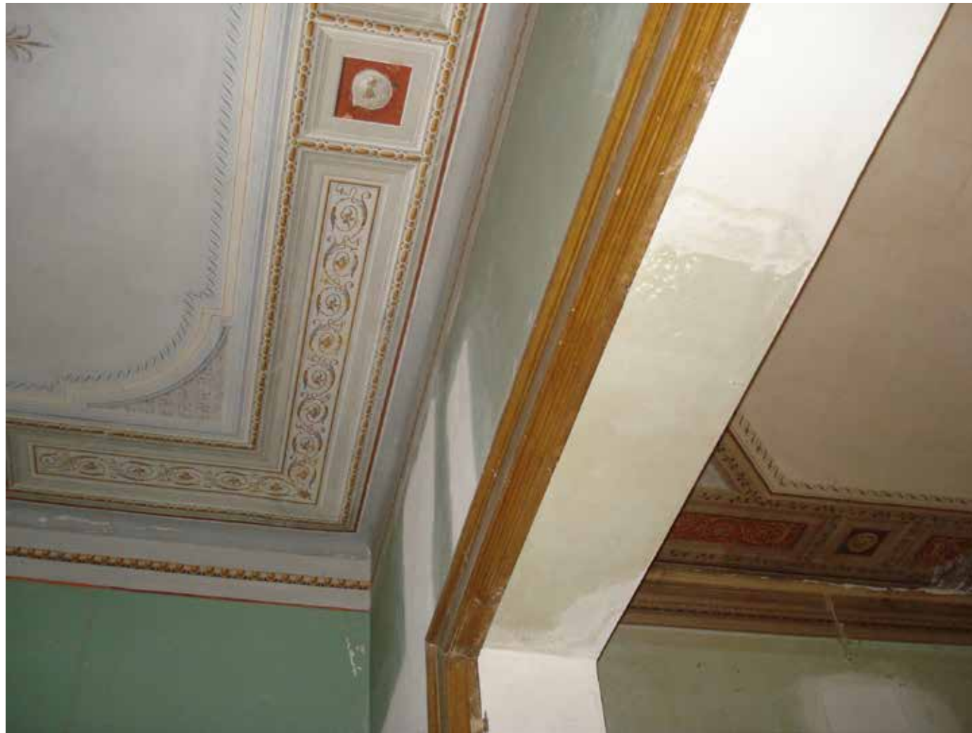
19.ΙΣΟΓΕΙΟ. ΧΩΡΟΙ 14 ΚΑΙ 15 – ΦΑΙΝΕΤΑΙ ΤΗ=ΜΗΜΑ ΤΩΝ ΟΡΟΦΟΓΡΑΦΙΩΝ ΤΩΝ ΔΥΟ ΔΩΜΑΤΙΩΝ.
