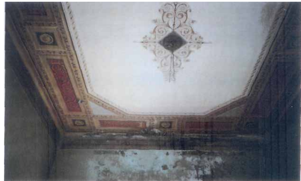
33.ΙΣΟΓΕΙΟ. ΧΩΡΟΣ Γ1 – ΟΡΟΦΟΓΡΑΦΙΑ ΜΕ ΚΕΝΤΡΙΚΟ ΟΜΦΑΛΙΟ ΝΟΤΙΑ ΠΛΕΥΡΑ
