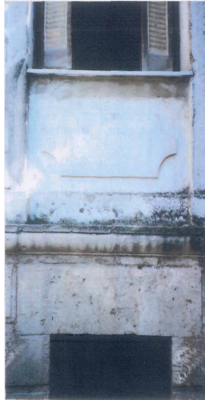
18. ΛΕΠΤΟΜΕΡΕΙΑ ΕΞΩΤΕΡΙΚΗΣ ΠΟΔΙΑΣ ΠΑΡΑΘΥΡΟΥ ΙΣΟΓΕΙΟΥ ΚΑΙ ΛΙΘΟΔΟΜΗΣ ΥΠΟΓΕΙΟΥ
