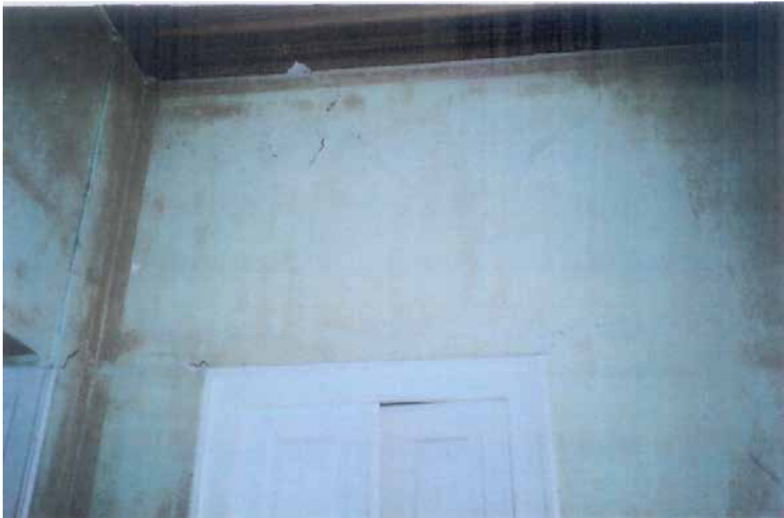
38.ΙΣΟΓΕΙΟ.ΧΩΡΟΣ Θ1 – ΝΟΤΙΟΣ ΤΟΙΧΟΣ – ΑΠΟΛΕΠΙΣΗ ΕΠΙΧΡΙΣΜΑΤΟΣ ΑΠΟ ΥΓΡΑΣΙΑ ΚΑΙ ΡΩΓΜΕΣ
