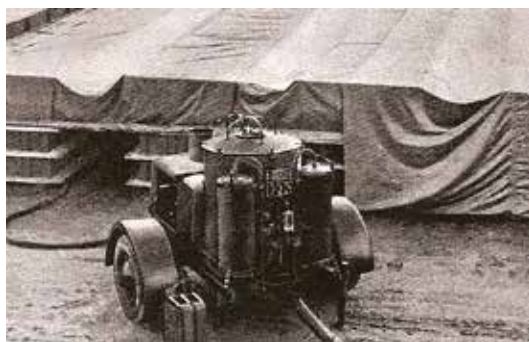
Εικόνα 9. Φορητή ταχυατομολεβητός σε εργοταξιακή εγκατάσταση για την ωρίμανση του σκυροδέματος.
