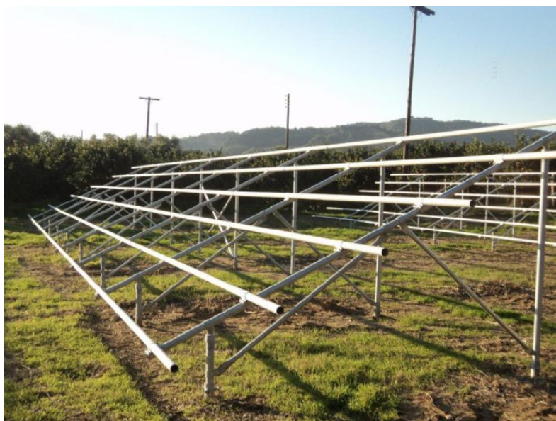
Εικόνα 13: Βάσεις στήριξης φωτοβολταϊκών πλασίων
