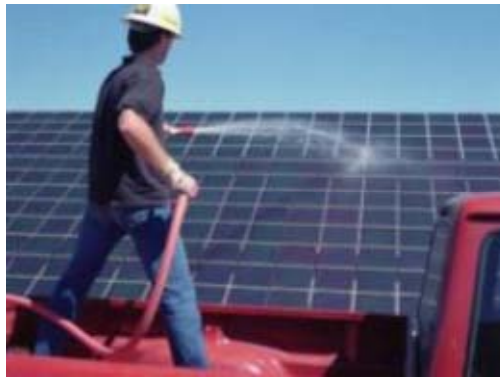
Εικόνα 21: Πλύσιμο φωτοβολταϊκών πλαισίων
