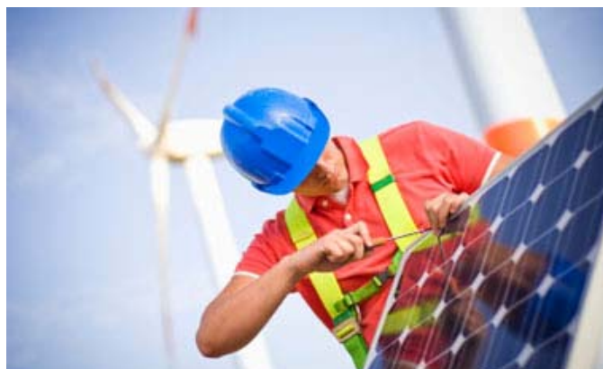
Εικόνα 17: Επισκευή φωτοβολταϊκού panel
