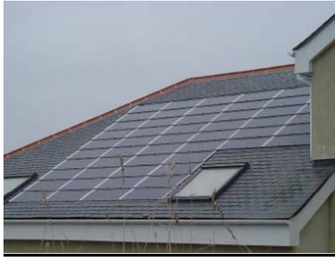
Εικόνα 8: Εγκατάσταση φωτοβολταϊκών πλαισίων
