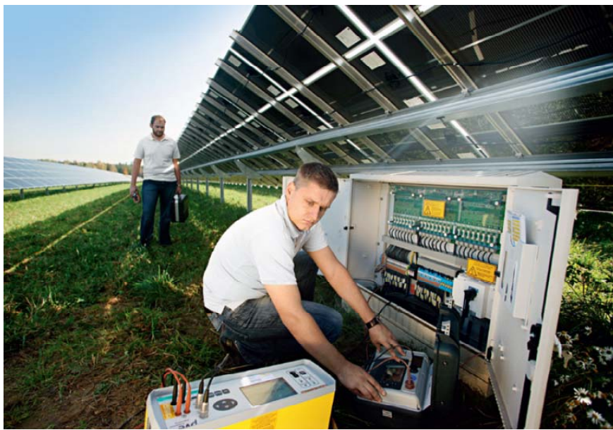
Εικόνα 15: Μέτρηση πεδίων τάσης του σταθμού 2.6.6. Καλωδιώσεις – Πίνακες
