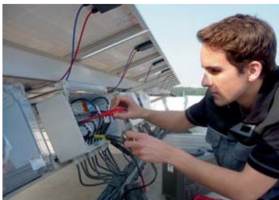
Εικόνα 18: Επισκευή και αντικατάσταση καλωδίων
