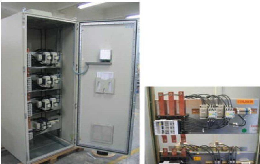
Σχήμα 1.1: Τυποποιημένοι πίνακες COSINON της Elasis (συστοιχίες πυκνωτών για αντιστάθμιση άεργου ισχύος).
