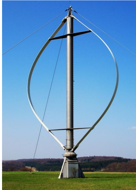
Σχήμα 2.3.1: Ανεμογεννήτρια κατακόρυφου άξονα.
