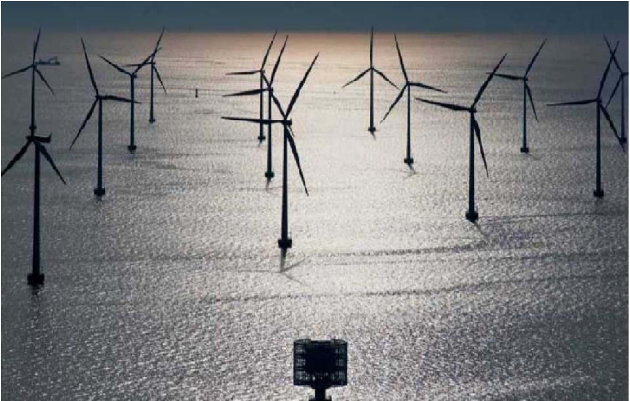
Σχήμα 39: Εγκατάσταση με ανεμογεννήτριες
