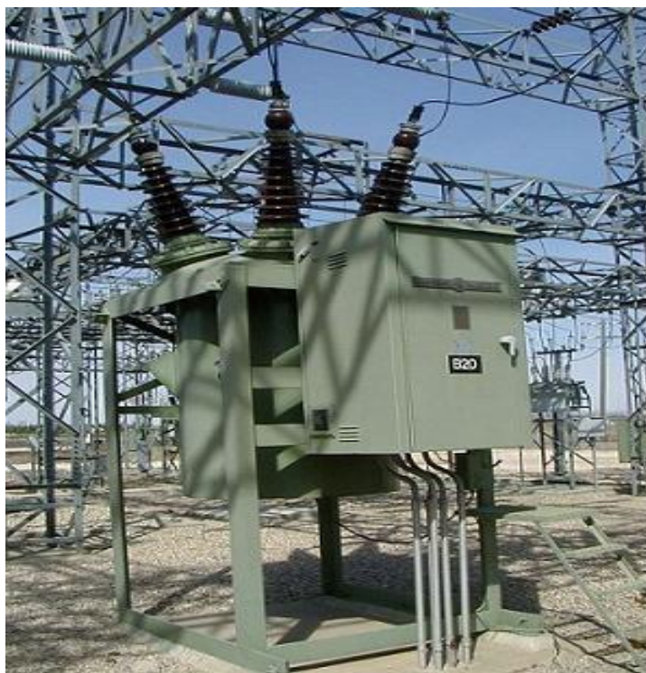
Σχήμα 5.8: Διακόπτης ισχύος λαδιού.
