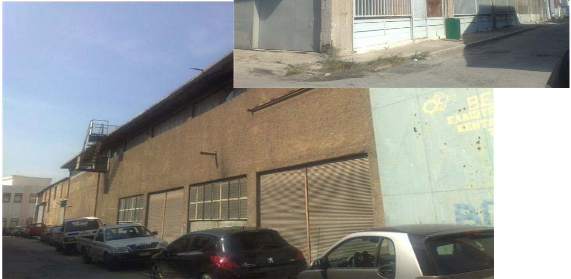
«Α/Α 9. Οικοδ. Τετρ.168. Μηχανουργείο, Περικλή Γ. Λιθοξόου Ε.Ε»
