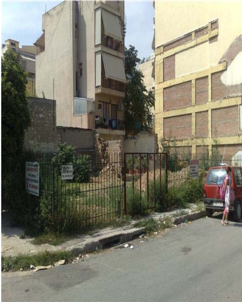
Α/Α 1. Οικοδ. Τετρ. 103. «Παρατημένο οικόπεδο, ανεκμετάλλευτος χώρος»
