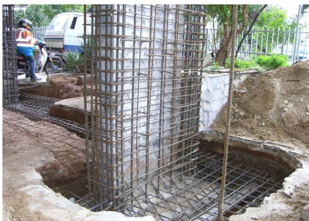
Εικόνα 3.2. Τοποθέτηση οπλισμών μανδύα
