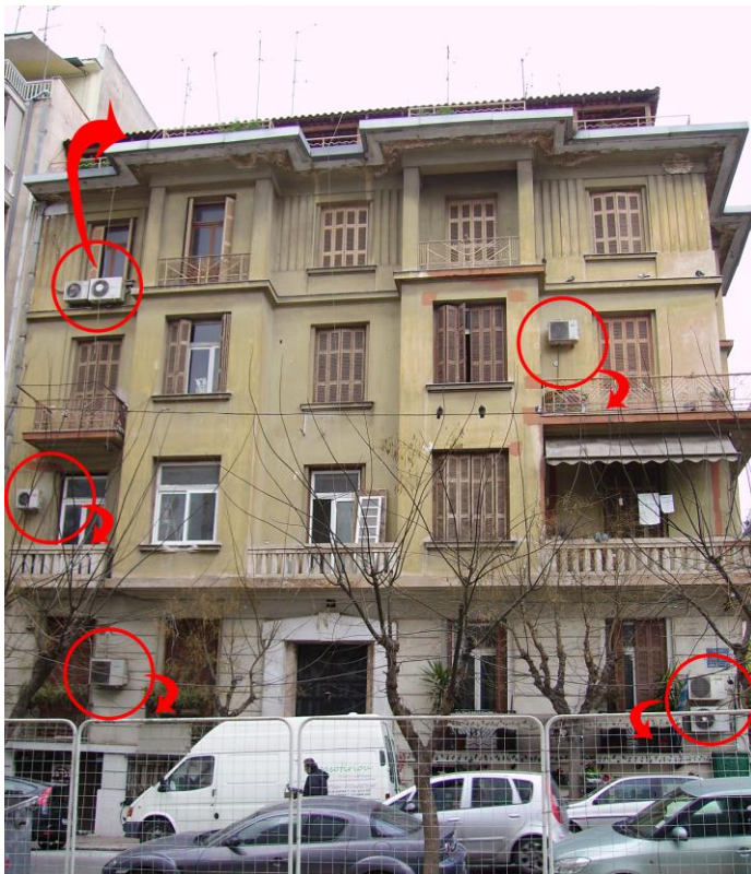
Όψη επί της οδού Κοδριγκτώνος (μεταφορά κλιματιστικών)
