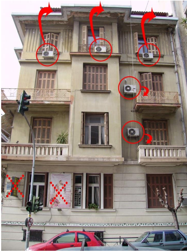
Όψη επί της οδού Αριστοτέλους (μεταφορά κλιματιστικών και αφαίρεση πινακίδων)
