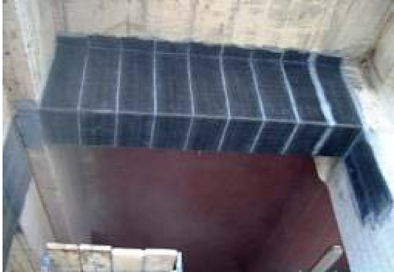
Εικόνα 6.2: Δοκός ενισχυμένη με επικολλητά φύλλα
