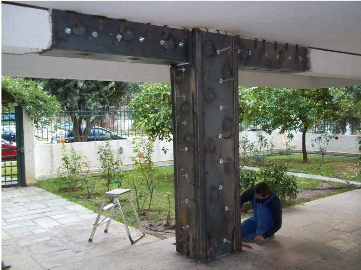
Εικόνα 6.4: Δοκός και υποστύλωμα ενισχυμένα με εξωτερικά στοιχεία.
