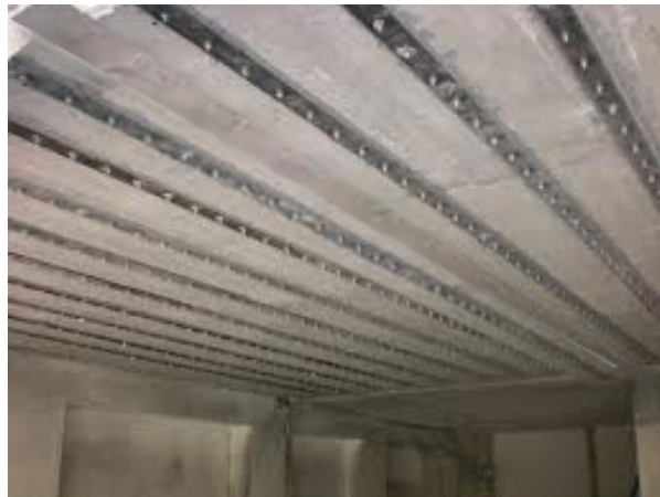
Εικόνα 6.3: Δοκός και πλάκα ενισχυμένα με ινοπλισμένα πολυμερή
