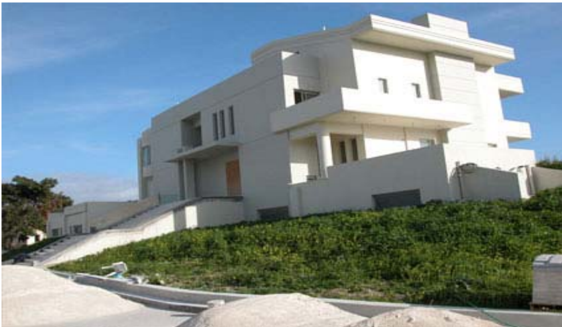
Ολοκληρωμένο σύστημα αυτοματισμού σε κατοικία στη Ρόδο.
