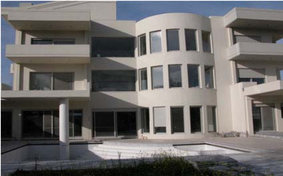
Ολοκληρωμένο σύστημα αυτοματισμού σε κατοικία στη Ρόδο.
