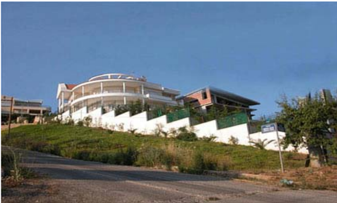
Ολοκληρωμένο σύστημα αυτοματισμού με KNX σε κατοικία στον Άγιο Νικόλαο.
