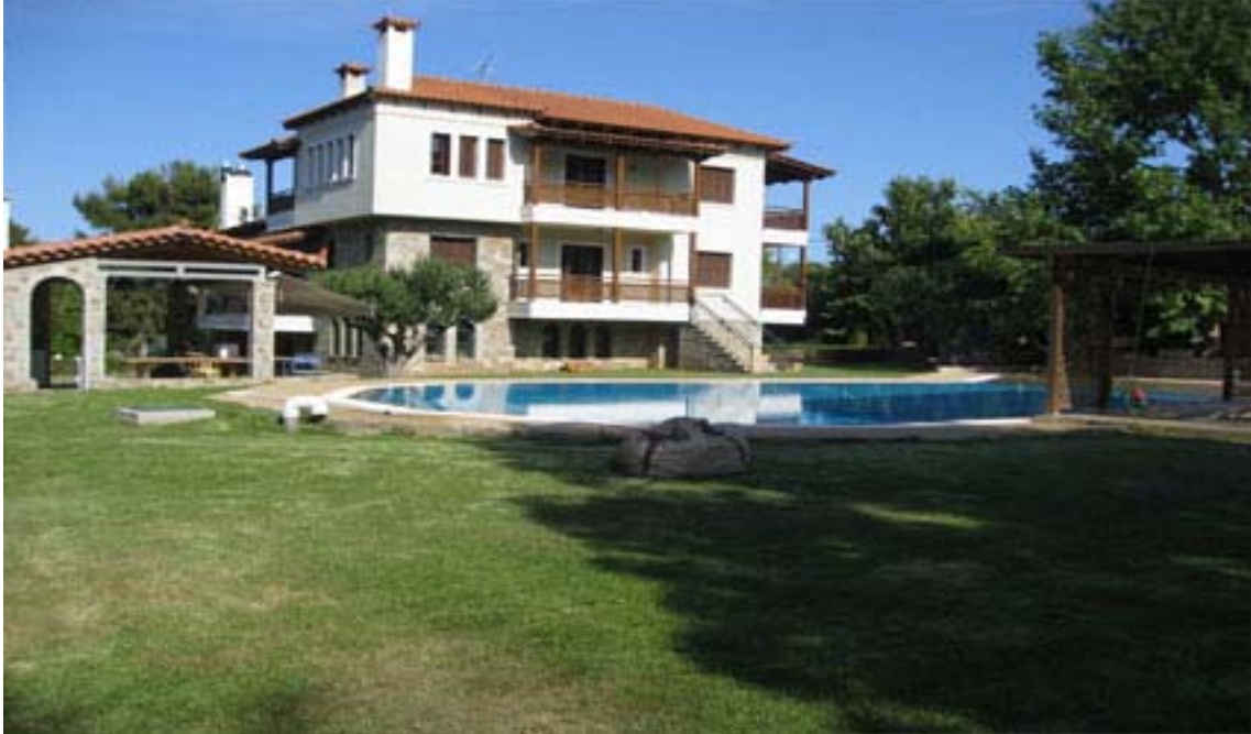
Ολοκληρωμένο σύστημα αυτοματισμού σε κατοικία.
