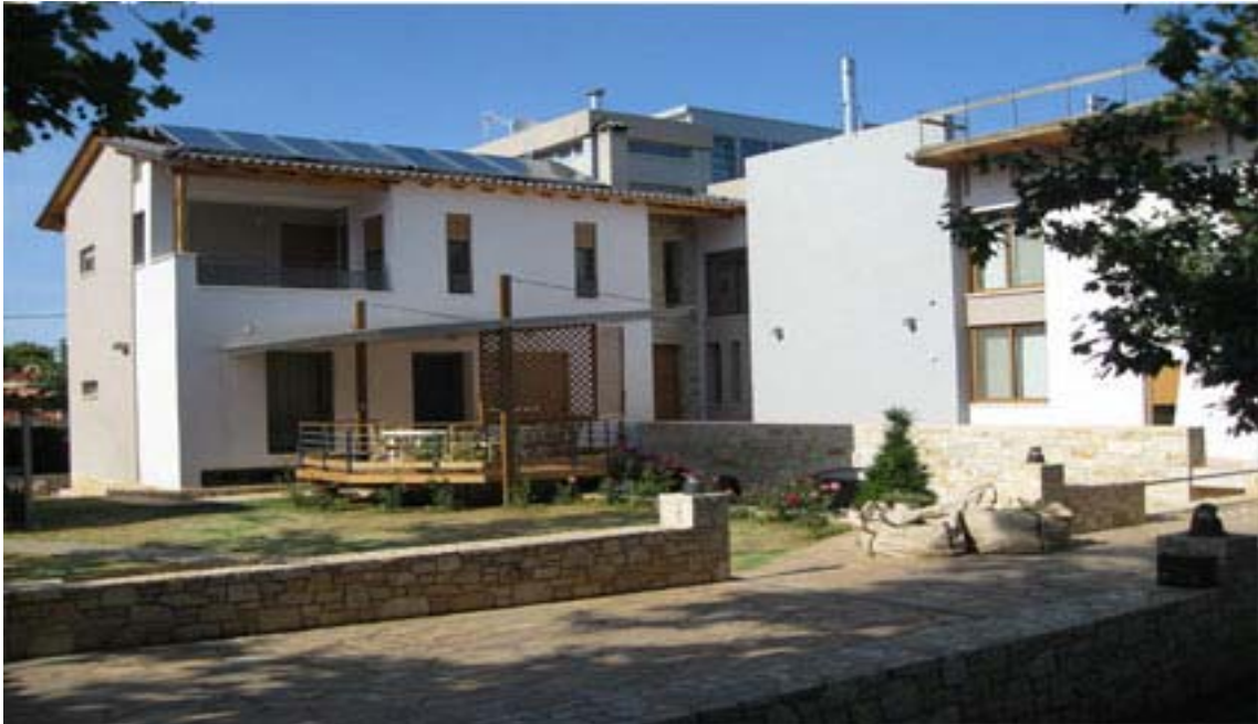
Ολοκληρωμένο σύστημα αυτοματισμού και ελέγχου με σύστημα Instabus KNX σε κατοικία.
