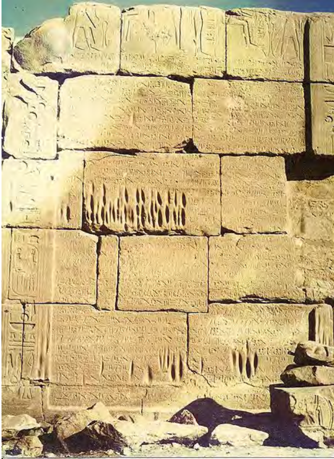
Εικόνα 1.3.4: Κατασκευή τοίχου από πέτρα
