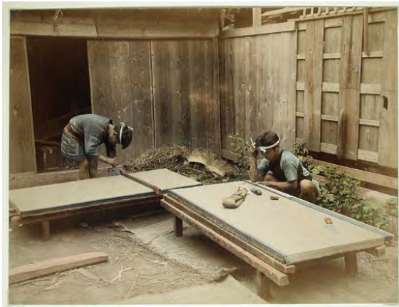
Εικόνα 4.1.49: κατασκευή τάπητα τατάμι
