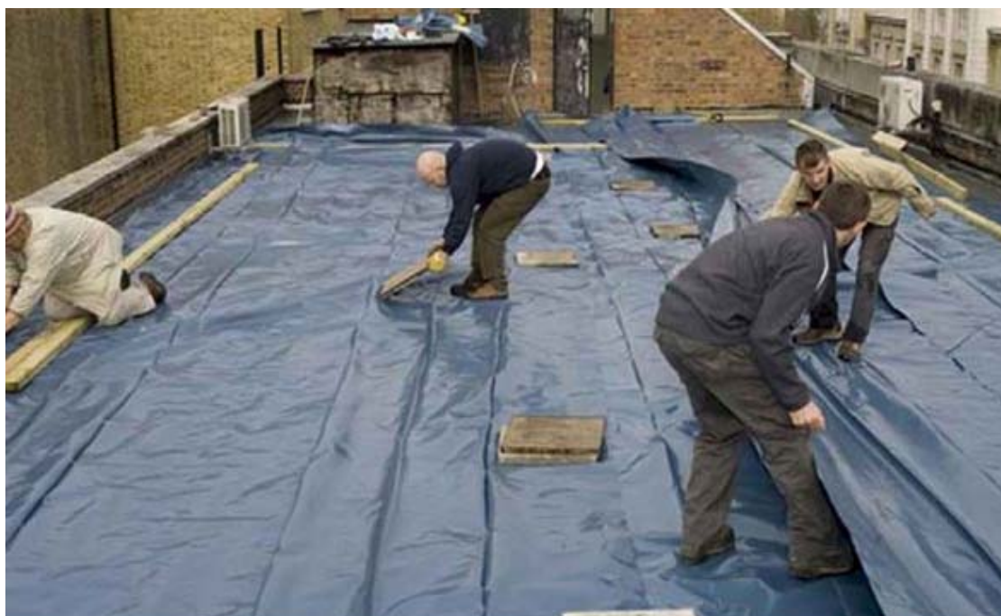
Εικόνα 6 Τοποθέτηση αδιάβροχης μεμβράνης
