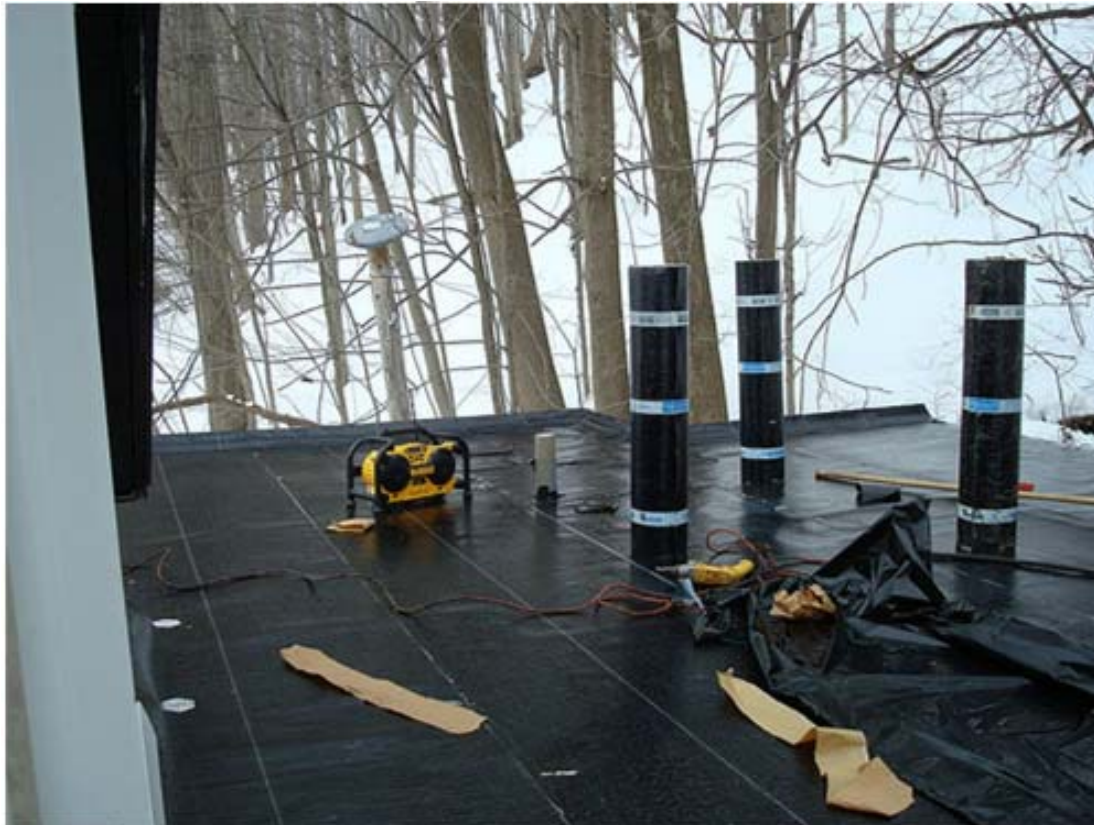
Εικόνα 22 Τοποθέτηση αντιρριζικής μεμβράνης
