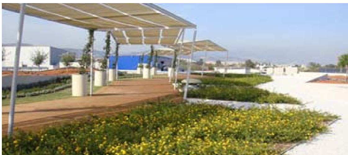
Εικόνα 25 Το δώμα του νέου αμαξοστασίου του ΗΛΠΑΠ στο Ρουφ
