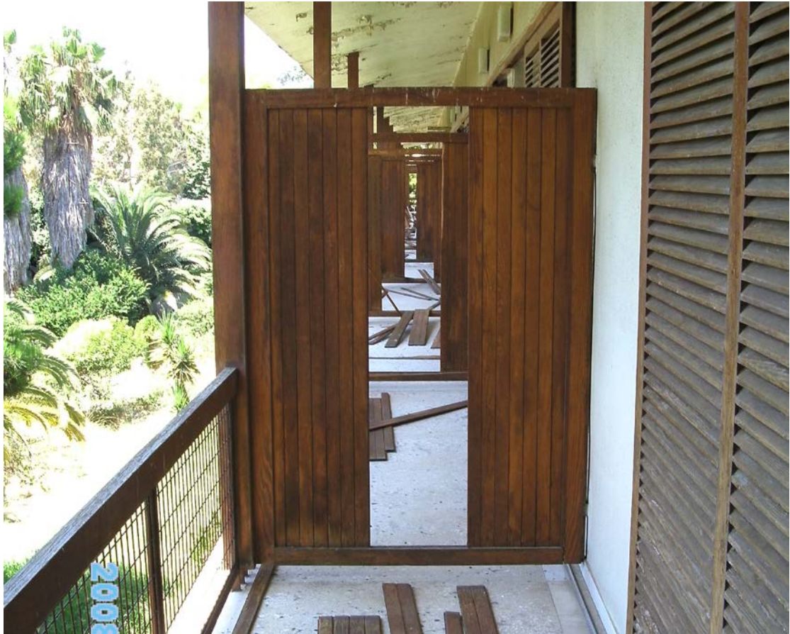
Εικ.32 Οι εξώστες στο τμήμα των υλνοδοματίων.
