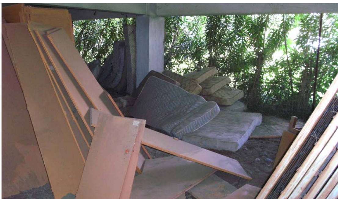
Εικ.34 Η πιλωτή του κτιρίου όπου βρίσκετε ο εξοπλισμός του Ξενία κατεστραμένος.
