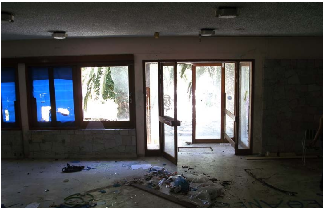
Εικ. 27 Η εσωτερική όψη της εισόδου.
