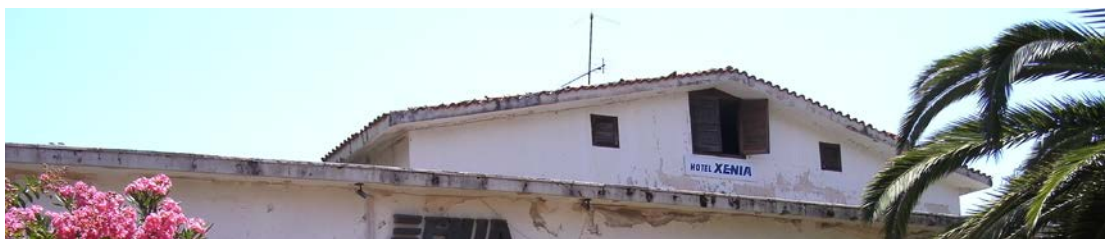
Εικ.25 Όψη της δίρριχτης στέγης.
