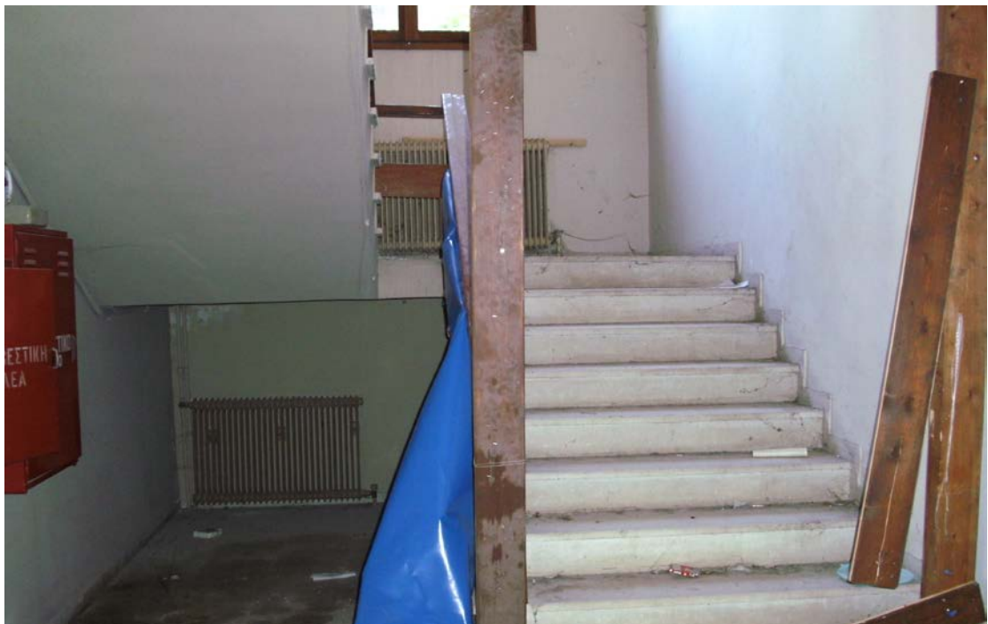
Εικ.31 Το κλιμακοστάσιο του κτιρίου.
