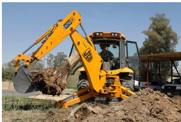
Εικόνα 44: Πίσω όψη ενός JCB 3CX κατά την εργασία του με τη τσάπα. (Έχουν ενεργοποιηθεί οι οριζόντιοι σταθεροποιητές για να αποτρέψουν το ντεραπάρισμα του οχήματος όταν ο βραχίονας είναι σε πλήρη έκταση)
