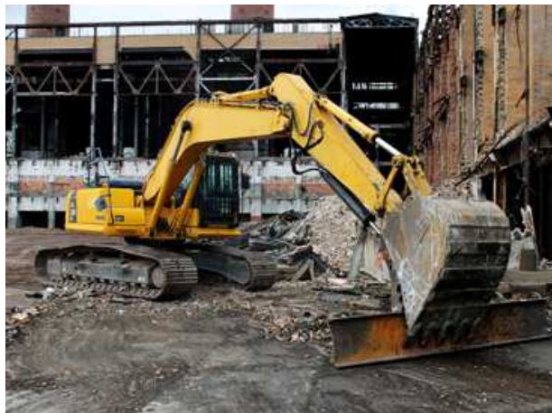
Εικόνα 49: Εκσκαφέας εν ώρα εργασίας. (Πηγή: www.google.gr )
