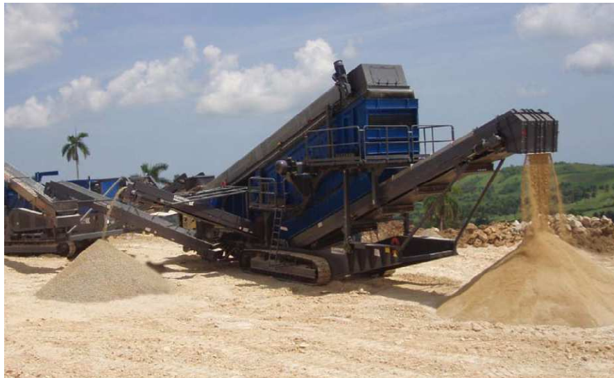
Εικόνα 69: Φορητή μονάδα επεξεργασίας και διαβάθμισης.
