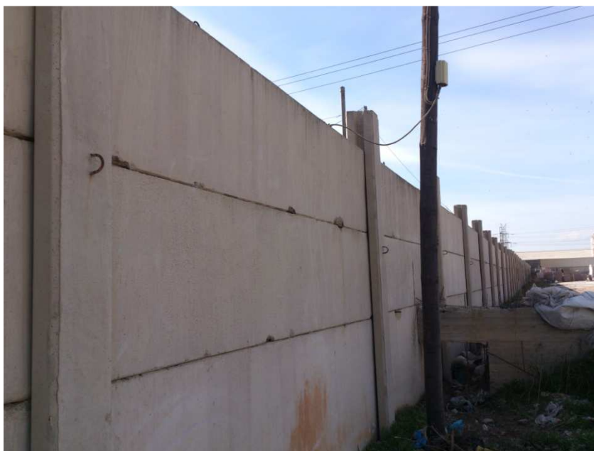
Εικόνα 89: Τοίχος από προκατασκευασμένες πλάκες σκυροδέματος. (Πηγή: Εικόνα από την επίσκεψή μας στο χώρο στις 02/04/2012- Γειτονικό κτίριο)
