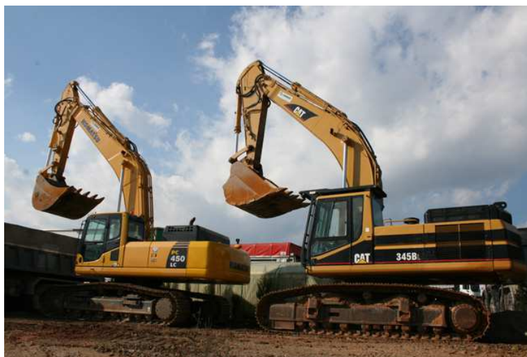
Εικόνα 47: Εκσκαφείς εν ώρα εργασίας. (Πηγή: http://www.excavation.gr/ )
