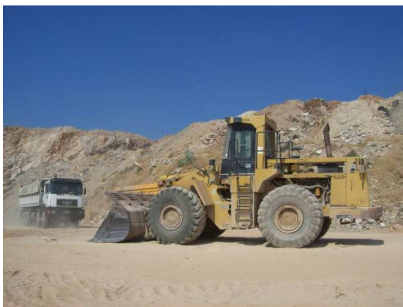
Εικόνα 43: Φορτωτής εν ώρα εργασίας σε εργοτάξιο. (Πηγή: http://www.sedpekat.gr/ )
