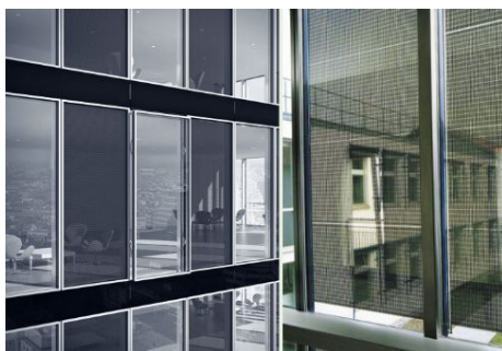
Εικόνα 20. Οι κινητές φωτοβολταϊκές περσίδες παράγουν ρεύμα όταν είναι κλειστές και προστατεύουν παράλληλα το κτίριο από τον ήλιο.
