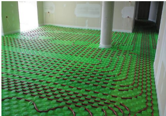
Εικόνα 78. Η ενδοδαπέδια θέρμανση θερμαίνει ή ψύχει όλο σπίτι μετατρέποντας το κάθε δάπεδο σε πηγή θέρμανσης ή ψύξης αντίστοιχα, επίσης πιτρέπει στους χώρους του κτιρίου να παραμείνουν καθαροί από τρίτα σώματα, όπως είναι τα σώματα καλοριφέρ και τα air conditions.
