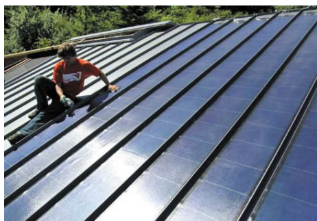
Εικόνα 35. Εγκατάσταση συμβατικών φωτοβολταϊκών φύλλων σε στέγη κτιρίου.
