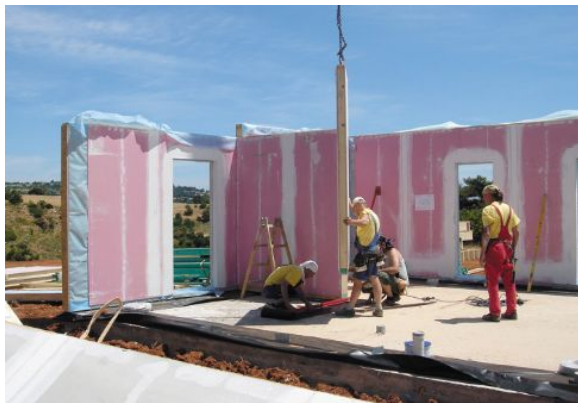
Εικόνα 68. Η πρώτη αυτόνομη βιοκλιματική κατοικία στην Ελλάδα.
