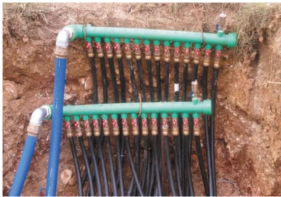
Εικόνα 75. Για κάθε τετραγωνικό μέτρο του χώρου που θέλουμε να θερμάνουμε αντιστοιχούν 4-5 μέτρα σωλήνα.
