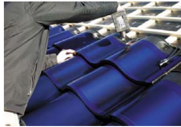
Εικόνα 15. Τα φωτοβολταϊκά κεραμίδια αποτελούν ένα πρώτο βήμα για την ενσωμάτωση των φωτοβολταϊκών στα κτίρια.
