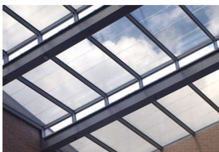
Εικόνα 30. Ο βέλτιστος συνδυασμός είναι η τοποθέτηση φωτοβολταϊκών σκιάστρων όπου δεν απαιτείται φωτοδιαπερατότητα και διάφανων φωτοβολταϊκών όπου είναι απαραίτητα.
