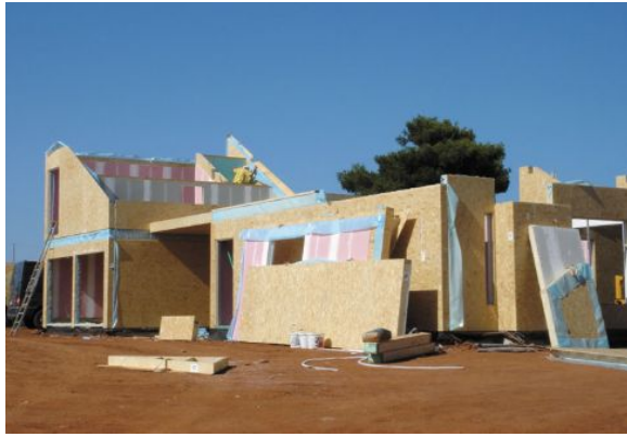
Εικόνα 72. Οι τοίχοι της κατοικίας συναρμολογούνται στο χώρο κατασκευής.
