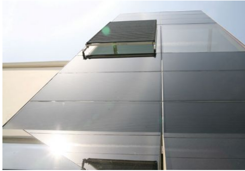
Εικόνα 26. Σήμερα έχουν σχεδιαστεί φωτοβολταϊκά στοιχεία ειδικά για κατασκευή κτιρίων.
