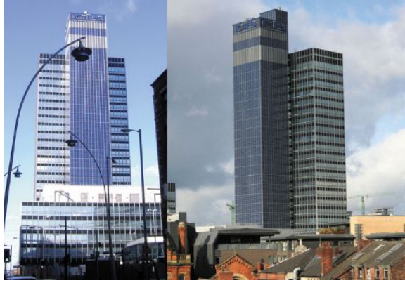
Εικόνα 18. Ο πύργος CIS (δεύτερο ψηλότερο κτίριο του Manchester της Αγγλίας) αποτελεί ένα πολύ ενδιαφέρον παράδειγμα μεγάλου κτιρίου με φωτοβολταϊκή πρόσοψη.
