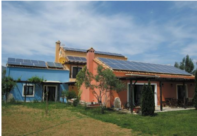
Εικόνα 74. Βιοκλιματική κατοικία με εγκατάσταση αβαθούς γεωθερμίας για θέρμανση και ψύξη, φωτοβολταϊκά συστήματα για παραγωγή ηλεκτρισμού και ηλιακούς συλλέκτες για ζεστό νερό χρήσης.
