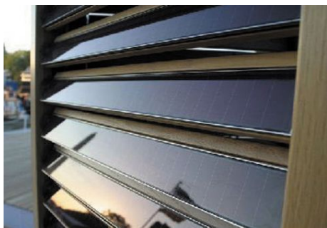
Εικόνα 20. Οι κινητές φωτοβολταϊκές περσίδες παράγουν ρεύμα όταν είναι κλειστές και προστατεύουν παράλληλα το κτίριο από τον ήλιο.
