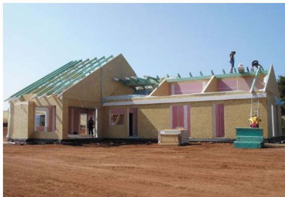
Εικόνα 71. Οι τοίχοι της κατοικίας συναρμολογούνται στο χώρο κατασκευής.
