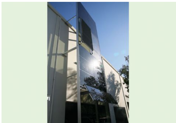
Εικόνα 28. Τα φωτοβολταϊκά thin films τοποθετούνται σε μια γυάλινη επιφάνεια σε λεπτές στρώσεις.
