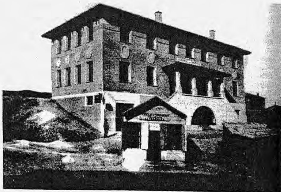
9. Σχολή και εργαστήριο ταπητουργίας και εργόχειρων στο Βύρωνα.
