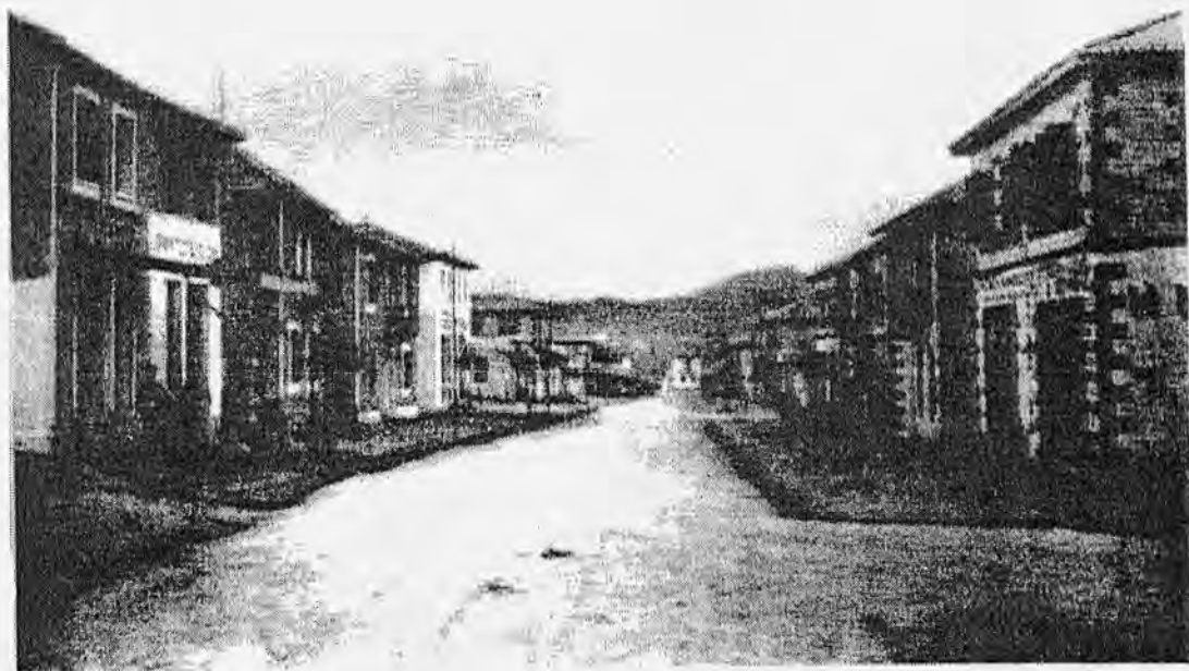
20. Νέα Ιωνία: εμπορικός δρόμος και κατοικίες από έγχαση ή ΕΑΠ...
