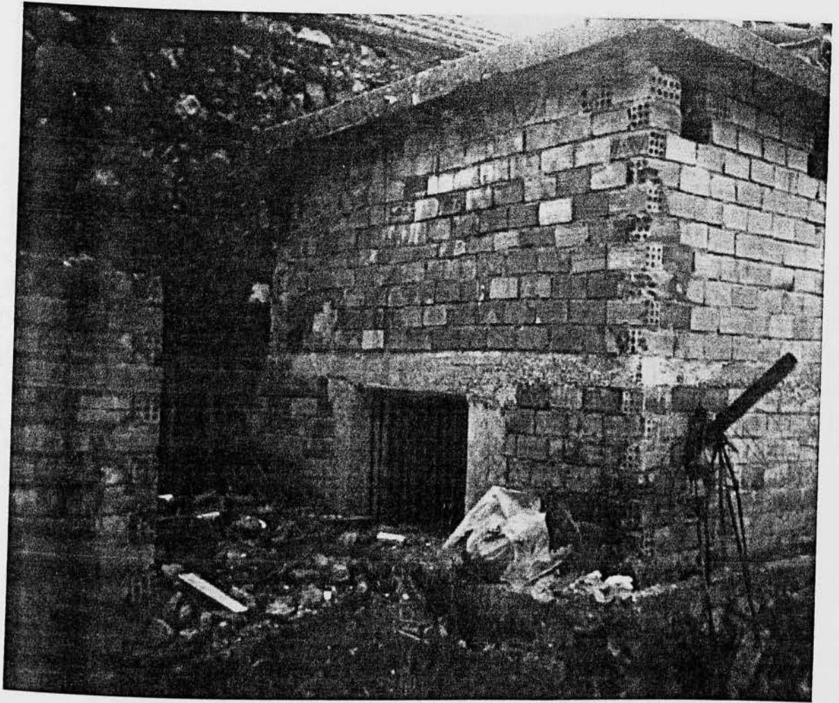
ΝΟΤΙΑ ΠΛΕΥΡΑ ΤΟΥ ΕΛΑΙΟΤΡΥΒΕΙΟΥ
