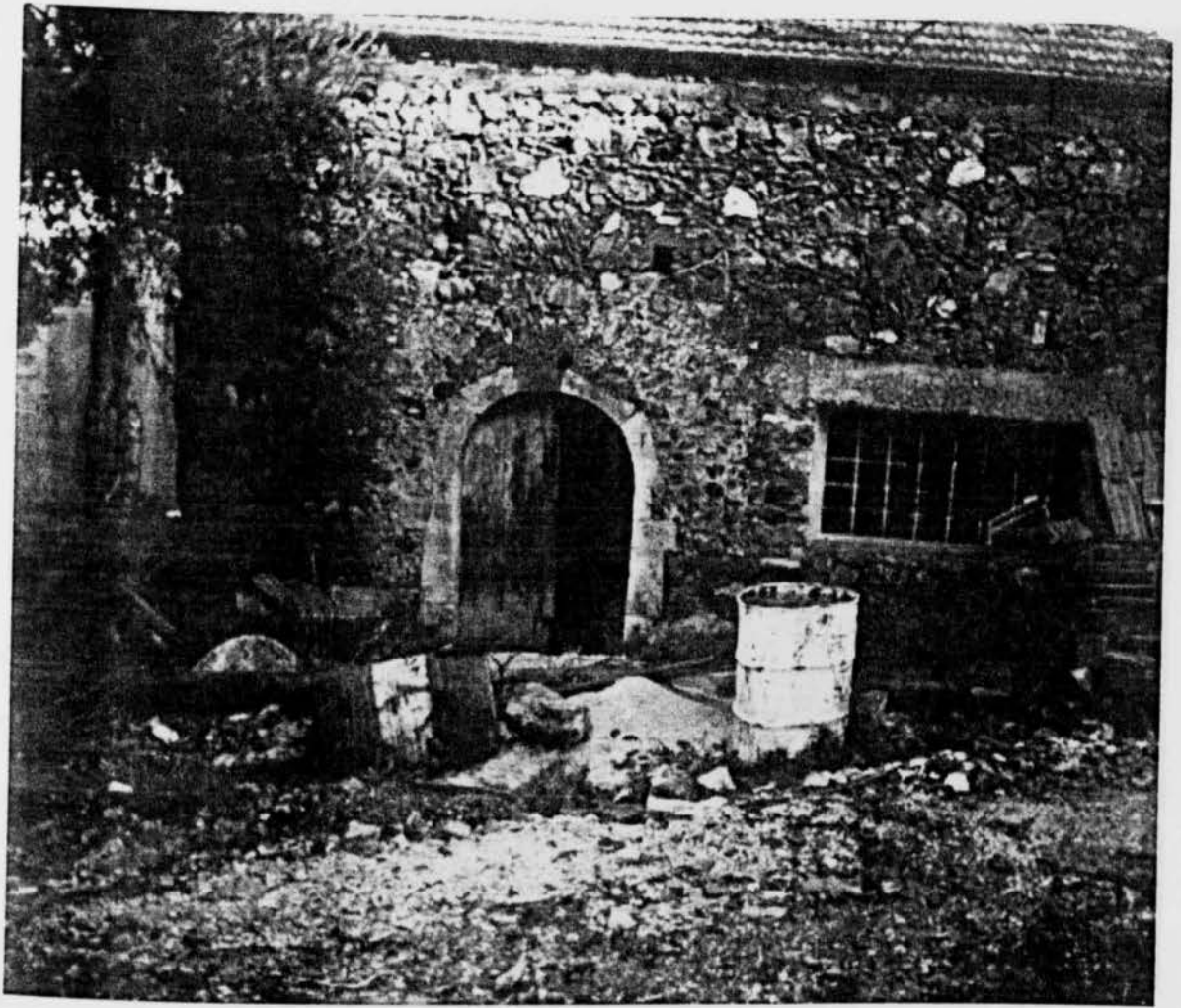
ΔΥΤΙΚΗ ΠΛΕΥΡΑ ΤΟΥ ΕΛΑΙΟΤΡΥΒΕΙΟΥ
