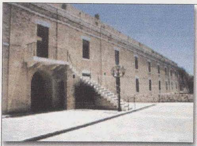
Εικόνα 192. Άποψη σημερινή της βιβλιοθήκης εξωτερικά
