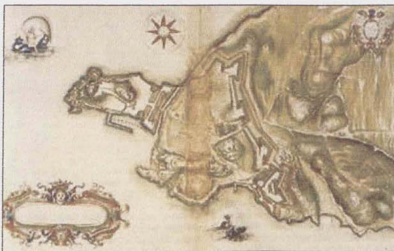
Εικόνα 13. Το περιμετρικό τείχος της Παλαιάς Πόλης. Τεχνικές Υπηρεσίες του Δήμου.
