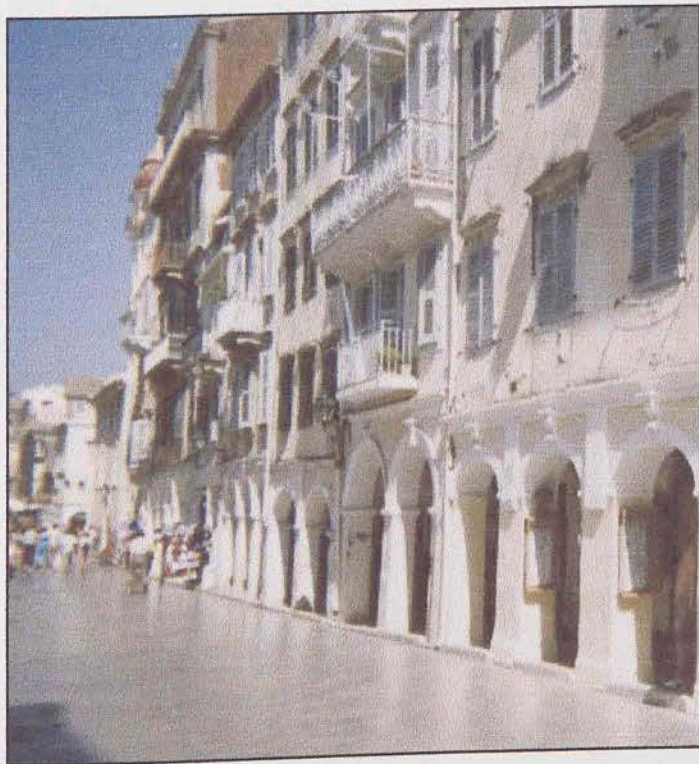
Εικόνα 112. Χαρακτηριστικές στοές μέσα στην πόλη.
