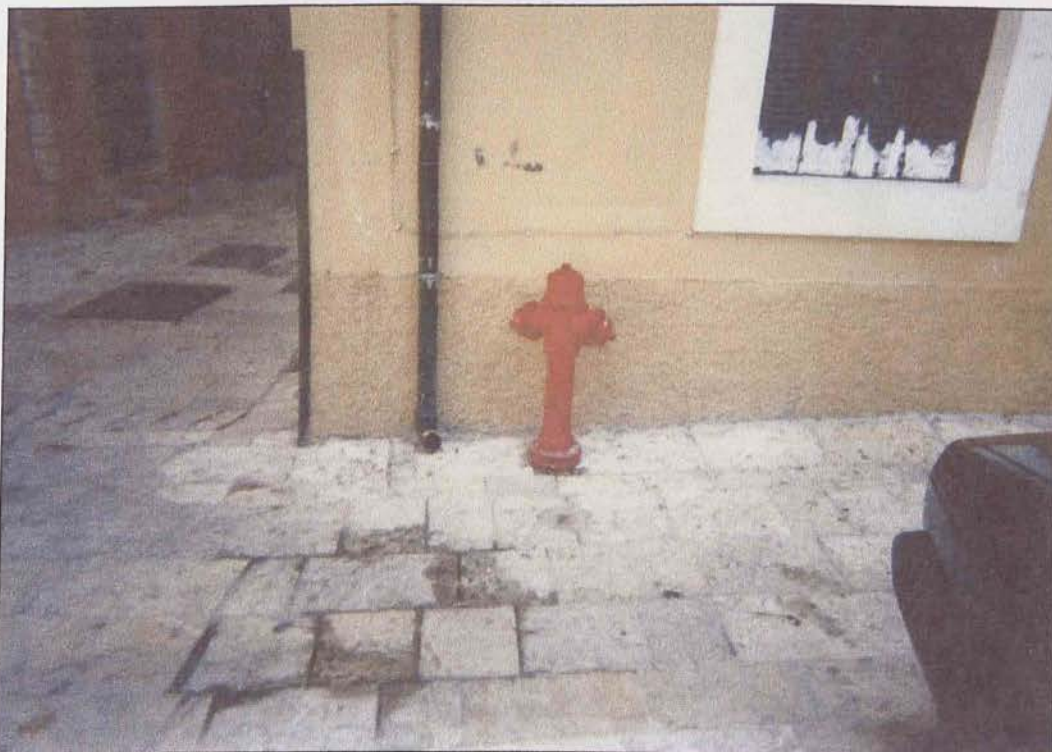
Εικόνα 102. Η εγκατάσταση πυροσβεστικών κρουνών κατέστησε την Παλαιά Πόλη ασφαλέστερη.
