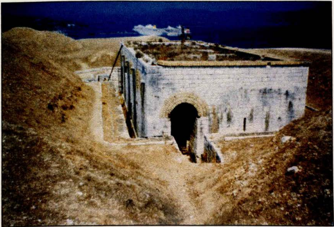
Εικόνα 232. Κτίριο φυλακών Αγγλοκρατίας στην κορυφή του Φρουρίου
