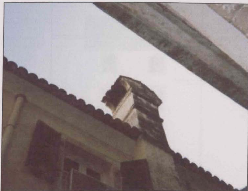
Εικόνα 118. Απόληξη καμινάδας σκεπασμένη με κεραμίδια
