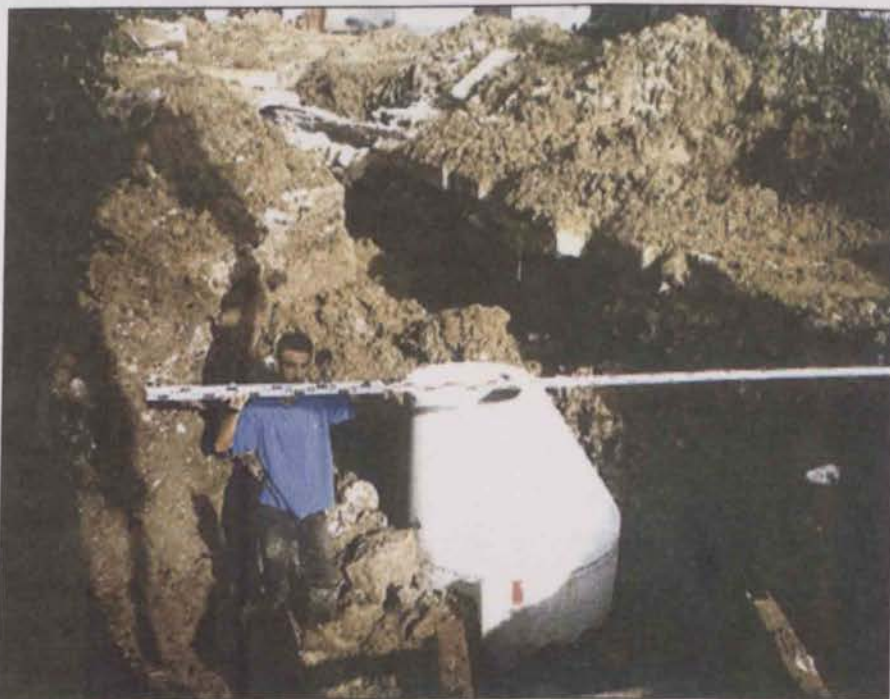
Εικόνα 107. Άποψη από τα έργα επέκτασης του αποχετευτικού δικτύου της πόλης.
