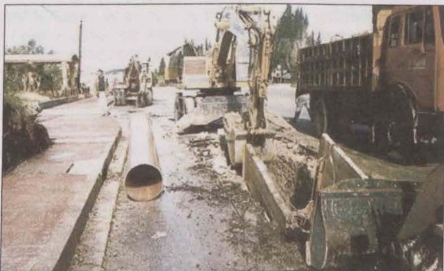
Εικόνα 106. Άποψη από τα έργα επέκτασης του αποχετευτικού δικτύου της πόλης.
