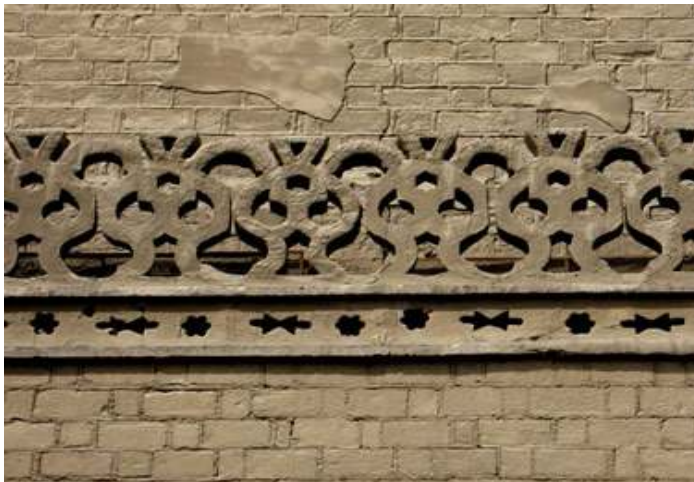
Εικόνα 6.9: Κατασκευή τοίχου από τούβλο
