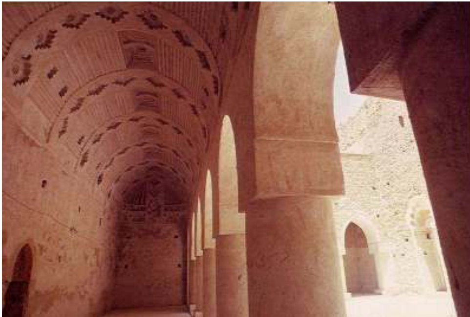
Εικόνα 10.4: Τοιχοποιίες με γυψοκονίαμα στο Ukhaidir.
