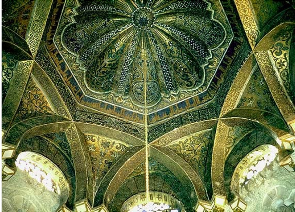
Εικόνα 10.7: Τέμενος Κόρδοβα- τρούλος με διασταυρωμένα τόξα.
