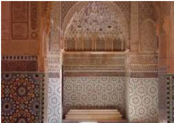
Εικόνα 6.17: Κατασκευή από ασβεστοκονίαμα σε συνδυασμό με μωσαϊκό
