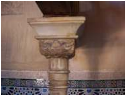
Εικόνα 7.9: λεπτομέρεια κολώνας στην αίθουσα Mexuar , που αποτελεί υποστύλωμα ξύλινου μπαλκονιού
