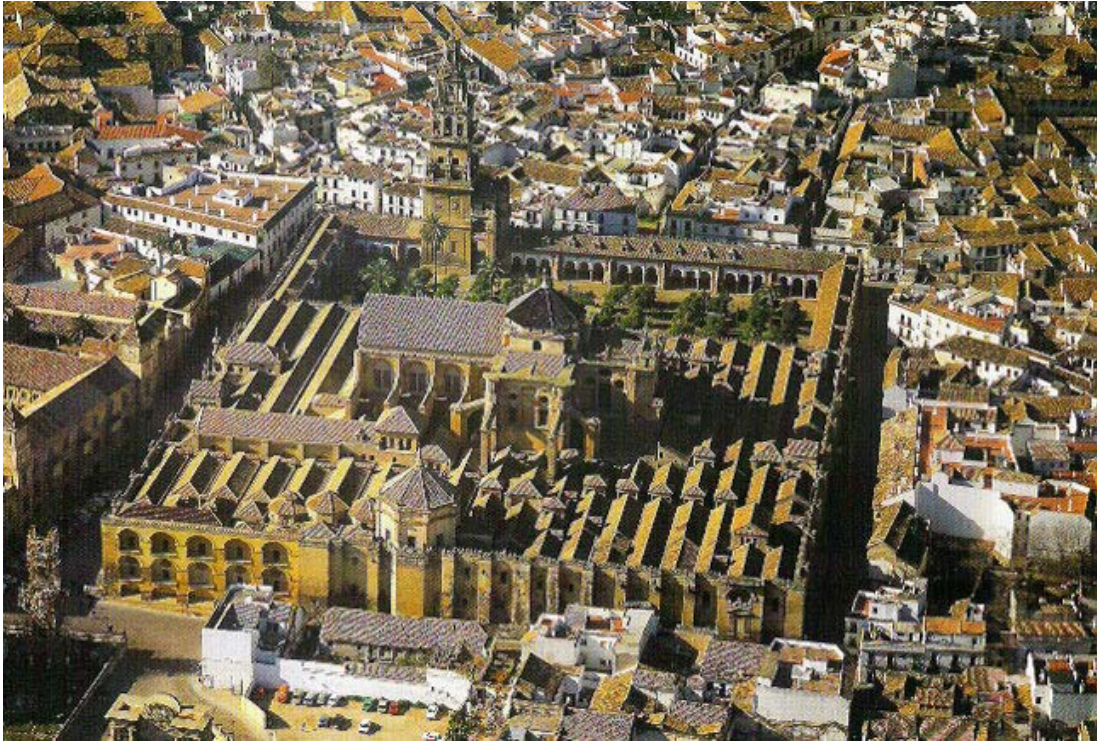
Εικόνα 10.5: Πανοραμική άποψη του Τεμένους της Κόρδοβα – δικλινείς στέγες.
