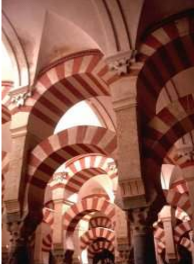
Εικόνα 6.6: Ενισχυμένες αψίδες στο τέμενος της Κόρδοβα
