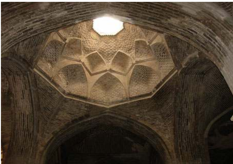
Εικόνα 6.8: Χαρακτηριστική κατασκευή Ισλαμικής πλινθοδομής
