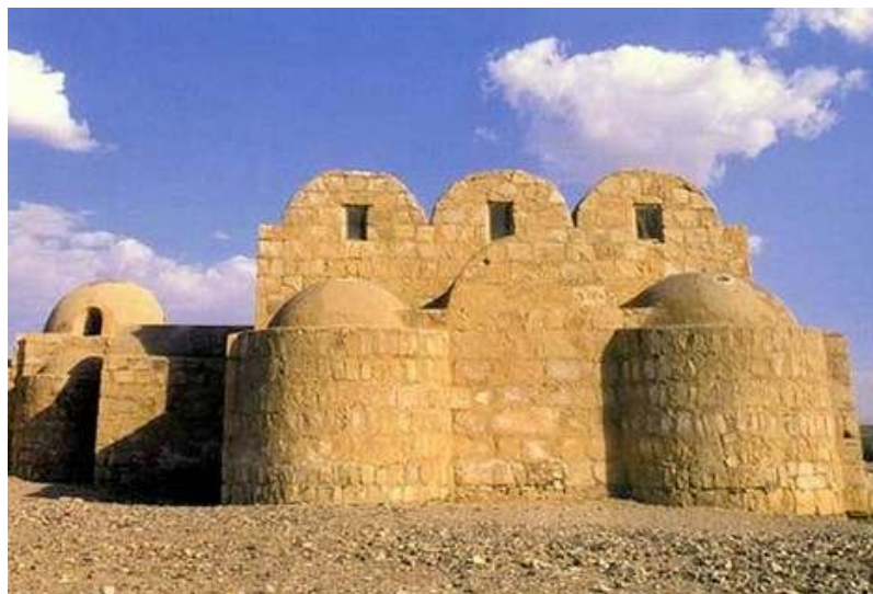
Εικόνα 10.3: Τέμενος Quasuar Amra- κτιστοί θόλοι.
