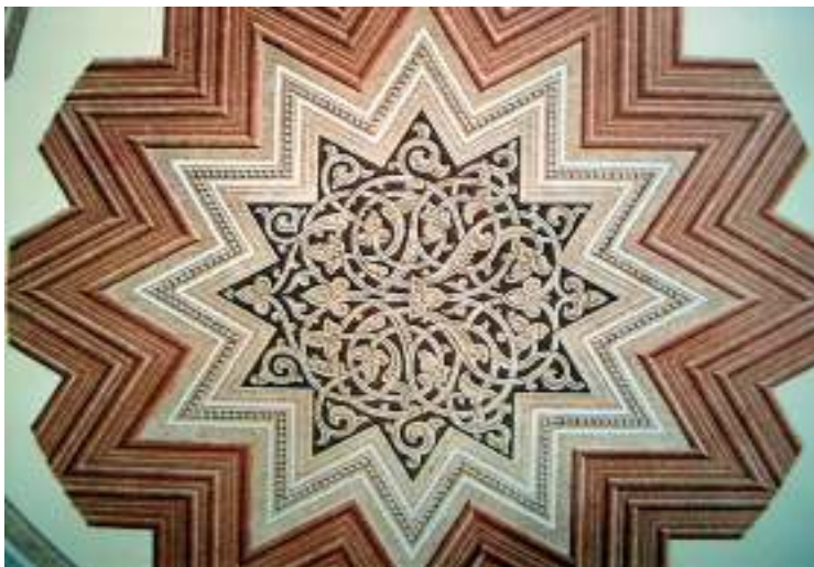
Εικόνα 6.13: Λεπτομέρεια ξύλινης κατασκευής σε minbar
