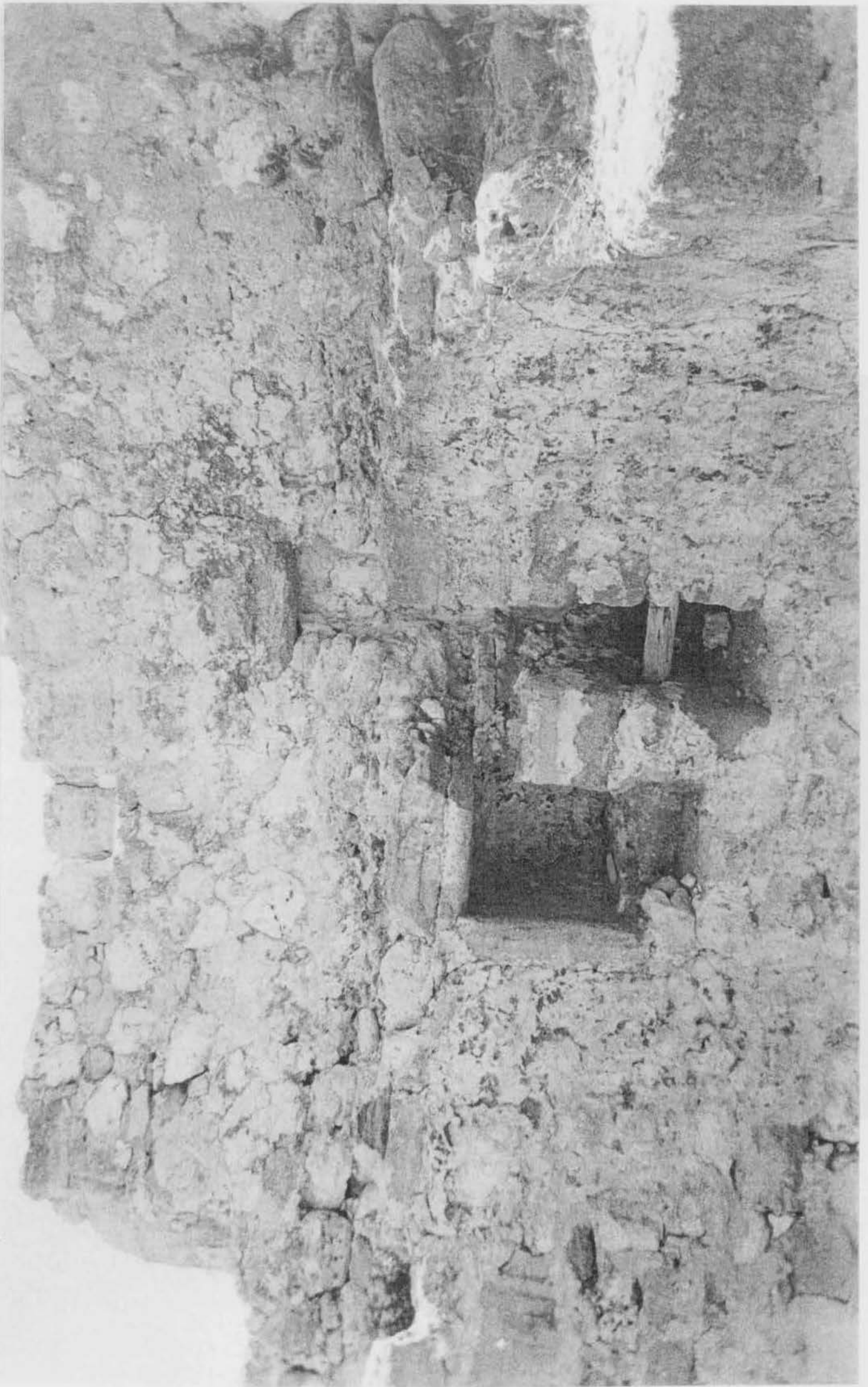
ΘΕΣΕΙΣ ΣΤΗΡΙΞΗΣ ΤΩΝ ΔΟΚΩΝ ΤΟΥ ΠΑΤΩΜΑΤΟΣ
