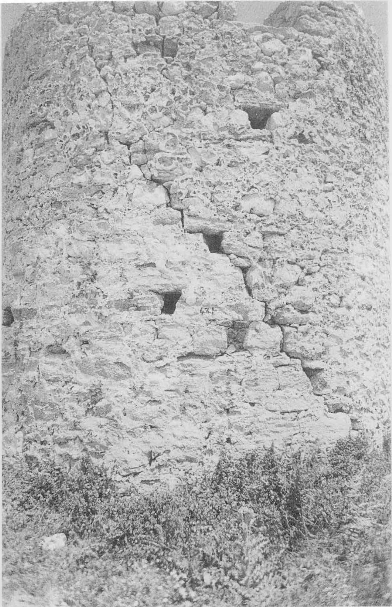
ΡΩΓΜΗ ΣΤΟ ΠΙΣΩ ΜΕΡΟΣ ΤΟΥ ΑΝΕΜΟΜΥΛΟΥ ΠΙΘΑΝΟΤΑΤΑ ΑΠΟ ΣΕΙΣΜΟ.
