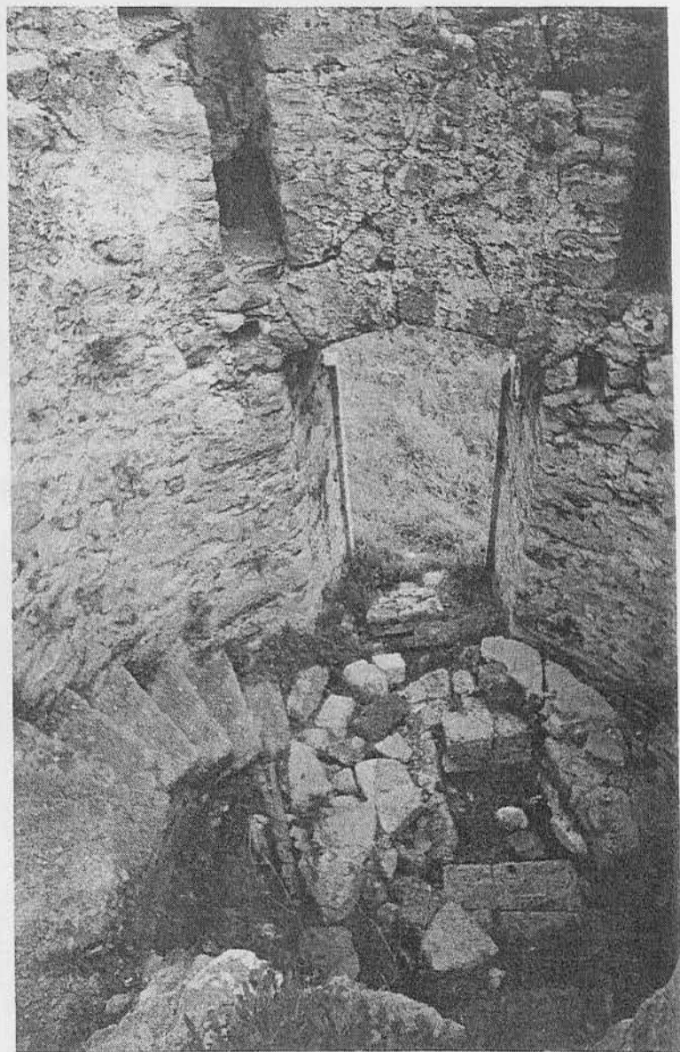
ΕΣΩΤΕΡΙΚΗ ΟΨΗ ΘΥΡΑΣ
