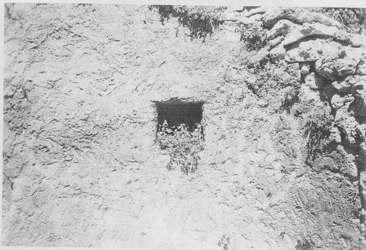
ΘΥΡΙΑΔΕΣ ΣΤΟΝ ΤΟΙΧΟ ΓΙΑ ΤΗΝ ΣΤΗΡΙΞΗ ΤΟΥ ΜΕΣΟΠΑΤΩΜΑΤΟΣ
