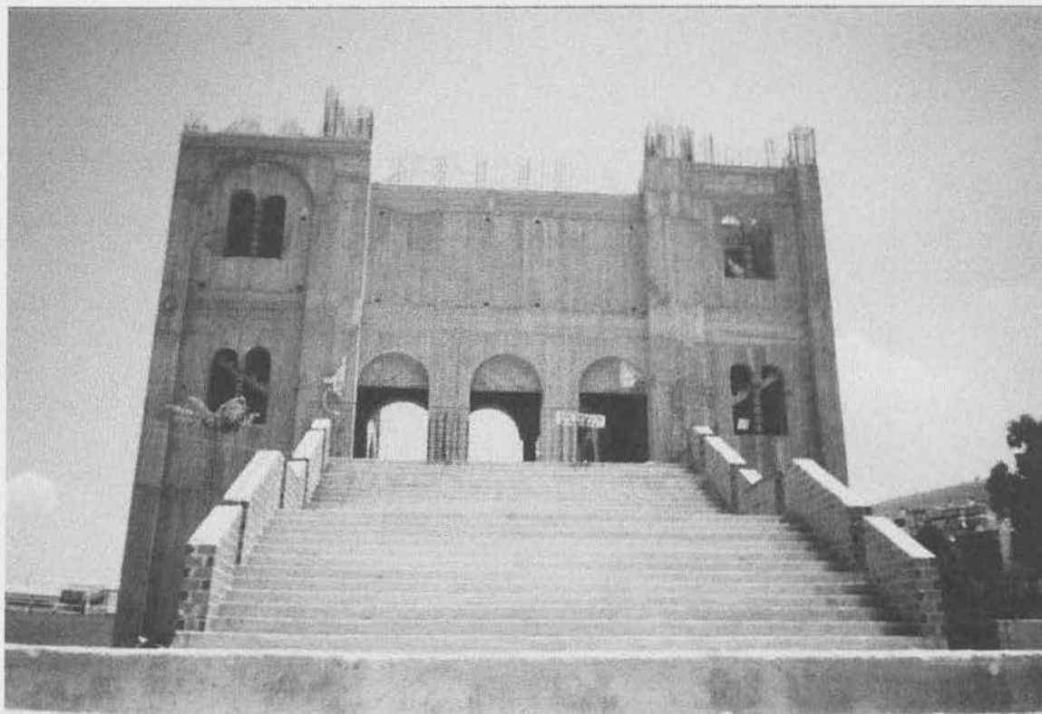
Εικ. 264 Υπό κατασκευήν ναός του Αγ. Παύλου (οδός Ελλήνων Αξιωματικών)
