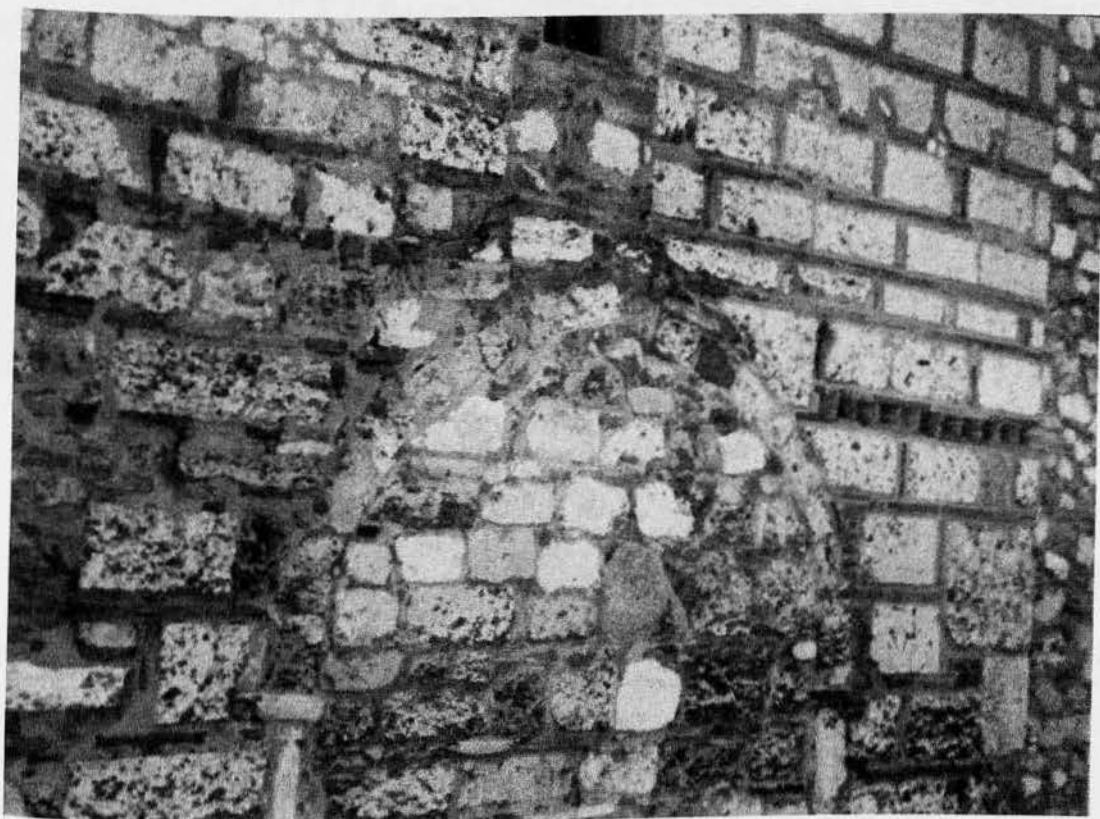
Εικ. 221 Λεπτομέρεια δόμησης τοίχου εκκλησίας Μεταμόρφωση Σωτήρος
