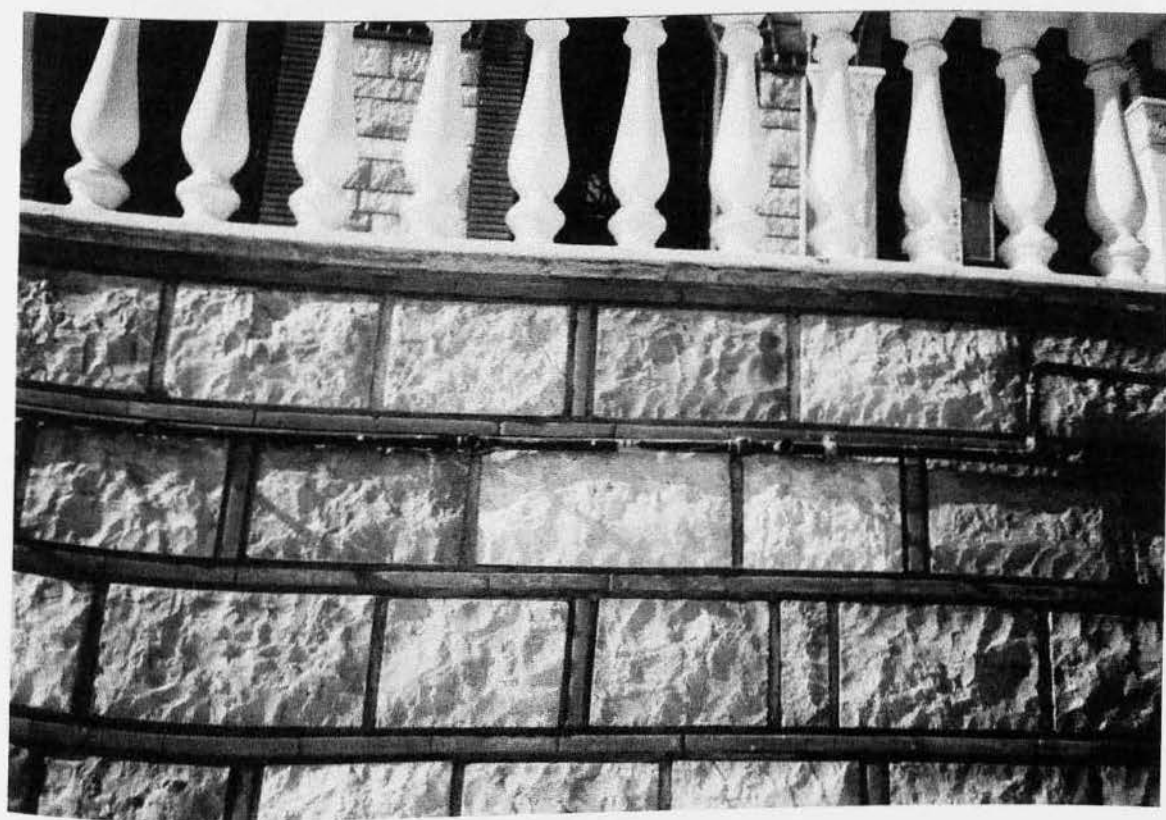
Εικ. 220 Λεπτομέρεια δόμησης τοίχου εκκλησίας Αγ. Φανουρίου
