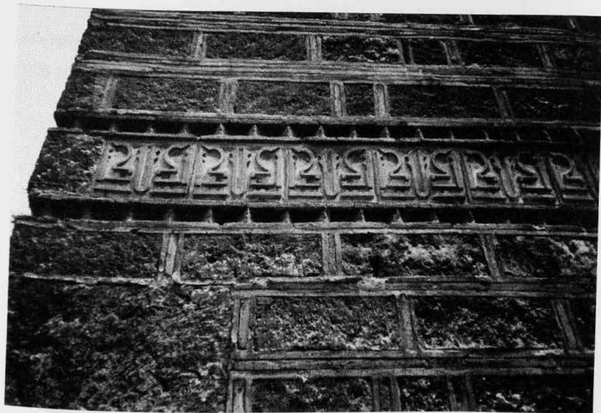
Εικ. 222 Λεπτομέρεια δόμησης τοίχου Ρώσικης εκκλησίας
