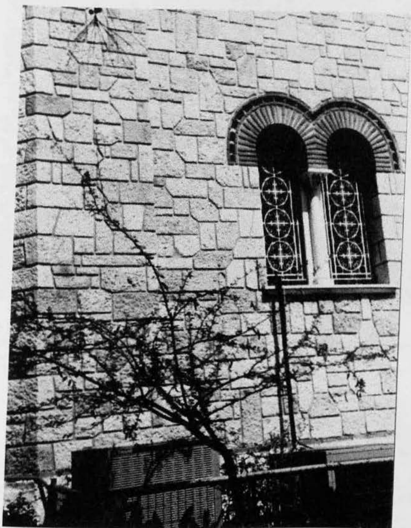
Εικ. 216 Κτίσιμο επενδεδυμένης πέτρας με ανισόδομο σύστημα
