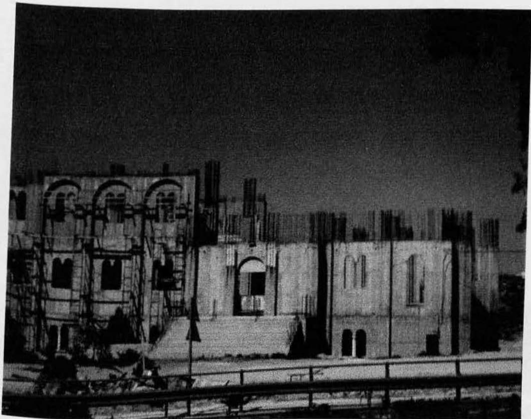
Εικ. 235 Υπό κατασκευή ναός του Αγ. Παύλου (Ελλήνων Αξιωματικών)
