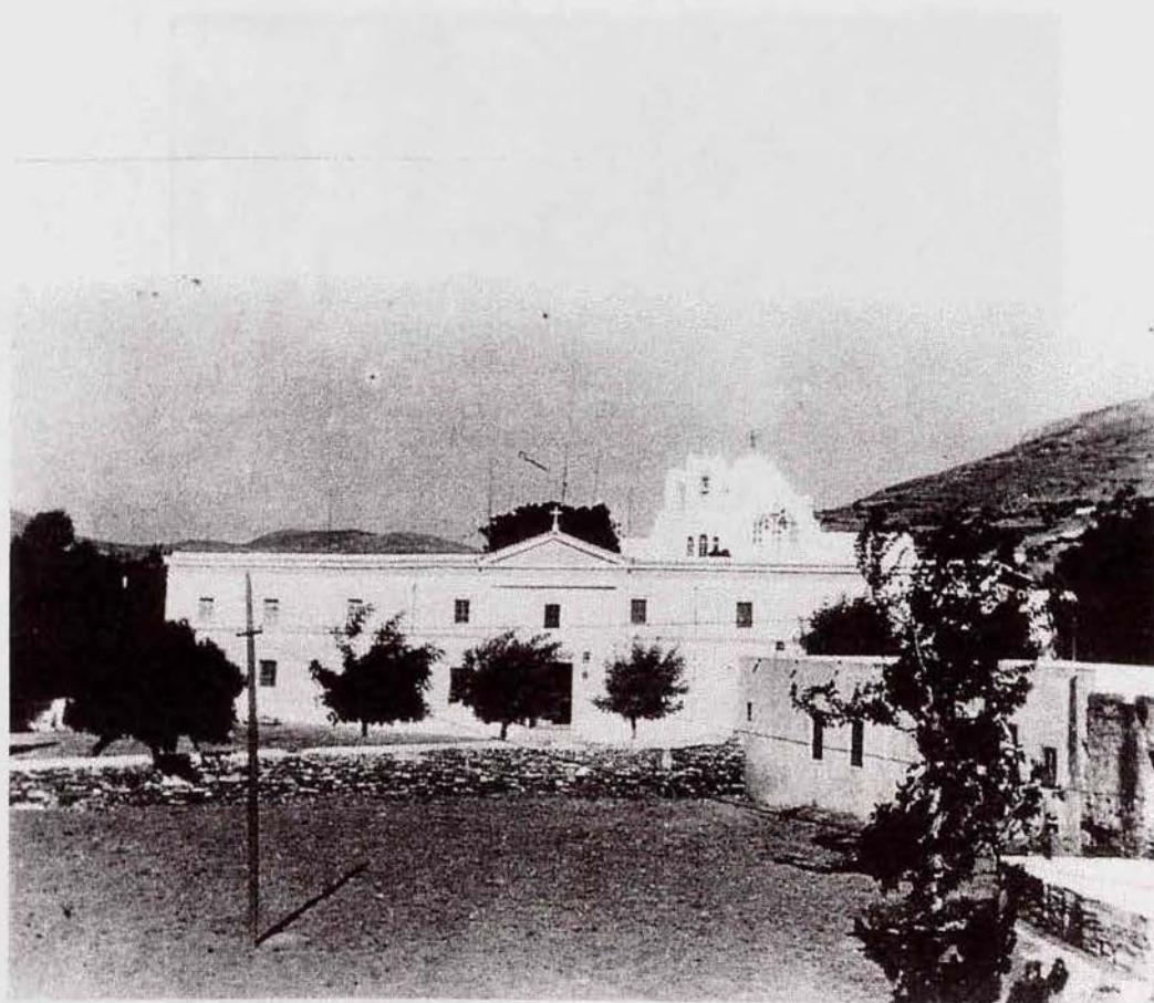
Εικ. 45 Γενική άποψη της Εκατονταπυλιανής πριν από την αναπαλαίωση
