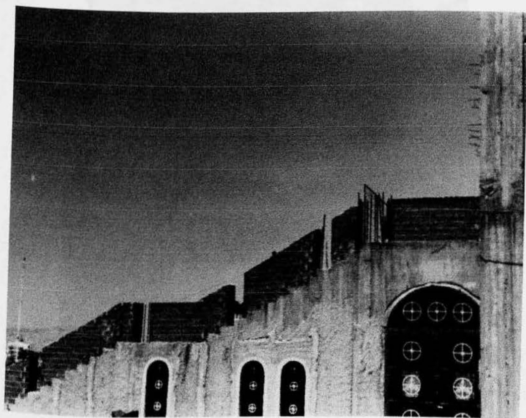
Εικ. 425 Υπό κατασκευή ναός του Αγ. Παύλου (Ελλ. Αξιωματικών)
