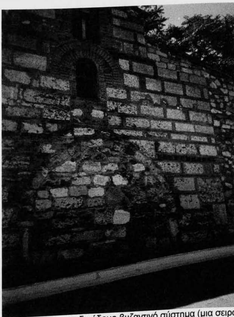
Εικ. 217 Κτίσιμο πέτρας με ψευδισόδομο βυζαντινό σύστημα (μια σειρά πέτρα, μια σειρά τούβλο εναλλάξ).
