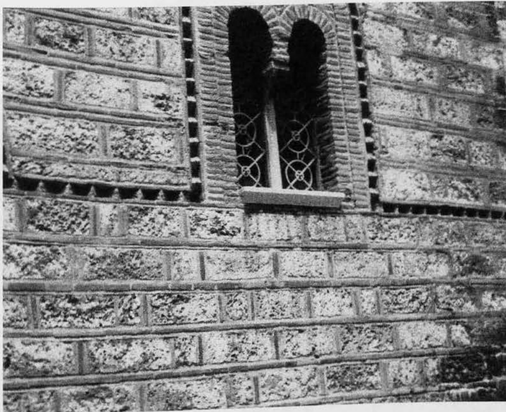
Εικ. 217 Κτίσιμο πέτρας με ψευδισόδομο βυζαντινό σύστημα (μια σειρά πέτρα, μια σειρά τούβλο εναλλάξ).
