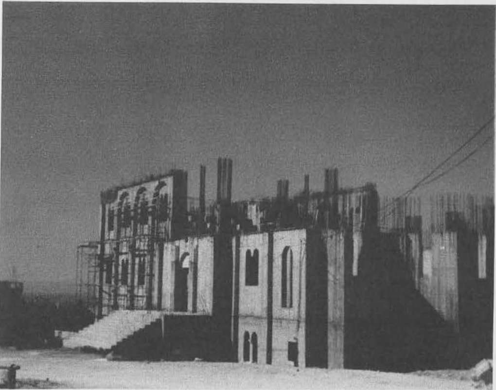
Εικ. 269 Υπό κατασκευήν ναός του Αγ. Παύλου (οδός Ελλήνων Αξιωματικών)
