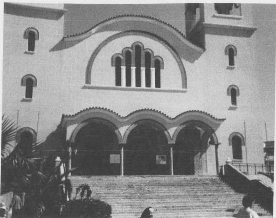
Εικ. 422 Εκκλησία Αγ. Τριάδας (Αλεξιοπούλεως – Αργυρούπολη), η οποία βρίσκεται στο τελευταίο στάδιο της κατασκευής της στην όψη της και στην επένδυση των σκαλοπατιών της.
