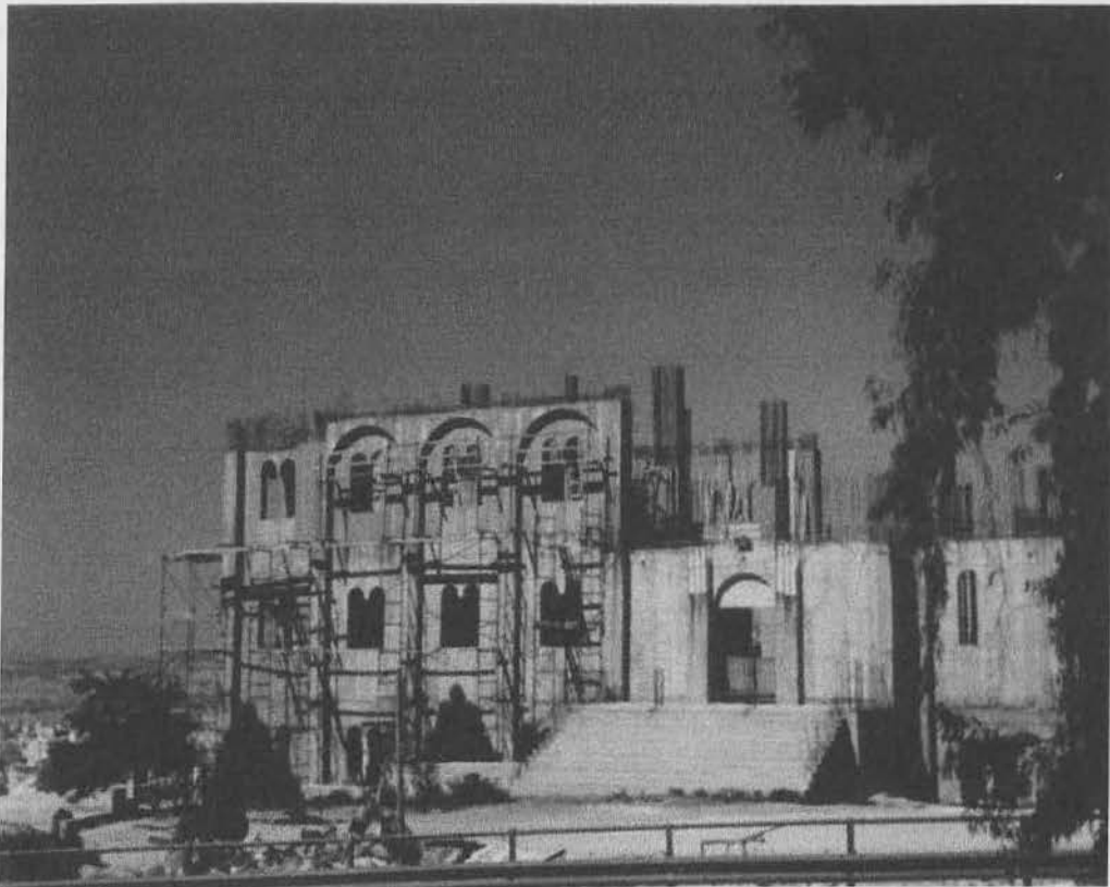
Εικ. 270 Υπό κατασκευήν ναός του Αγ. Παύλου (οδός Ελλήνων Αξιωματικών)
