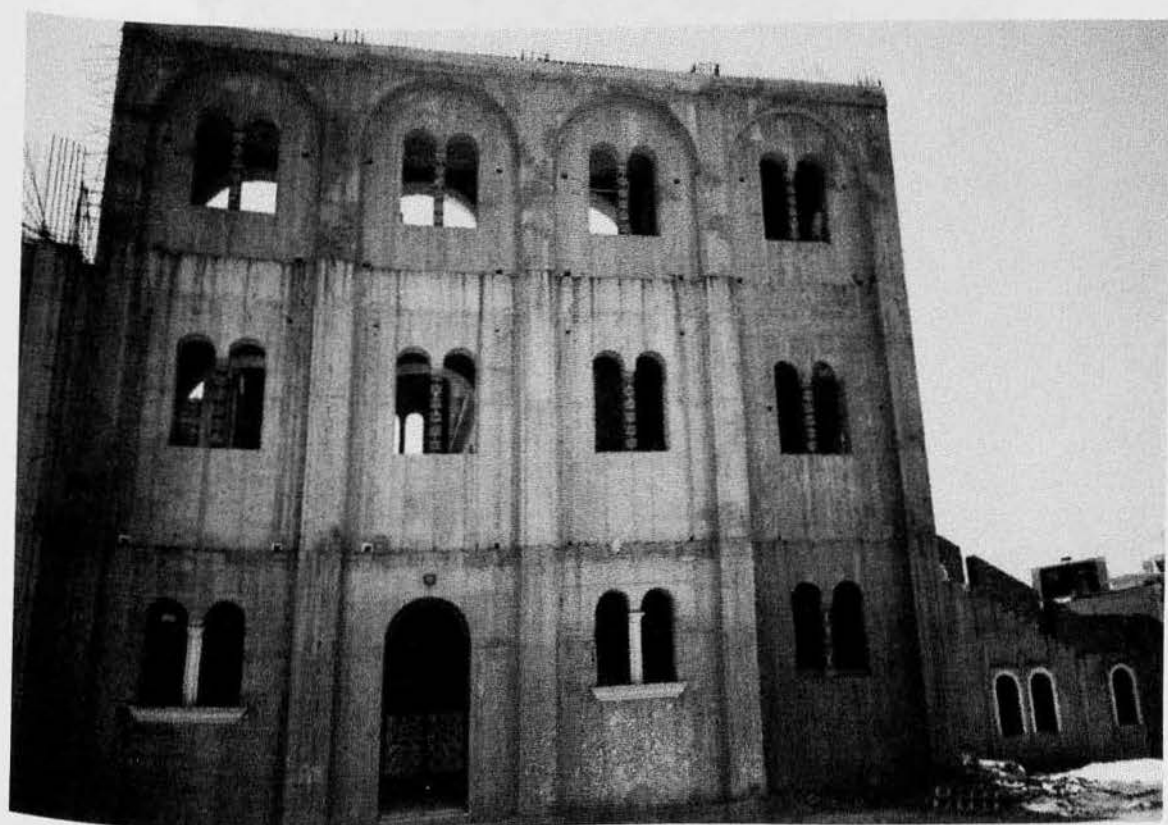
Εικ. 237 Υπό κατασκευή ναός του Αγ. Παύλου (Ελλήνων Αξιωματικών)
