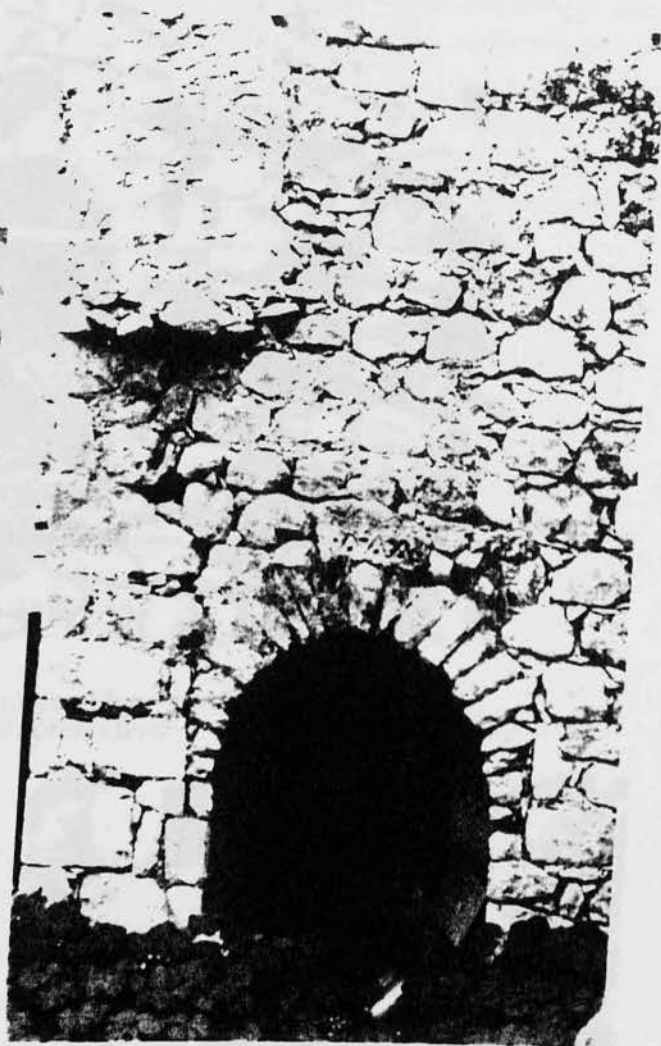
φωτ.7 Είσοδος με κυκλικό γωνιακό κλουβί. Οικία Κουτάκου.
