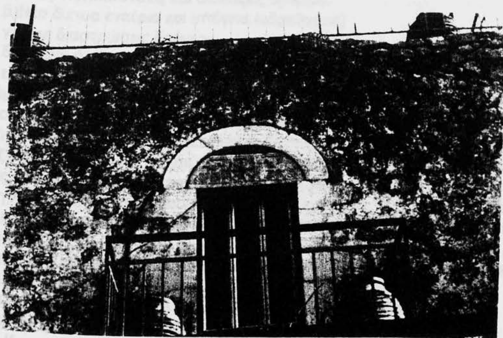
φωτ.22. Χαρακτηριστικό παράδειγμα ατυχούς αντικατάστασης κουφωμάτων και μπαλκονιού.
