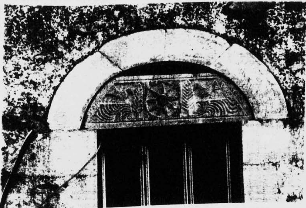
φωτ.2 Πόρτα με ανακουφιστικό τόξο και σκαλισμένο υπέρθυρο στο σπίτι του Κ.Λυμπέρη
