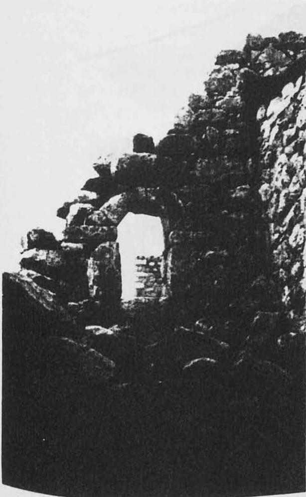
φωτ. 9. Παράθυρο με τοξωτό ανώφλι από δυο πέτρες.
