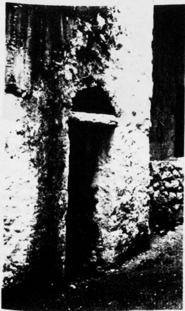
φωτ. 19. Ανοίγμα στο σπίτι του Γ. Καβούρη.
