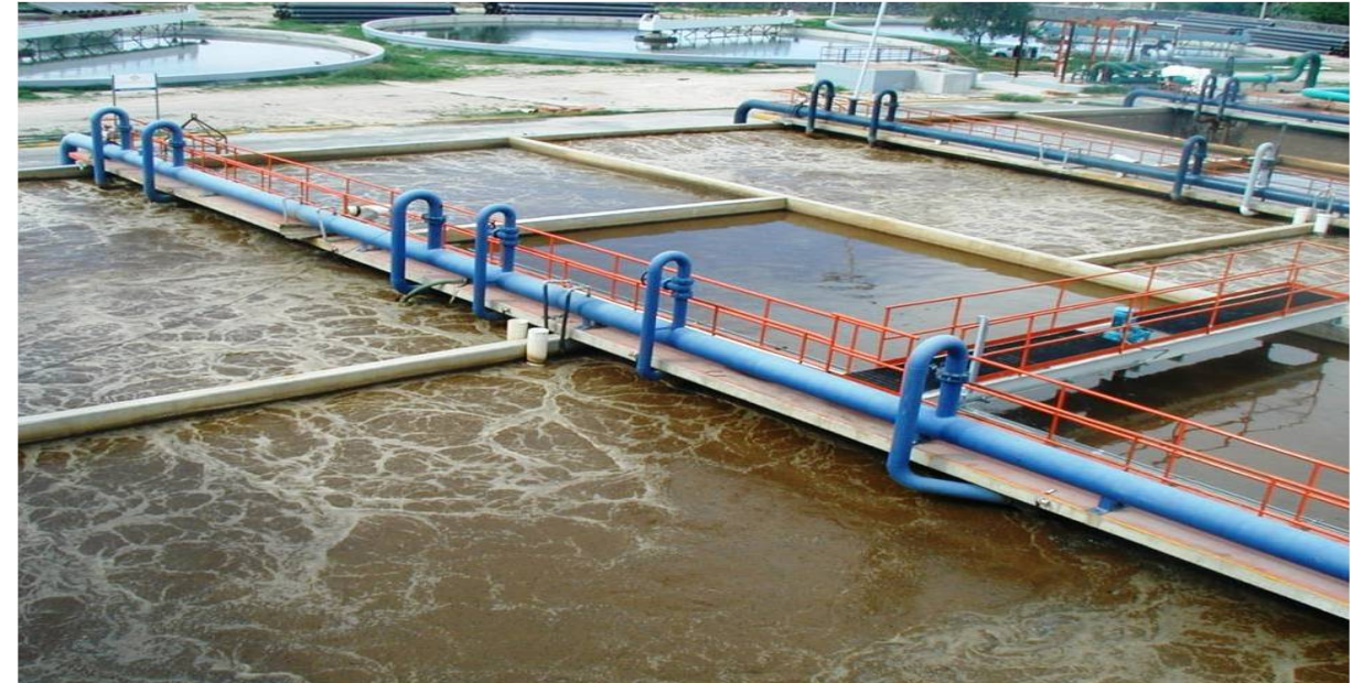
Εικόνα 3.1 Επεξεργασία λυμάτων με τη μέθοδο M.B.B.R
