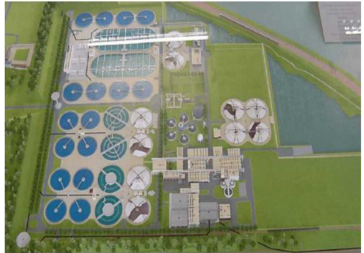
Εικόνα 5.2: Εγκαταστάσεις επεξεργασίας λυμάτων της ΜΕΛ Seine Amont.
