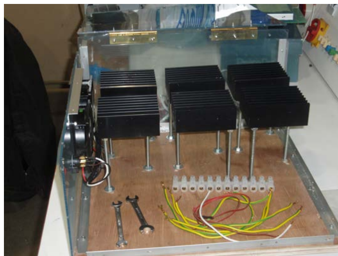
Σχήμα 4.7 Αρχικό στάδιο κατασκευής του κυκλώματος ισχύος
