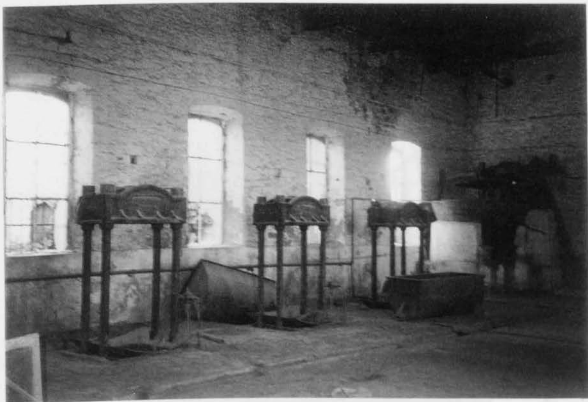
28. Πιεστήρια και ο δεύτερος ελαιόμυλος στο ελαιοτριβείο Μητρέλια. Οι δύο μύλοι μαρτυρούν τη μεγάλη παραγωγή του.
