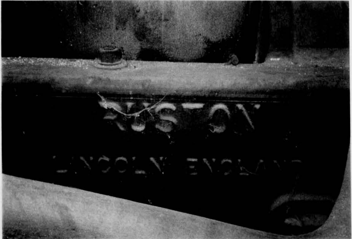
13. Στην ατμομηχανή διακρίνεται η φίρμα «Ruston Lincoln – England». Ελαιοτριβείο Κοκκινοφόρου.
