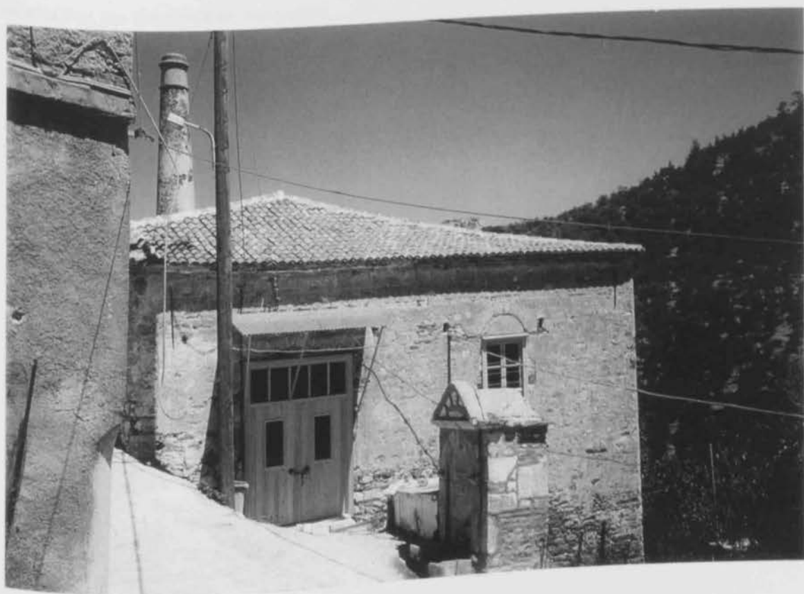
85. Δυτική όψη ελαιοτριβείου Νεοχωρίου. Οι επισκευές έχουν αρχίσει.
