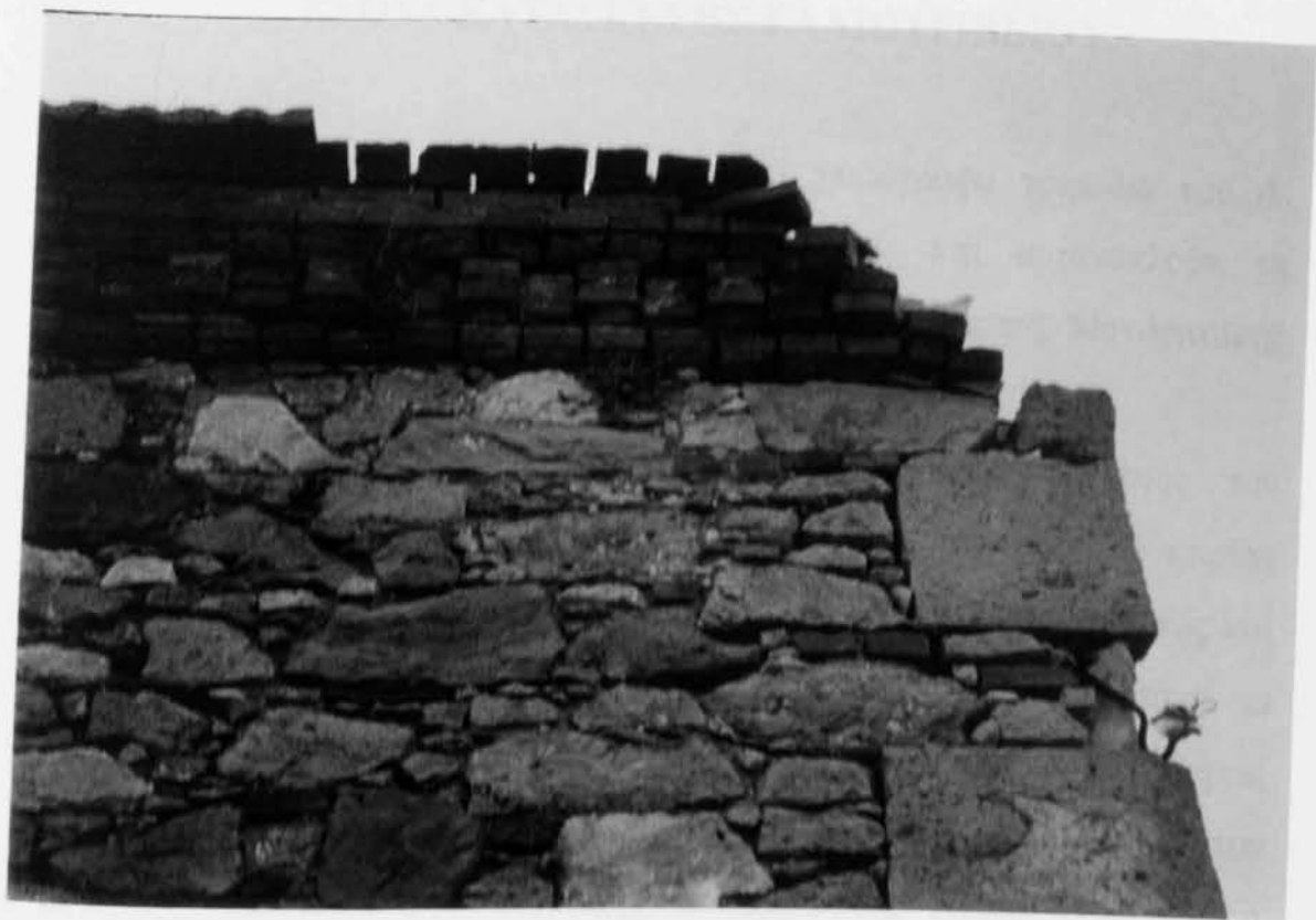
73. Ελαιοτριβείο Ψαρρού. Γρηπίδα στέγης από συμπαγή τούβλα σε παράλληλες σειρές και γωνιόλιθοι ακμών λιθοδομής.
