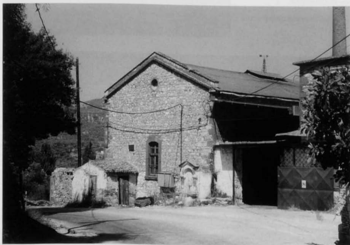
48. Πλάγια όψη του ελαιοτριβείου Κοκκινοφόρου στην πλευρά του δρόμου.
