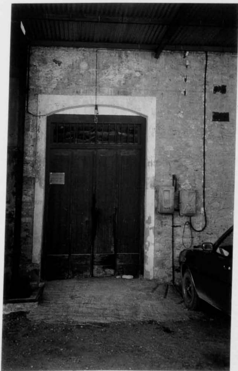
63 Οψη του ελαιοτριβείου Ιωάννου. Δίπλα στην είσοδο υπάρχει η δεξαμενή αποθήκευσης ελαιοπυρήνας (σιλό).
