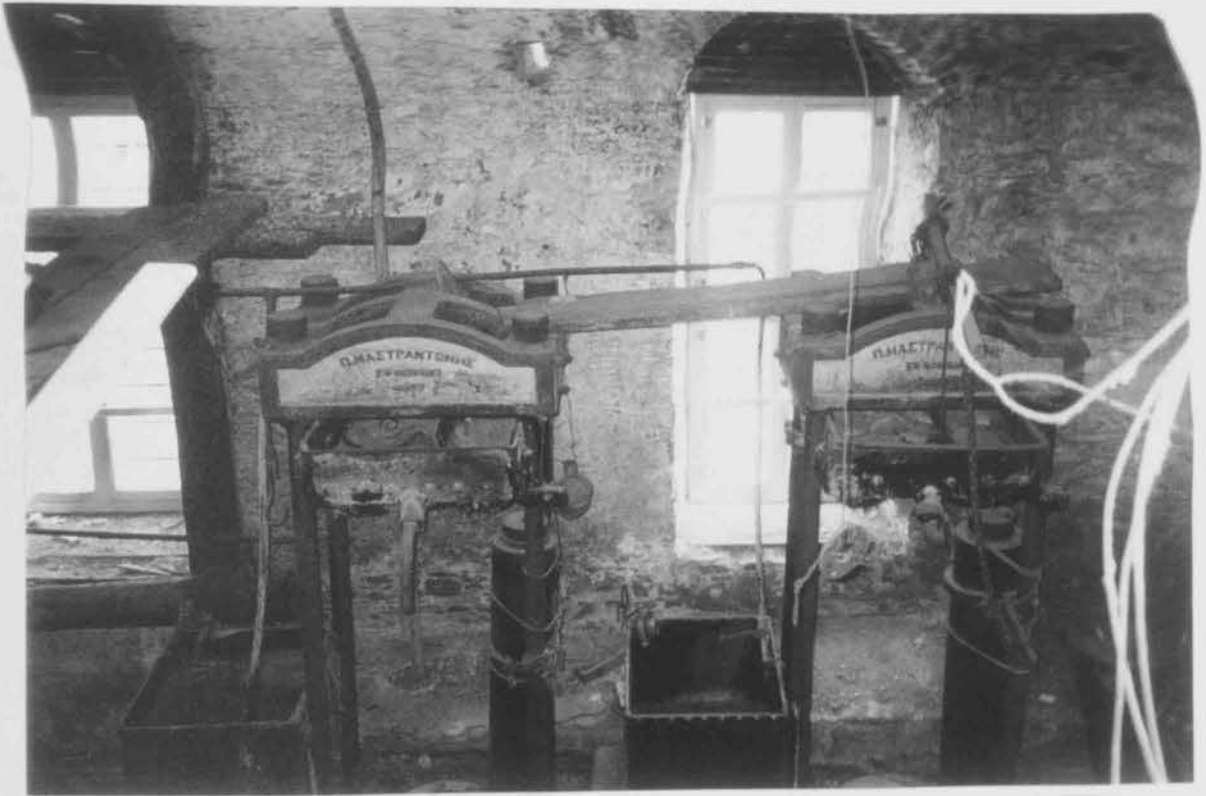
29. Πιεστήρια στο ελαιοτριβείο Νεοχωρίου. Διακρίνεται η φίρμα «Π. Μαστραντώνης – Εν Πειραιεί».
