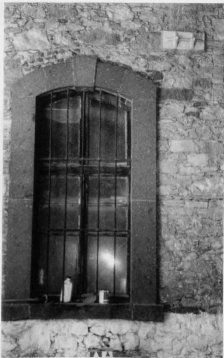
49. Παράθυρο στο κεντρικό κτίριο του ελαιοτριβείου Κοκκινοφόρου. Στην τοιχοποιία διακρίνονται τα παξιμάδια στήριξης των αξόνων των τροχών.
