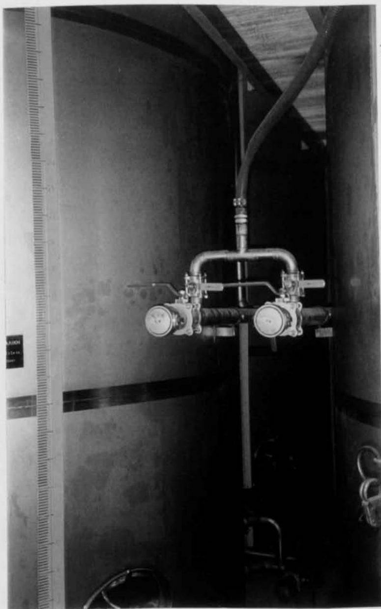
23. Οι σύγχρονες δεξαμενές λαδιού.
