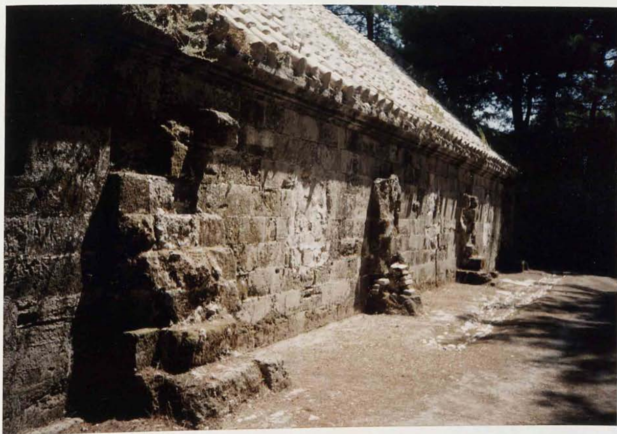
Φωτ. 43: Ενετική πυριτιδαποθήκη. Βόρεια όψη. Διακρίνεται η ανακατασκευασμένη στέγη και η συντηρημένη τοιχοποιία
