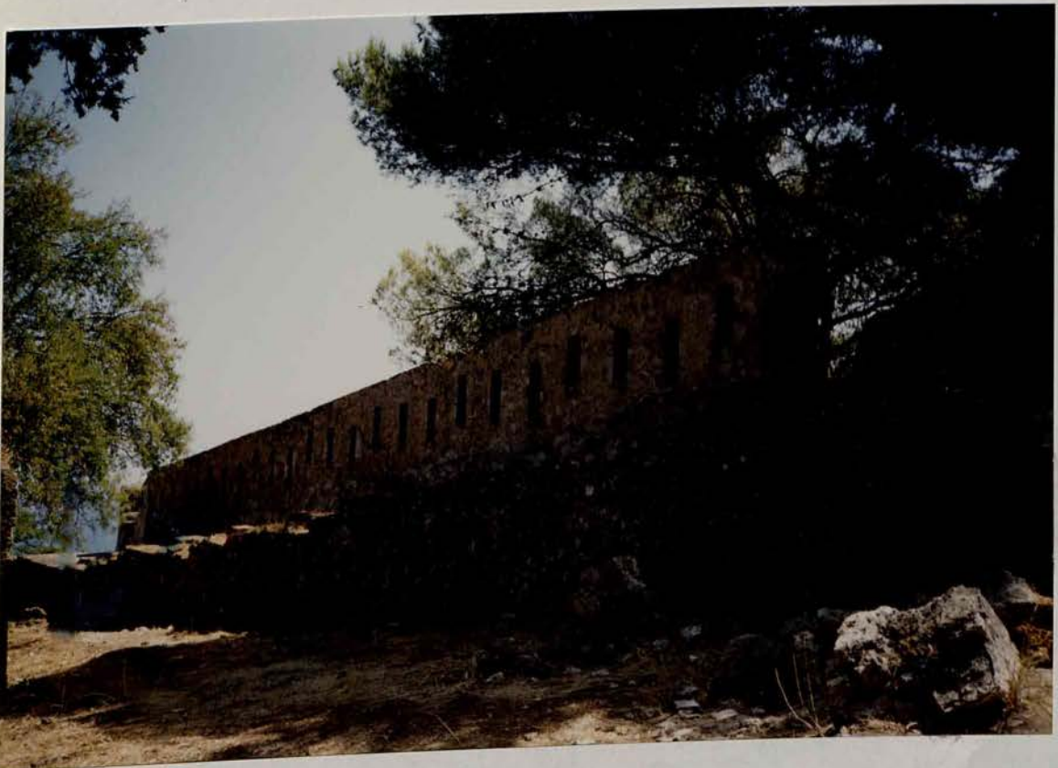
Φωτ. 9-10: Τμήματα του νότιου τείχους
