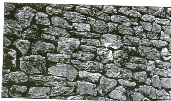
Εικόνα 44 : Όψη αργολιθοδομής
