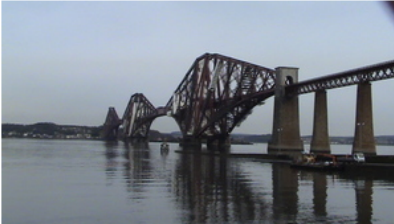
Εικόνα 53: Γέφυρα Φορθ Ρεϊλ
