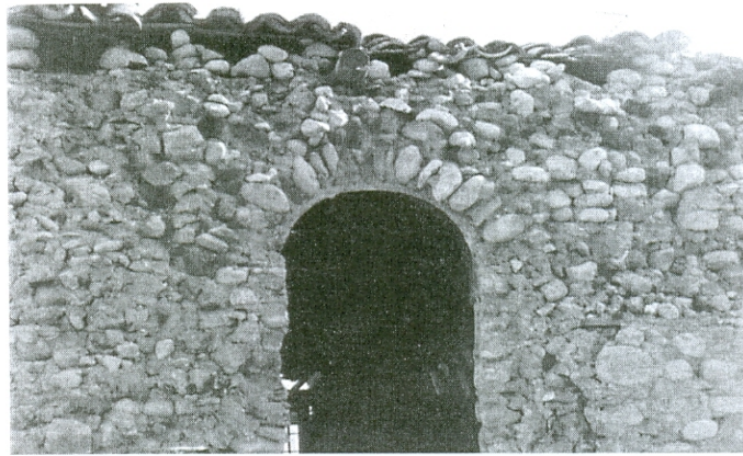
Εικόνα 45: Κροκαλολιθοδομή η εξωτερική στρώση της οποίας έχει καταρρεύσει από το σεισμό του Αιγίου.
