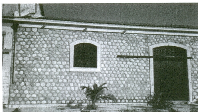
Εικόνα 47: Μωσαϊκή λιθοδομή
