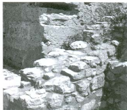
Εικόνα 50: Τομή αργολιθοδομής
