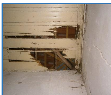
Εικόνα 1-35. Άνοιγμα στην οροφή με εμφανή τη στέγη, βόρεια τυφλή όψη & ρωγμή σε εσωτερική τοιχοποιία (Γ,Δ).
