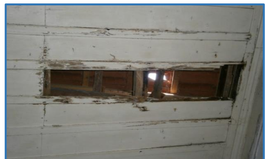
Εικόνα 1-12. Εσωτερική οπή στην οροφή, εμφανής κεραμοσκεπή.
