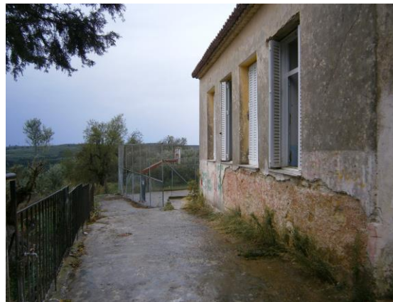
Εικόνα 1-10. Νότια όψη κτιρίου από την οδό πρόσβασης.
