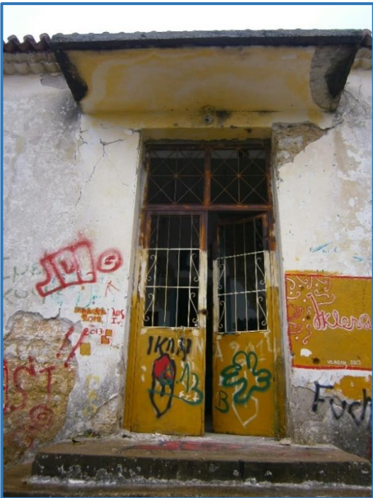
Εικόνα 1-38. Υφιστάμενη κατάσταση θύρας εισόδου.
