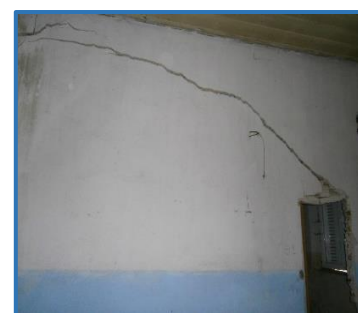
Εικόνα 1-35. Άνοιγμα στην οροφή με εμφανή τη στέγη, βόρεια τυφλή όψη & ρωγμή σε εσωτερική τοιχοποιία (Γ,Δ).
