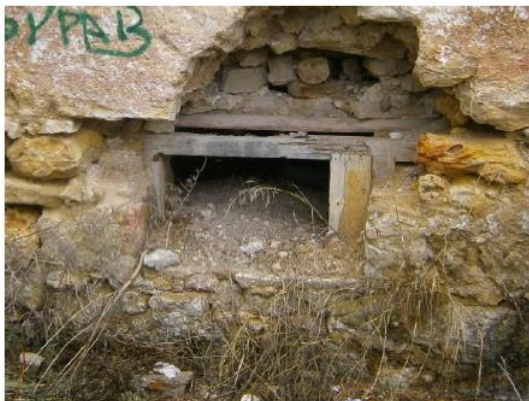
Εικόνα 1-23. Άνοιγμα εισόδου στη θεμελίωση & ζώνες θεμελίωσης χωρίς συνδετικό κονίαμα.
