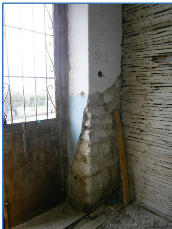
Εικόνα 1-34. Εκτεταμένη αποκόλληση στο χώρο Α.
