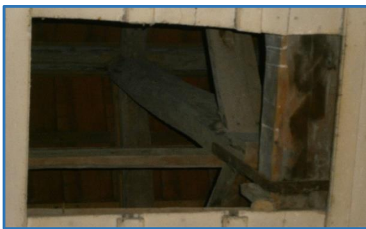
Εικόνα 1-11. Εμφανές το ξύλινο ζευκτό στήριξης της κεραμοσκεπής, από εσωτερική οπή στην ξύλινη οροφή.
