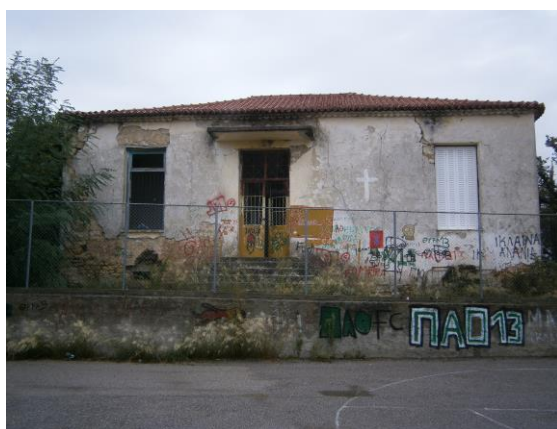
Εικόνα 1-7. Δυτική όψη κτιρίου – Είσοδος.
