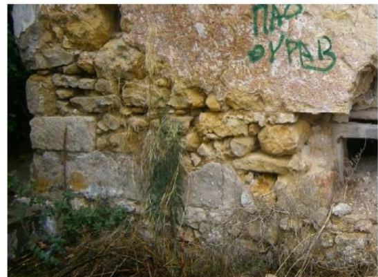
Εικόνα 1-23. Άνοιγμα εισόδου στη θεμελίωση & ζώνες θεμελίωσης χωρίς συνδετικό κονίαμα.
