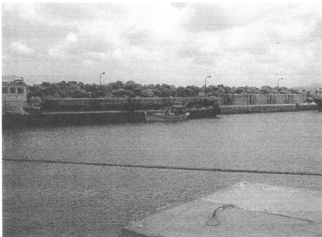
Φωτ. 3.1: Όψη Προσήμενου Μώλου – Τμήμα 7-8
