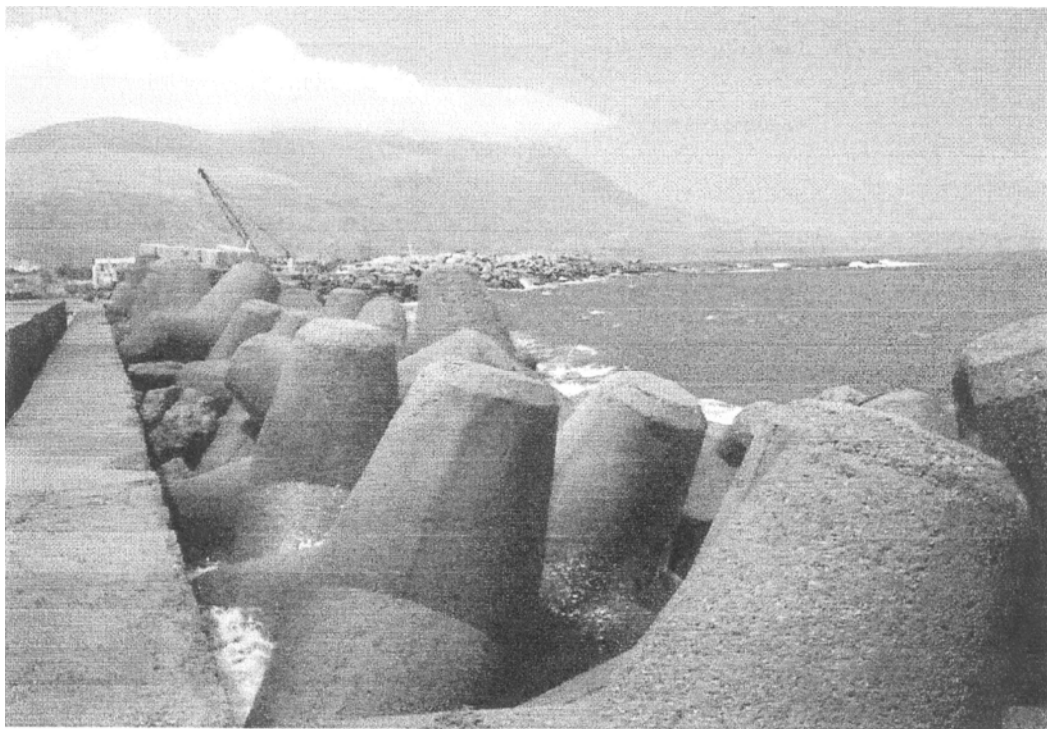
Φωτ. 3.7: Θωράκιση Προσήνεμου Μώλου στην περιοχή του ακρομωλίου- Όψη προς ΒΔ
