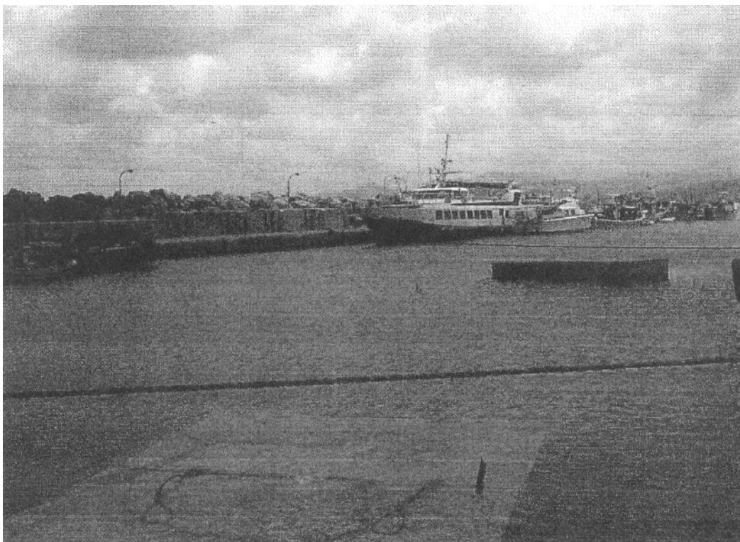
Φωτ. 3.25: Ποντισμένοι Τ.Ο. κατασκευής νέων Κρηπιδοτοίχων
