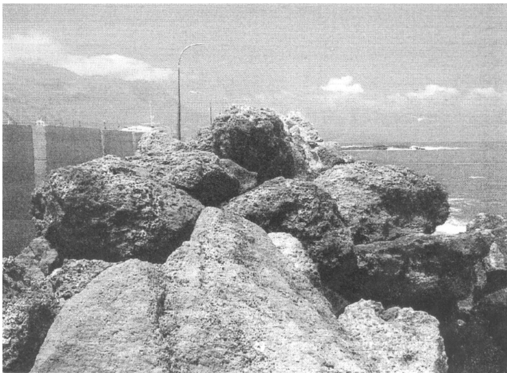
Φωτ. 3.9: Φυσικοί Ογκόλιθοι θωρακίσεως προσήνεμου μώλου – Τμήμα
