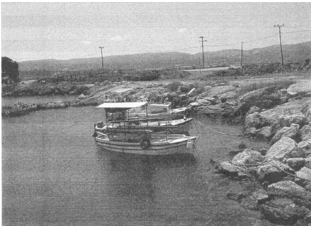
Φωτ. 3.15: Μικρό αλιευτικό καταφύγιο, χωρίς κρηπίδωμα
