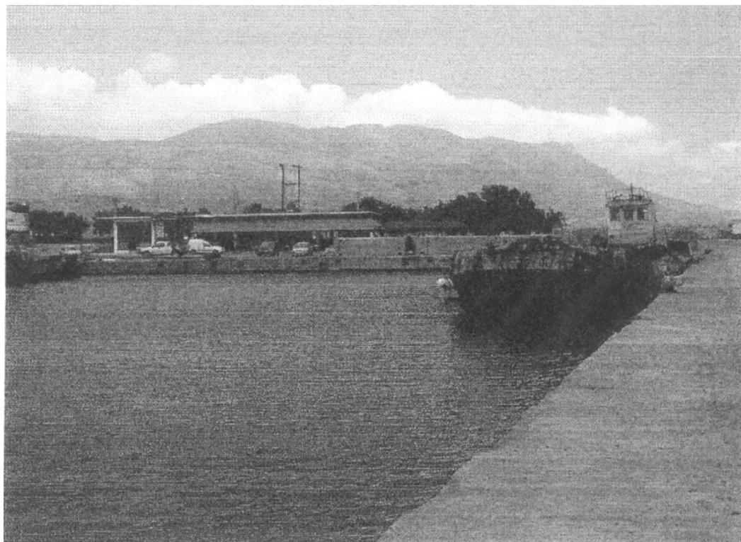
Φωτ. 3.11: Όψη παραλιακού κρηπιδώματος 9-10
