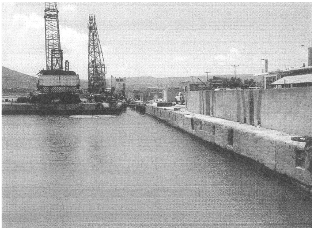
Φωτ. 3.12: Παραλιακό κρηπίδωμα 9-10: Όψη προς Ν
