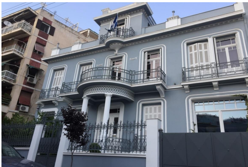
Εικ.43 : Μονοκατοικία στην οδό Κασσάνδρας , Πειραιάς
