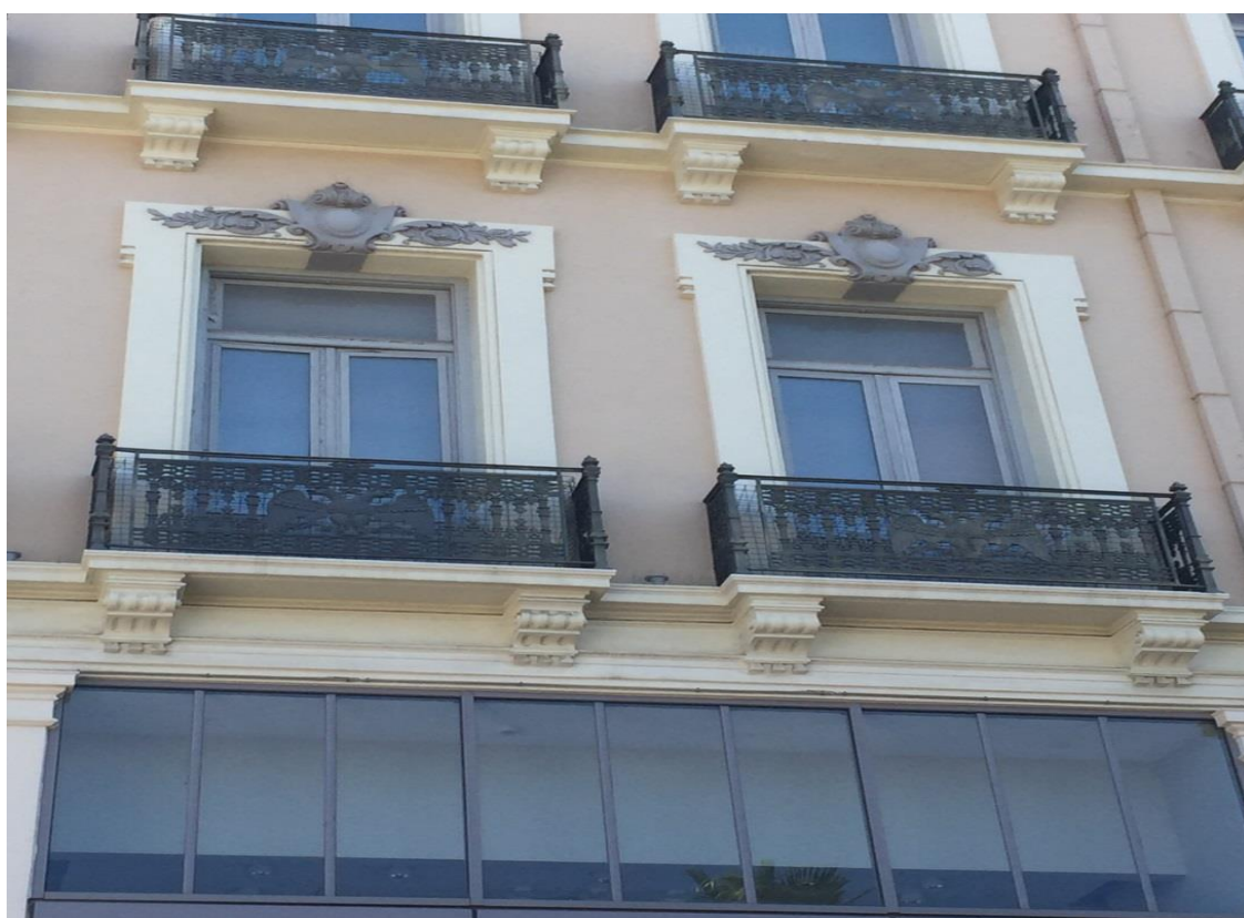
Εικ.77 : Λεπτομέρεια κιγκλιδωμάτων όπου στο κέντρο των οποίων σχηματίζεται ένας δικέφαλος αετός
