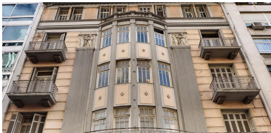
Εικ.1 : Το κτίριο του Μετοχικού Ταμείου Πολιτικών Υπαλλήλων , στην οδό Λυκούργου & Αθηνάς 56 , Ομόνοια , ένα έργο του Β. Κουρεμένου
