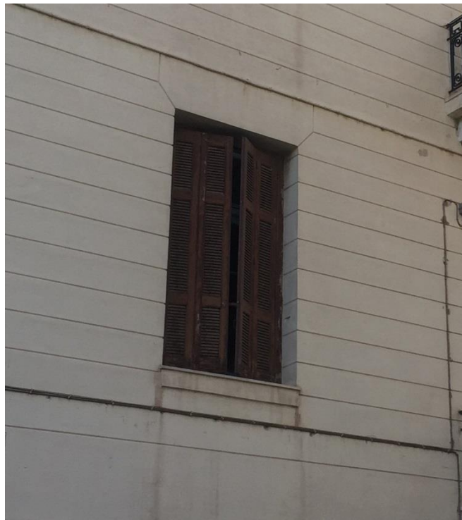
Εικ.64 : Λεπτομέρεια στην ποδιά του ανοίγματος , προεξέχουσα μαρμαροποδιά
