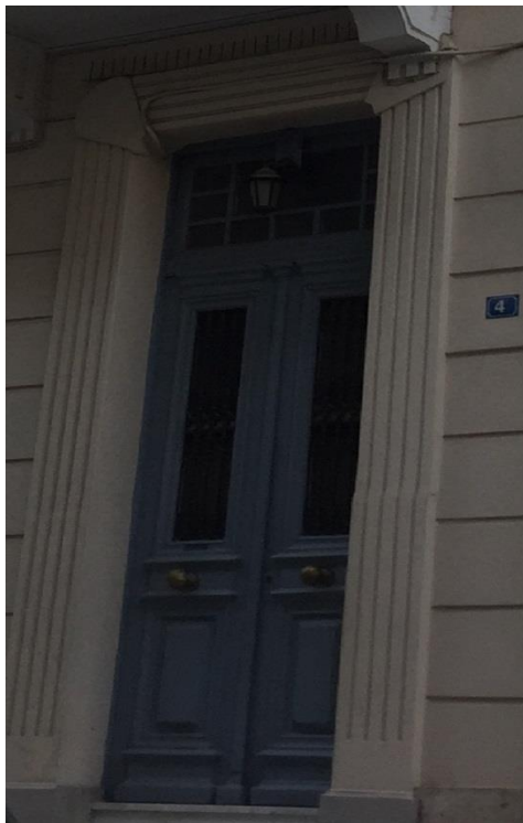
Εικ.70 : Λεπτομέρεια ξύλινης ταμπλαδοτής εξώθυρας με νεροχύτη
