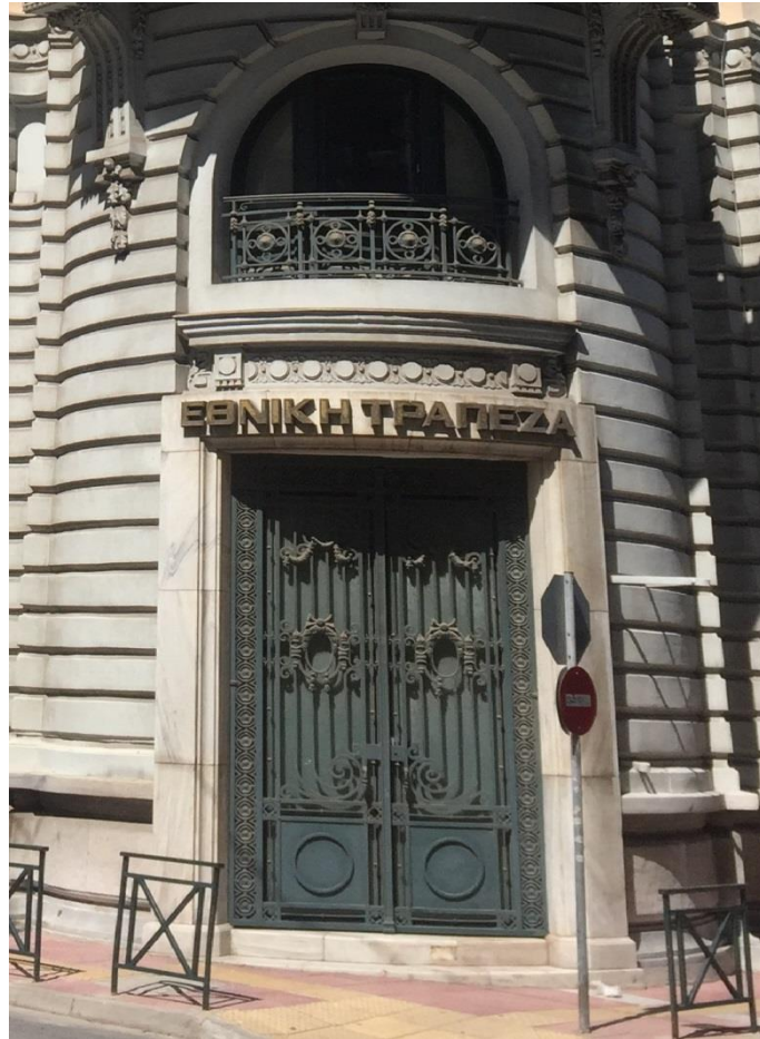
Εικ.72 : Λεπτομέρεια μεταλλικής εξώθυρας με χυτοσίδηρο και αμφίπλευρη λαμαρίνα
