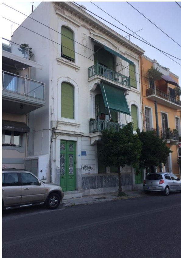
Εικ.59 : Κατοικία στην Λεωφόρο Παπαναστασίου 39 στην περιοχή της Καστέλας στον Πειραιά. Εκλεκτικισμός , Βάση-Κορμός-Στέψη
