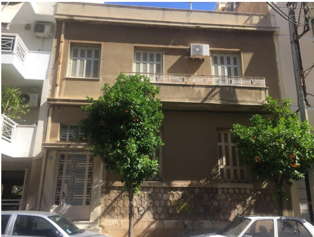
Εικ.41 : Διώροφη κατοικία στην οδό Πατριάρχου Ιωακείμ , Πειραιάς
