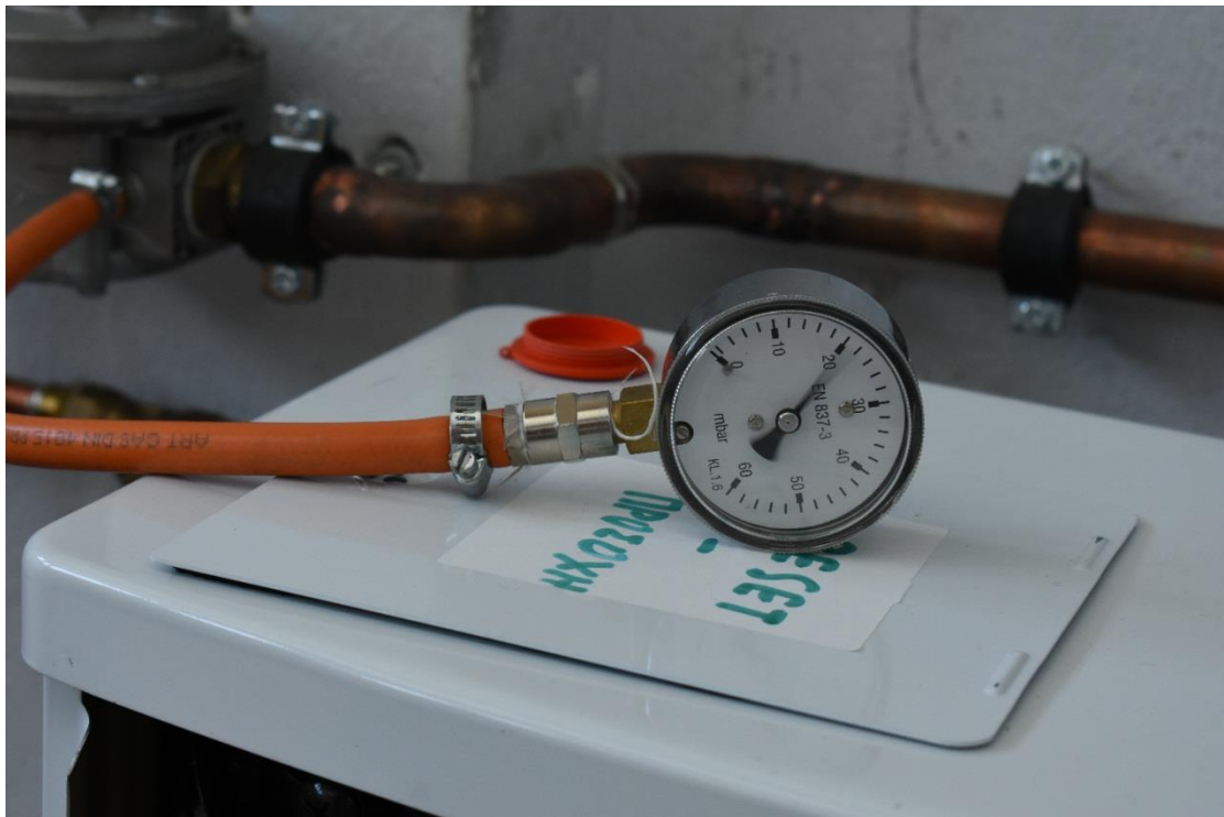
Εικόνα 24:Εγκατάσταση εργαστηρίου, μπαρόμετρο
