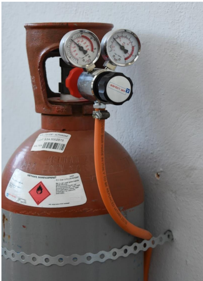
Εικόνα 21: Εγκατάσταση εργαστηρίου, φιάλη φυσικού αερίου
