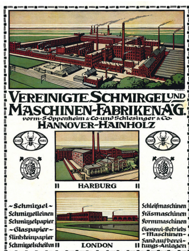
Εικ.216) Εργοστάσιο επεξεργασίας σμύριδας 1
