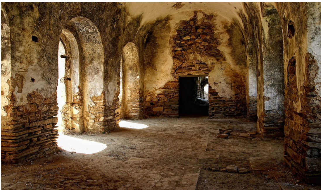
Εικ.33) παρατηρούμε ότι έχει χρησιμοποιηθεί για την κατασκευή του κτιρίου μεγάλη ποσότητα απο τοπικό σχιστόλιθο Νάξου για τις τοιχοποιίες, τους λαμπάδες, τα τόξα των κουφωμάτων, καθώς και τους θόλους
