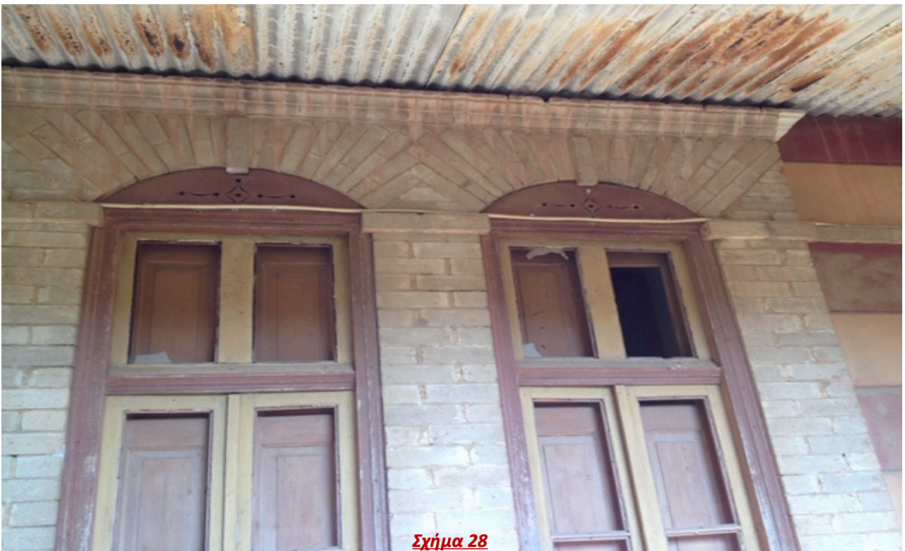
«Ξύλινα κουφώματα νότιας πλευράς» 22
