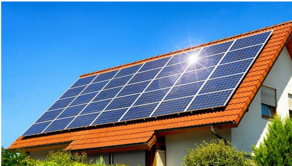
Εικόνα 1: Εγκατεστημένο solar panel σε σπίτι
